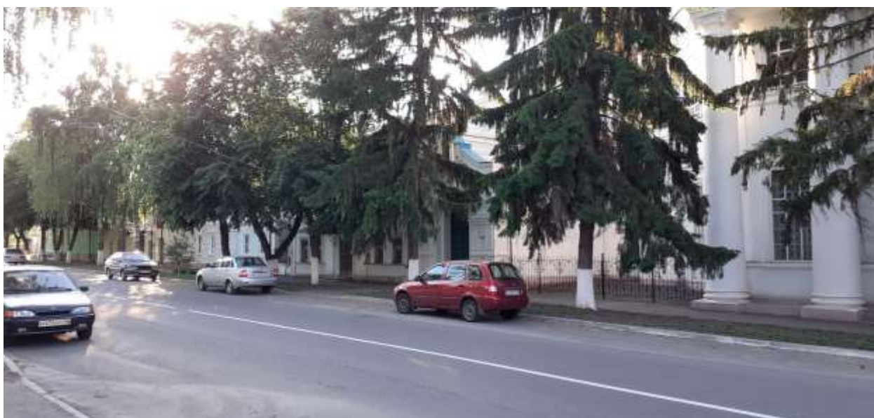
Фотография № 8. Вид с юго-востока на Объект.
