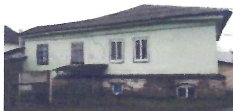
композиция юго-восточного фасада
