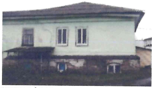
рамочные деревянные наличники прямоугольных оконных проемов; полуокна с лучковым завершением
