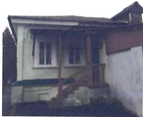
входная группа с крыльцом из каменных ступеней и деревянным ограждением; оконные проемы с «П»-образным профильным наличником
