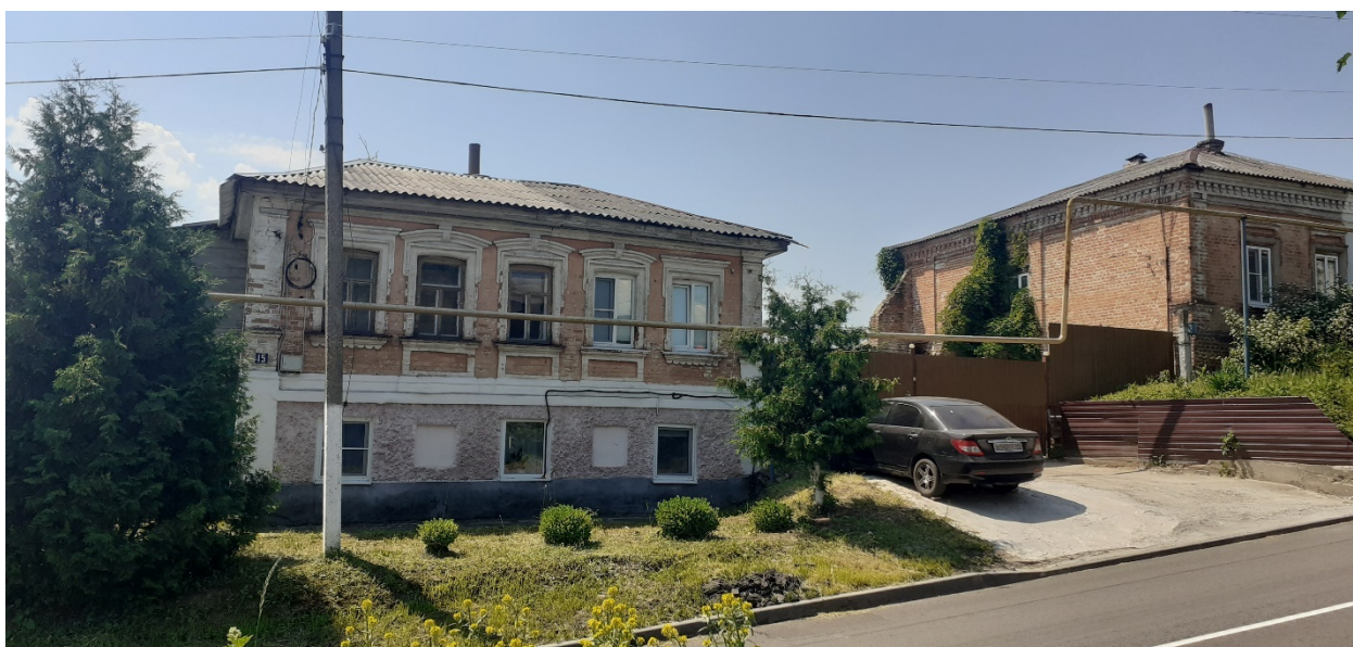
Фотография № 8. Вид с северо-востока на Объект.
