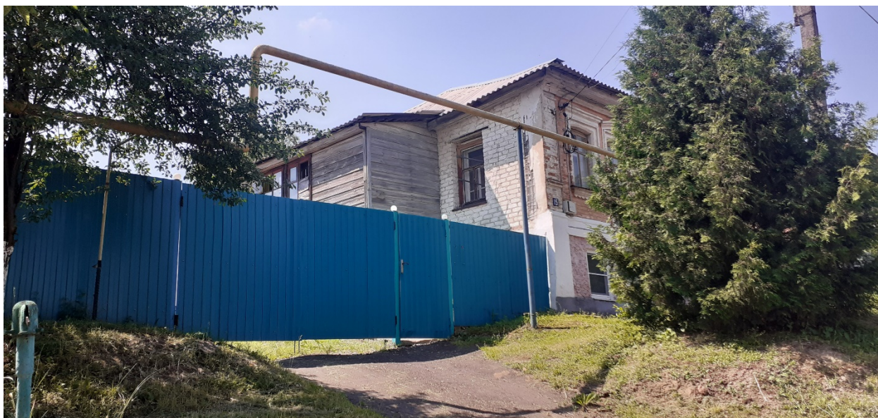
Фотография № 9. Вид с северо-востока на Объект.
