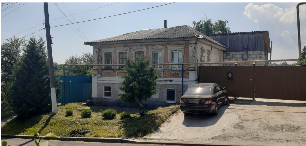
Фотография № 4. Вид с северо-запада на Объект.
