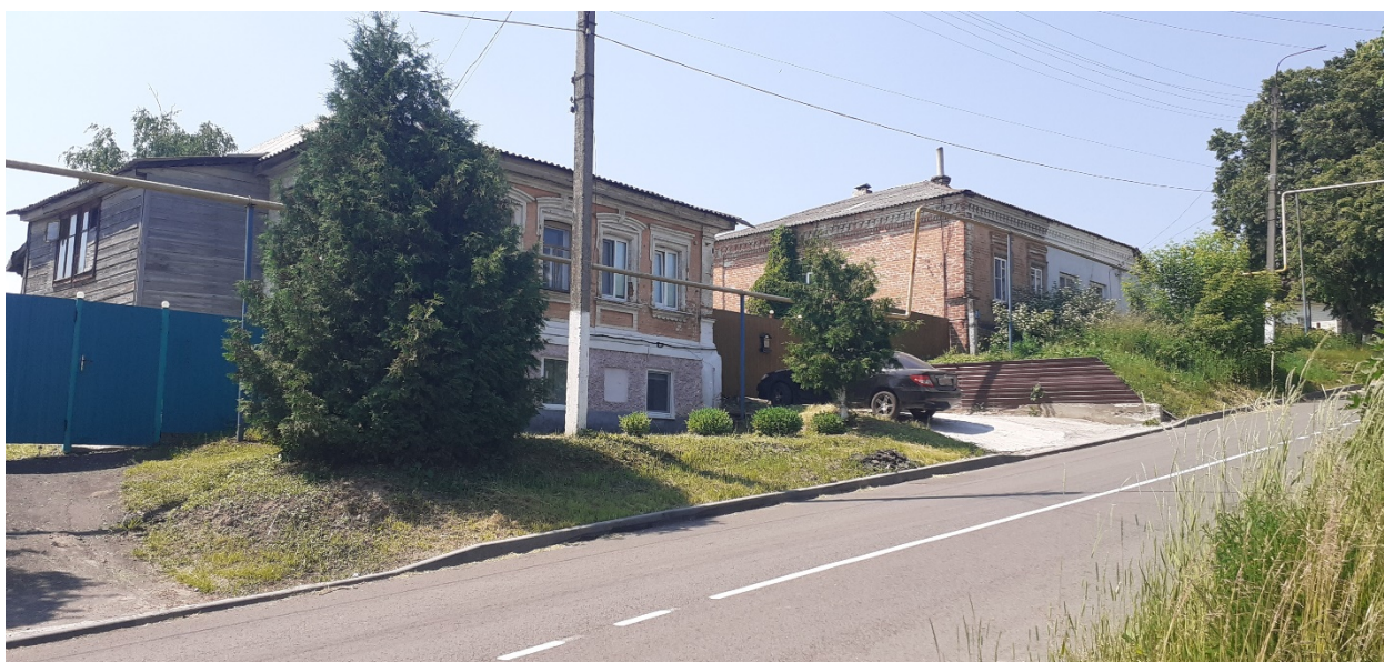
Фотография № 10. Вид с северо-востока на Объект.
