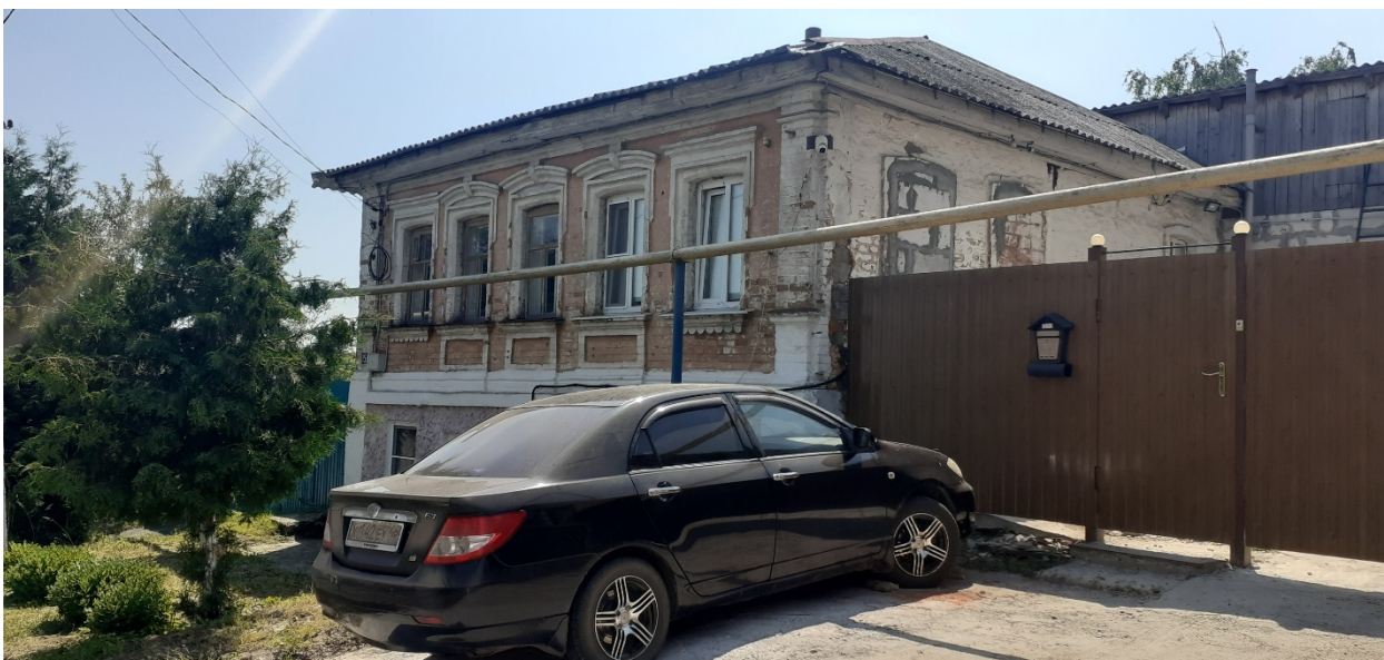
Фотография № 5. Вид с северо-запада на Объект.
