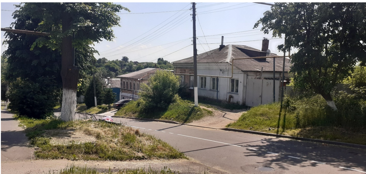
Фотография № 1. Вид с северо-запада на Объект.
