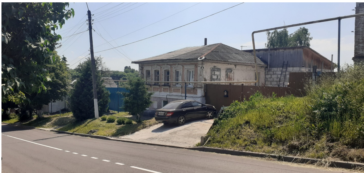
Фотография № 3. Вид с северо-запада на Объект.
