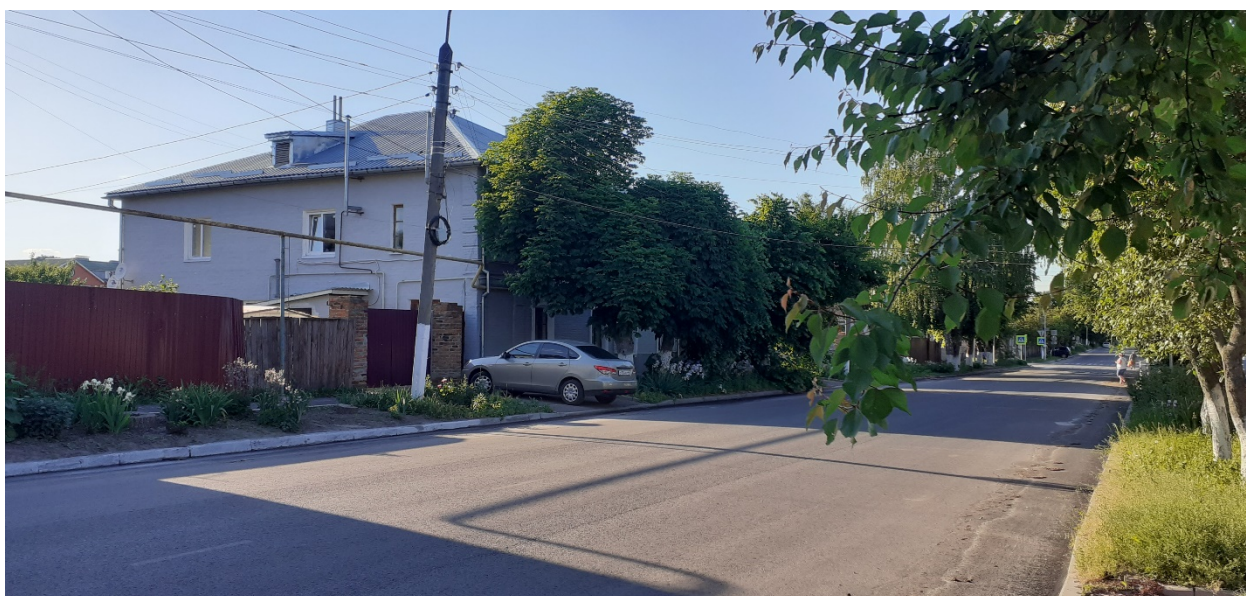
Фотография № 4. Вид с юго-востока на Объект.
