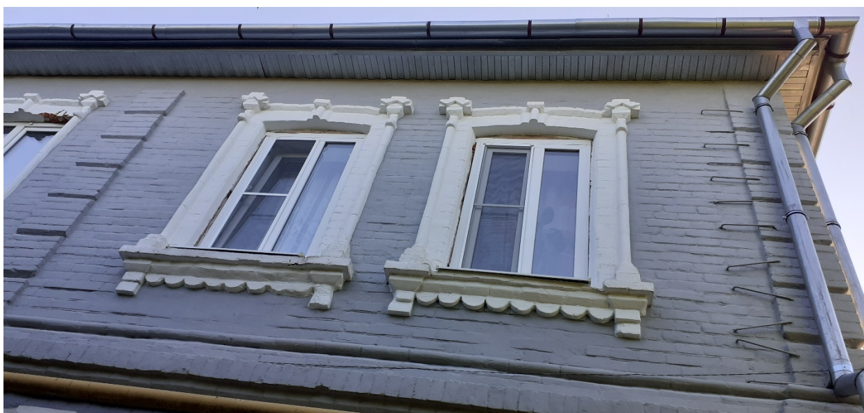
Фотография № 10. Вид с востока на Объект. Центральный (восточный) фасад. Фрагмент.
