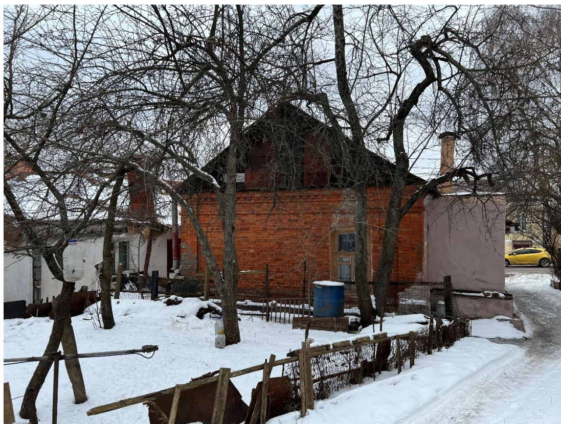
Фотография № 10. Вид с востока на Объект.
