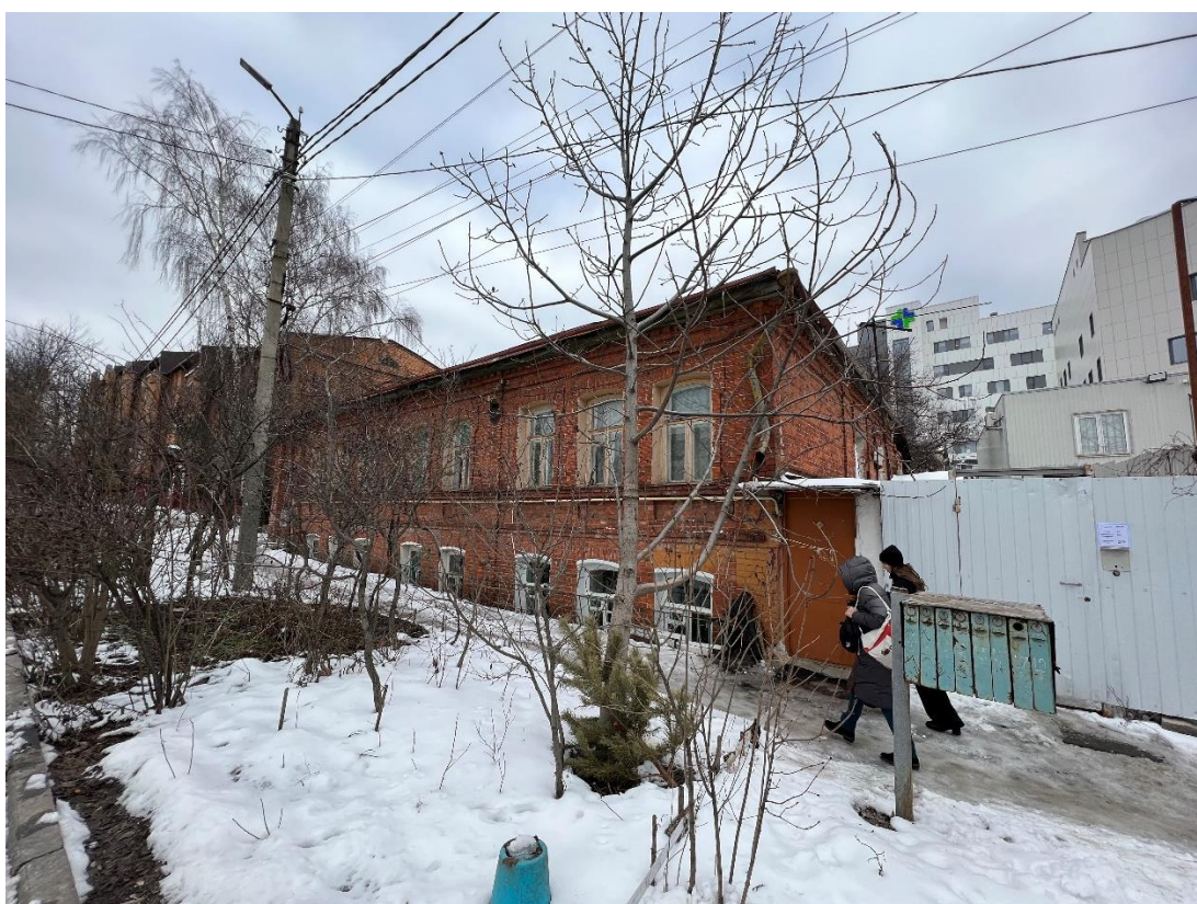
Фотография № 2. Вид с юго-запада на Объект.
