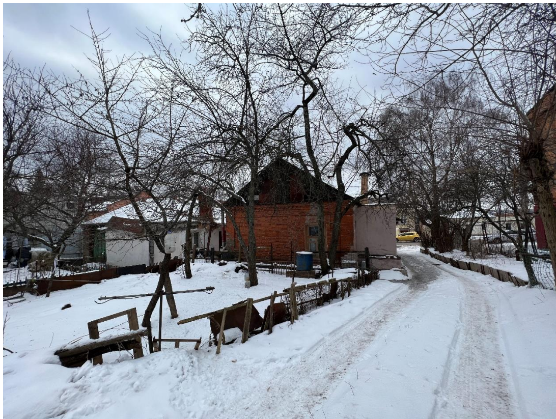
Фотография № 9. Вид с востока на Объект.
