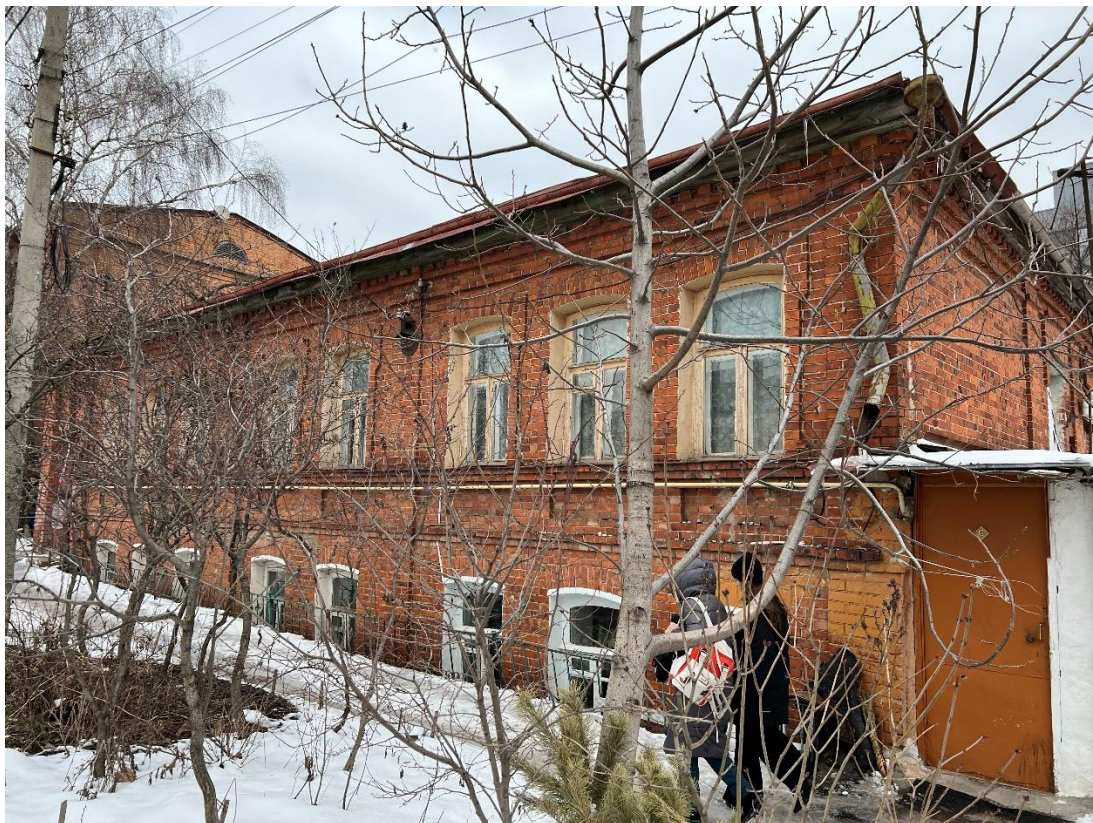
Фотография № 3. Вид с юго-запада на Объект.
