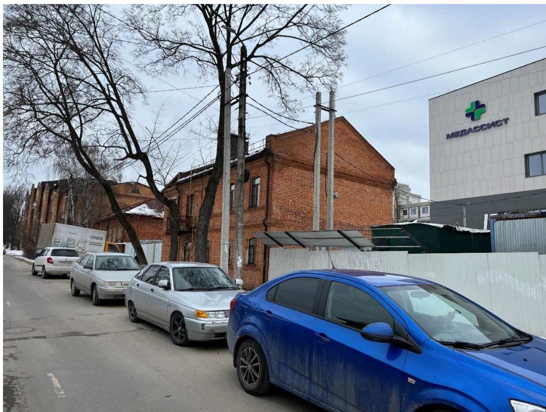
Фотография № 1. Вид с юго-запада на Объект.
