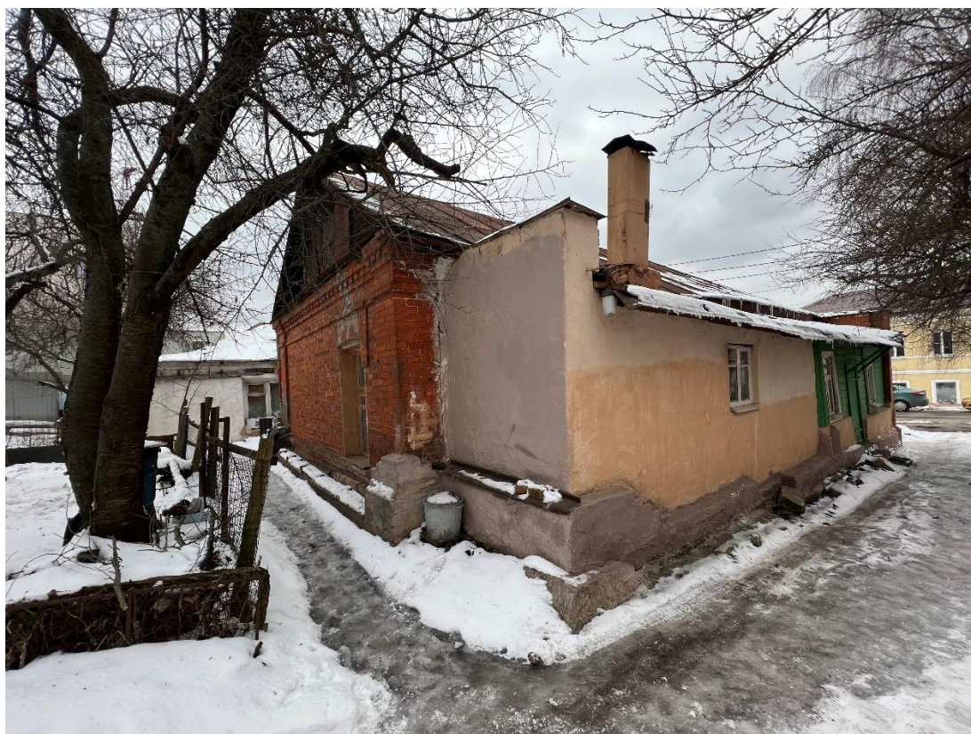
Фотография № 8. Вид с северо-востока на Объект.
