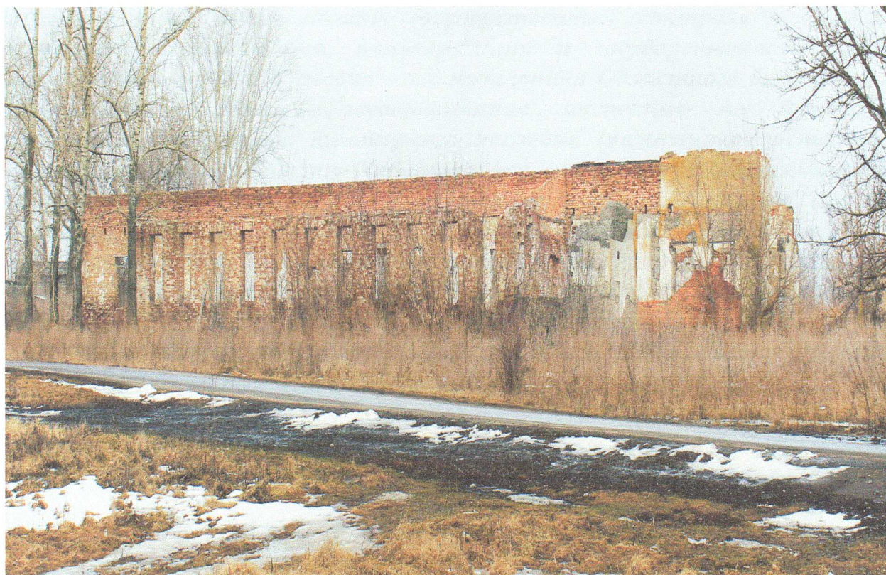
4. Ансамбль усадьбы помещика Алехина. Здание конюшни. Фотофиксация: март 2013
