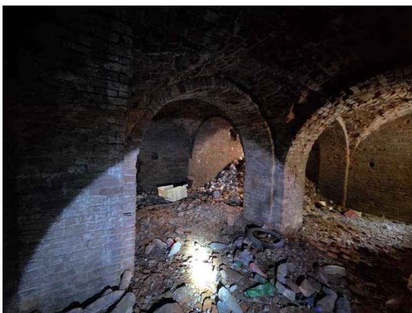
9. Вид с запада на восточную часть подвала.
