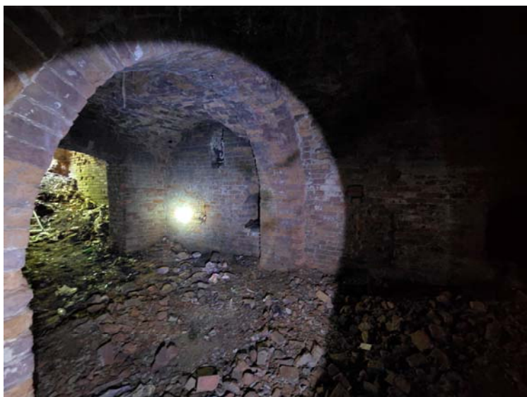
20. 21. Вид на входной проём и ниши в северо-западной части подвала.
