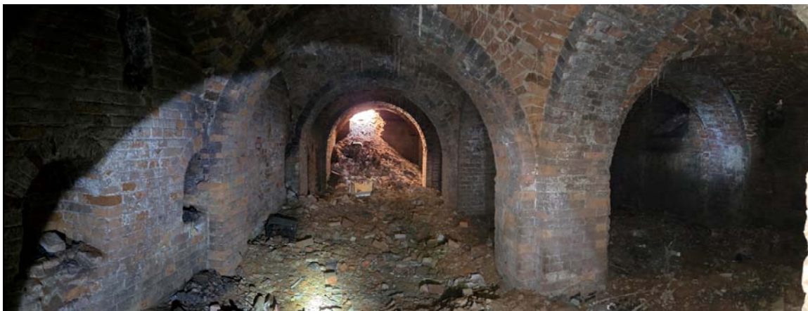
5. Вид с севера из центральной части подвала.
