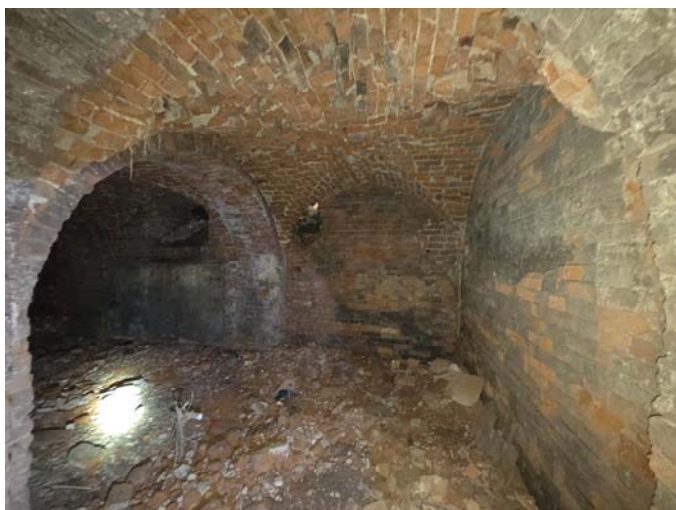
8. Вид с запада на южную галерею.
