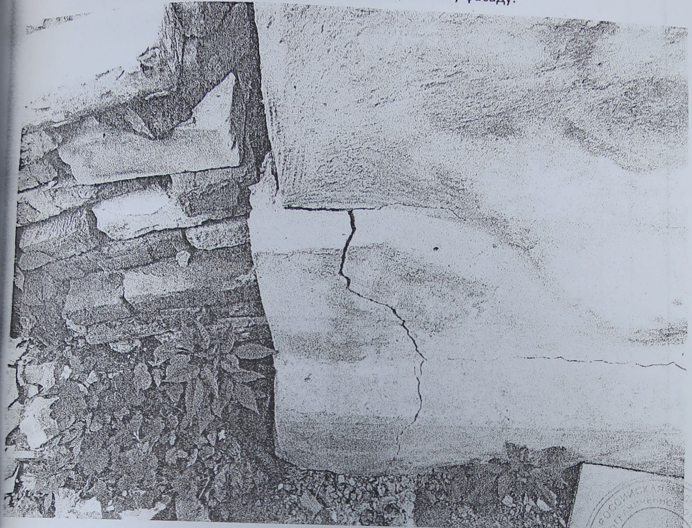
ФОТО 25. Угол (левый) по главному фасаду.
