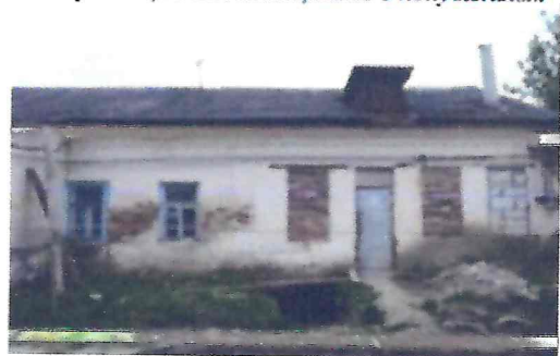
Композиция северного фасада. Два окна с клинчатыми перемычками
