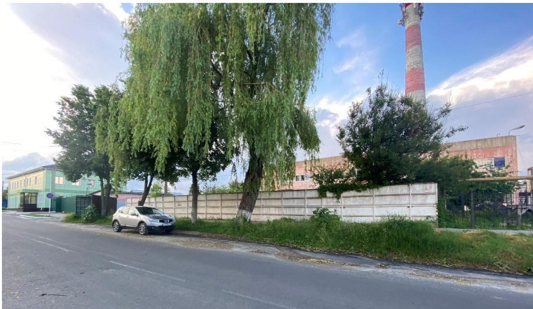
Фотография месторасположения Объекта – ул. Луначарского, 32 Вид с юго-востока. 23.05.2022 г. Автор: Е.М. Федосеева
