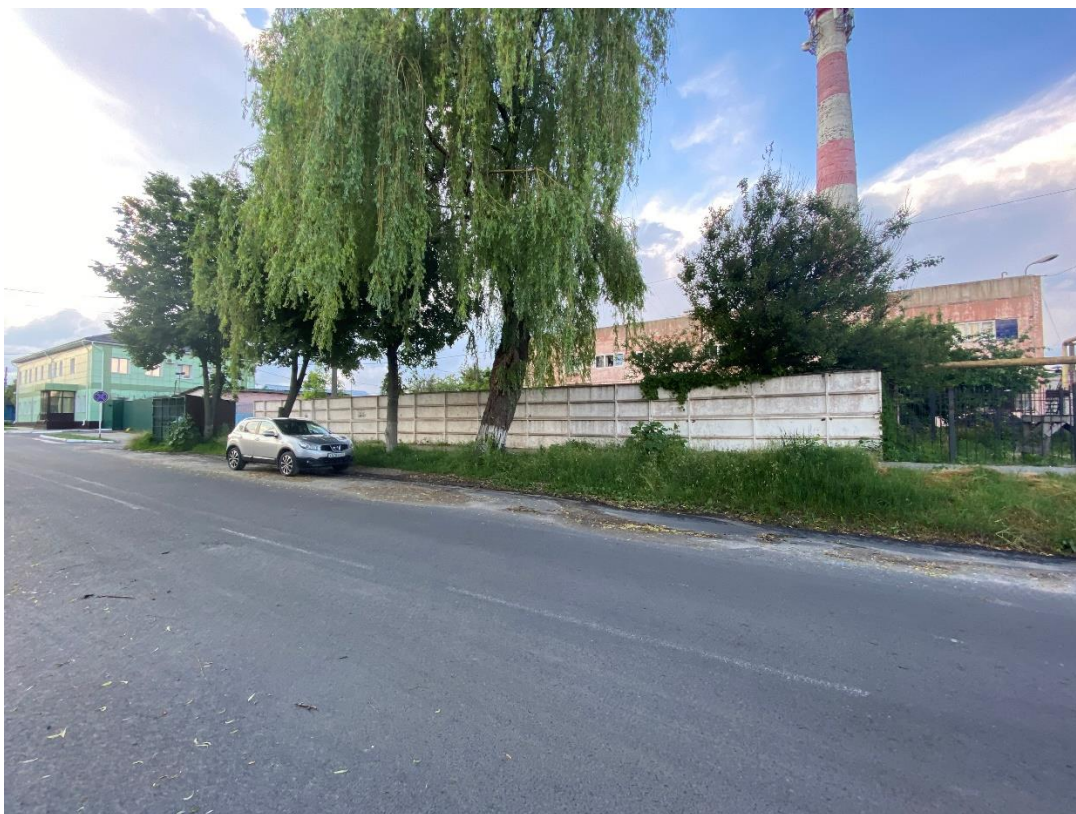
Фотография № 5. Вид с юго-востока на Объект.
