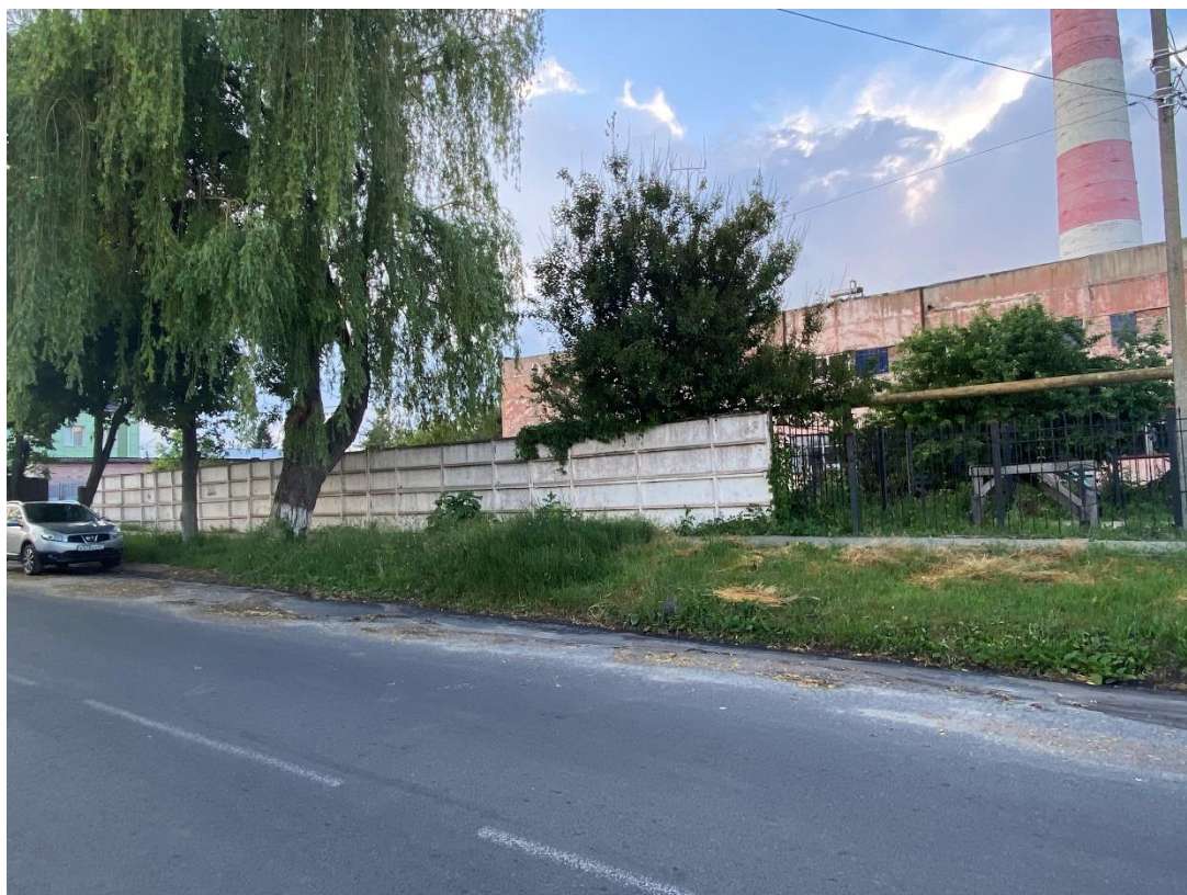
Фотография № 9. Вид с юго-востока на Объект.
