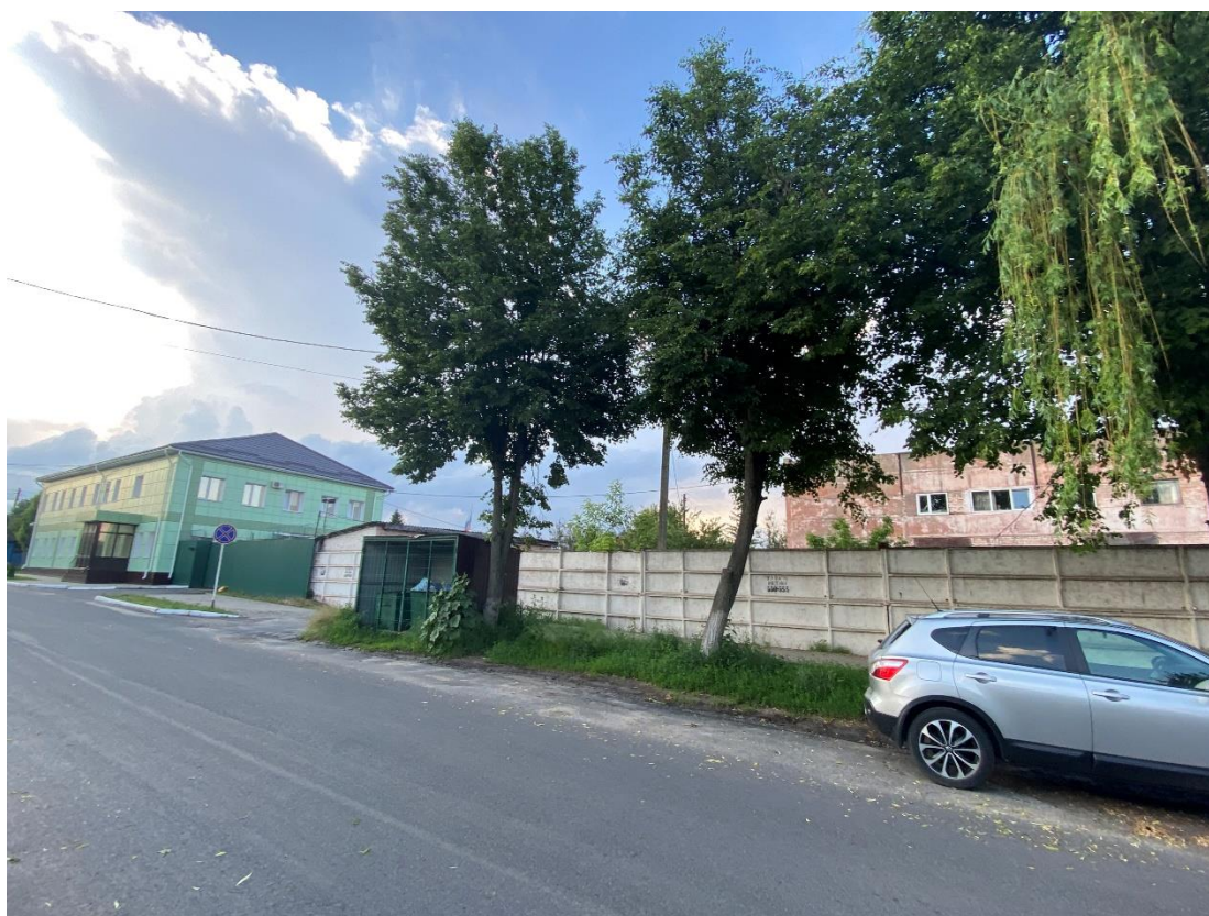
Фотография № 4. Вид с юго-востока на Объект.
