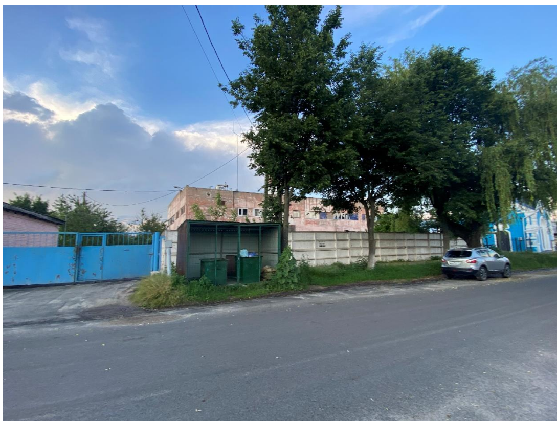
Фотография № 2. Вид с юго-запада на Объект.
