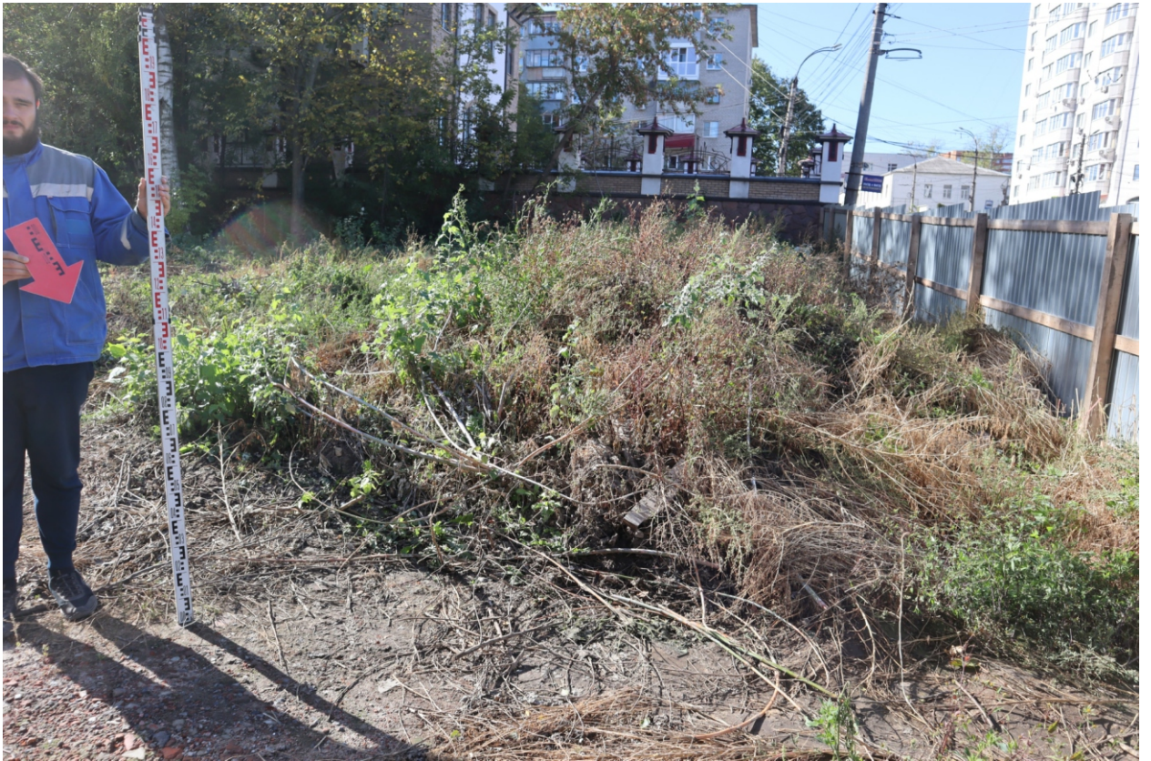
Рис. 18. Работы при реализации проекта на земельном участке с кадастровым номером 46:29:102257:54. г. Курск. 2023 г. Точка фотофиксации 4. Вид с СВ .
