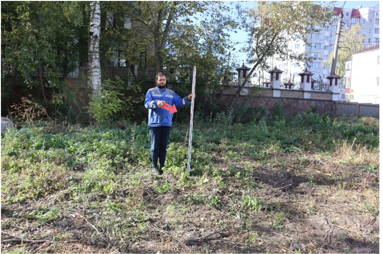
Рис. 14. Работы при реализации проекта на земельном участке с кадастровым номером 46:29:102257:54. г. Курск. 2023 г. Точка фотофиксации 2. Вид с СВ .
