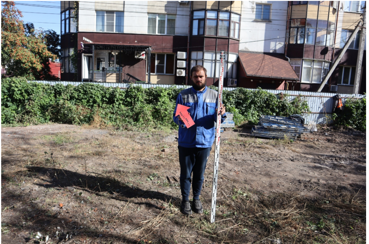
Рис. 12. Работы при реализации проекта на земельном участке с кадастровым номером 46:29:102257:54. г. Курск. 2023 г. Точка фотофиксации 2. Вид с ЮЗ.
