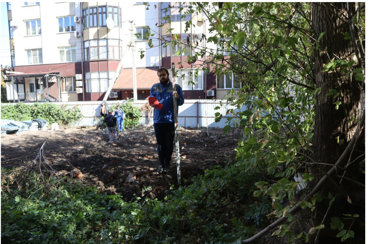
Рис. 11. Работы при реализации проекта на земельном участке с кадастровым номером 46:29:102257:54. г. Курск. 2023 г. Точка фотофиксации 1. Вид с ЮЗ.
