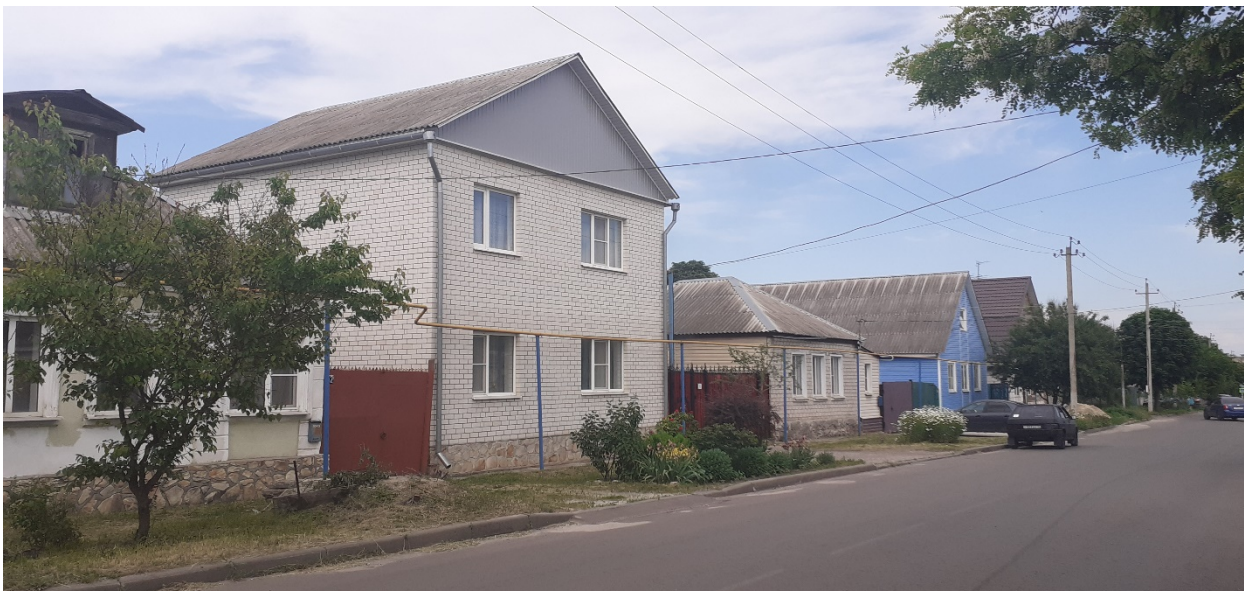
Фотография № 5. Вид с юго-запада.
