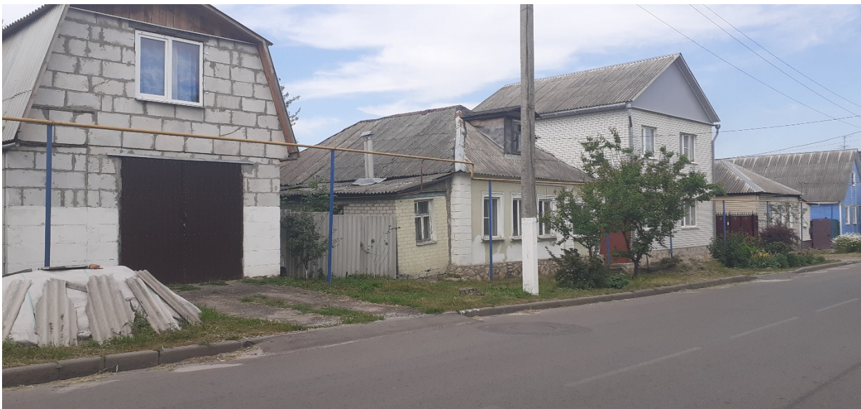
Фотография № 3. Вид с юго-запада.
