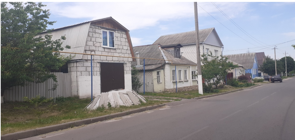
Фотография № 2. Вид с юго-запада.
