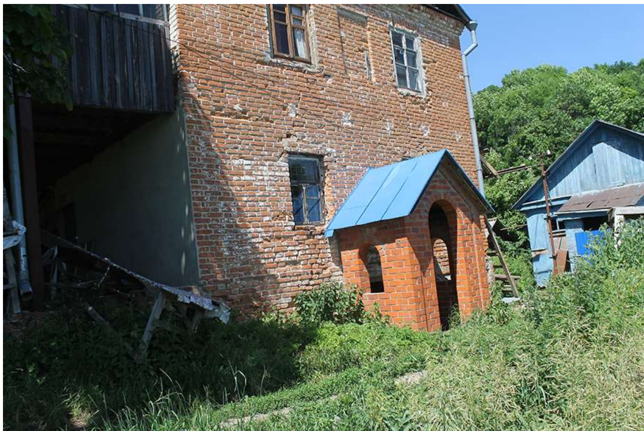
Т.ф. 5. Общий вид входной группы в здание
