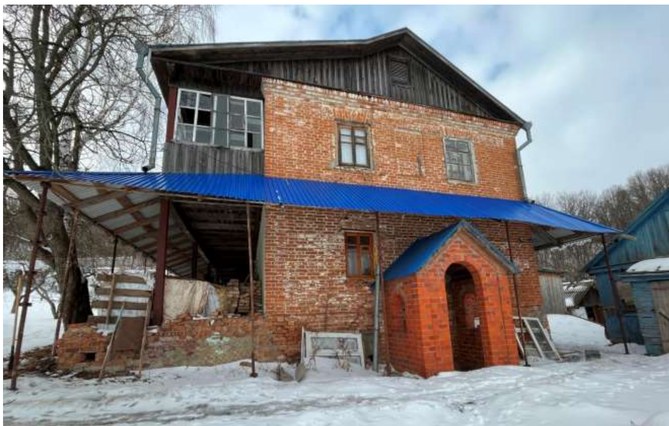
Т.ф. 6. Общий вид восточного фасада Объекта
