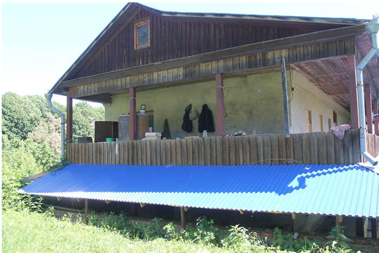
Т.ф. 3. Общий вид Объекта
