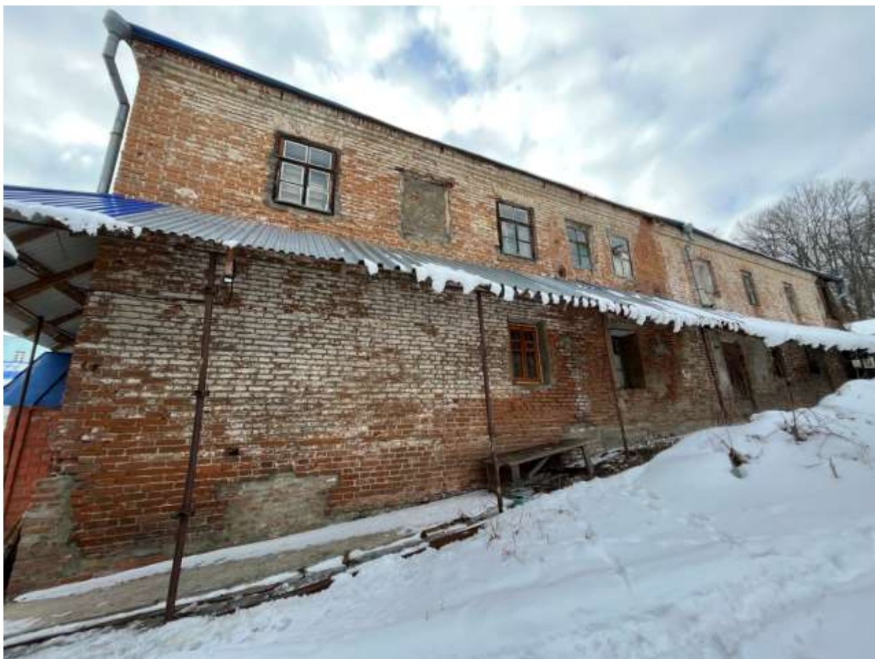
Т.ф. 5. Общий вид фрагмента северного фасада Объекта
