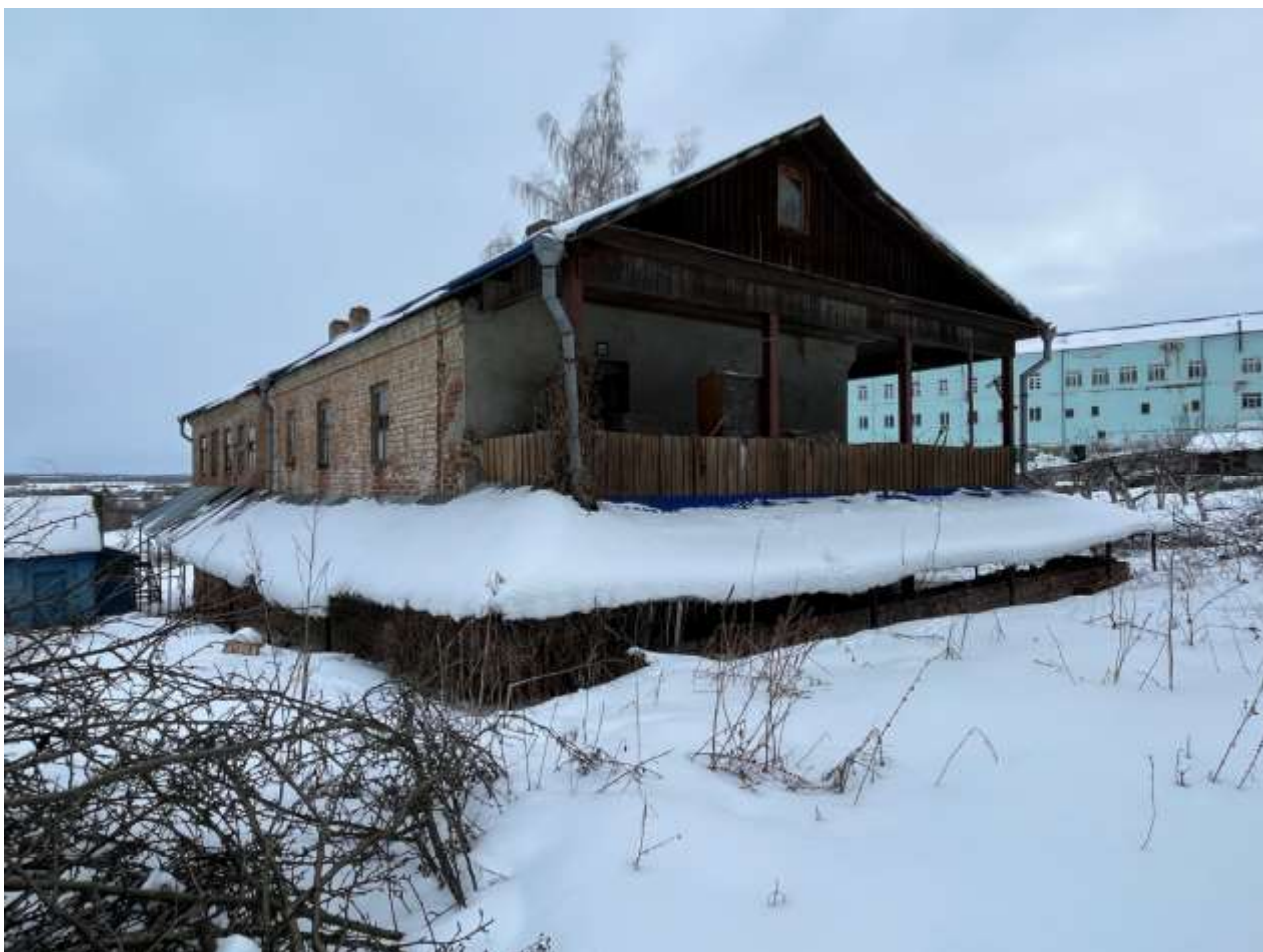
Т.ф. 3. Общий вид Объекта с северо-западной стороны
