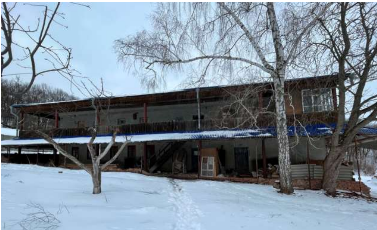
Т.ф. 1. Общий вид южного фасада Объекта
