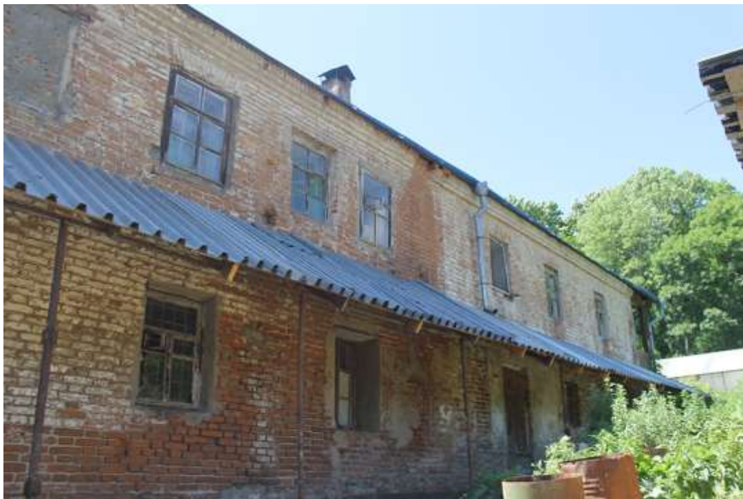
Т.ф. 1. Боковой фасад Объекта с металлическим навесом
