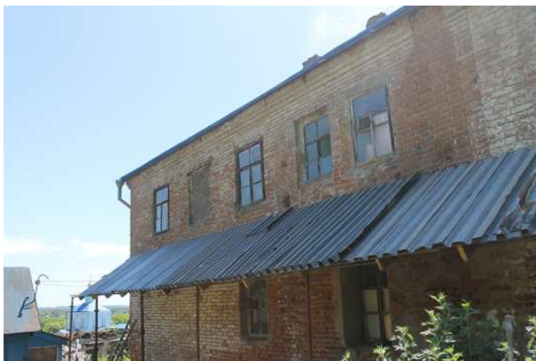
Т.ф. 2. Боковой фасад Объекта с металлическим навесом
