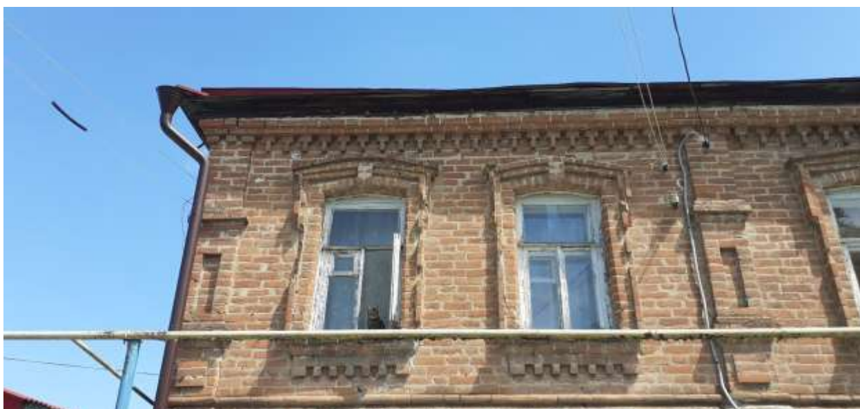
Фотография № 10. Вид с запада на Объект. Центральный (западный) фасад. Фрагмент.
