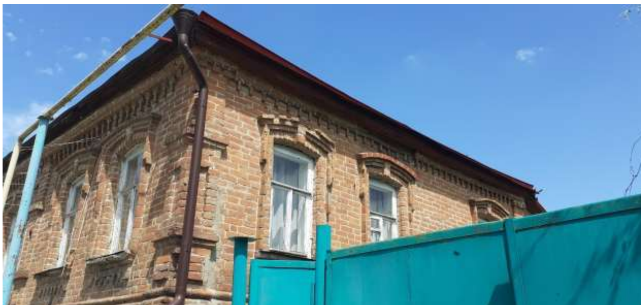
Фотография № 9. Вид с юго-запада на Объект. Угол центрального (западного) и южного фасадов. Фрагмент.
