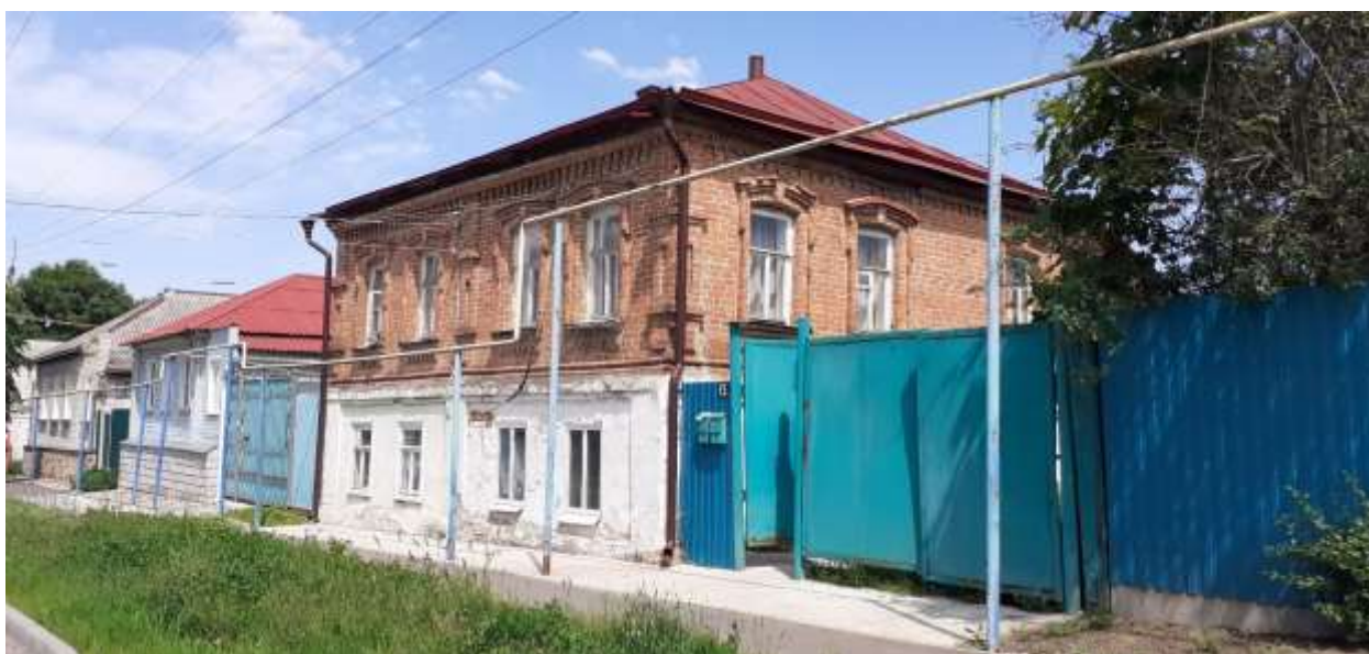
Фотография № 6. Вид с юго-запада на Объект.
