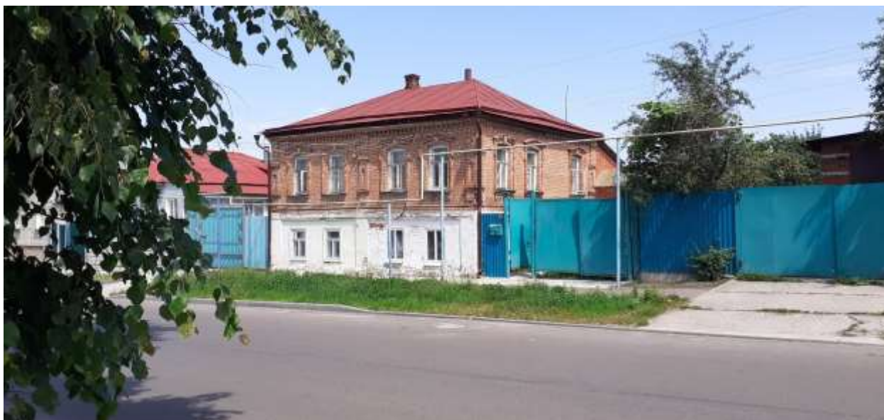
Фотография № 7. Вид с юго-запада на Объект.
