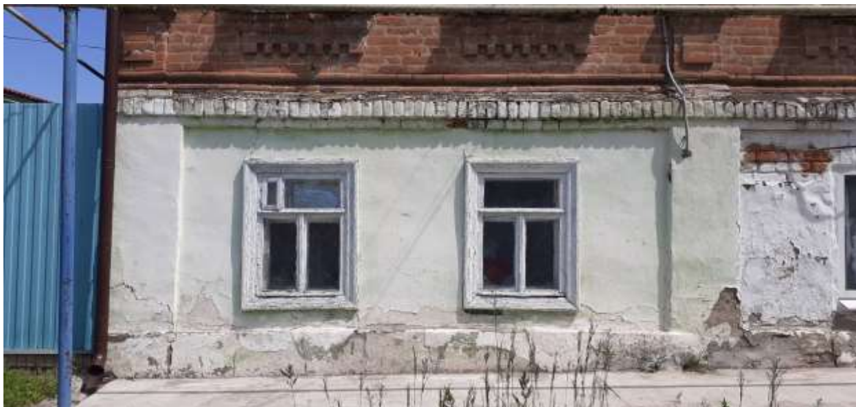
Фотография № 11. Вид с запада на Объект. Центральный (западный) фасад. Фрагмент.
