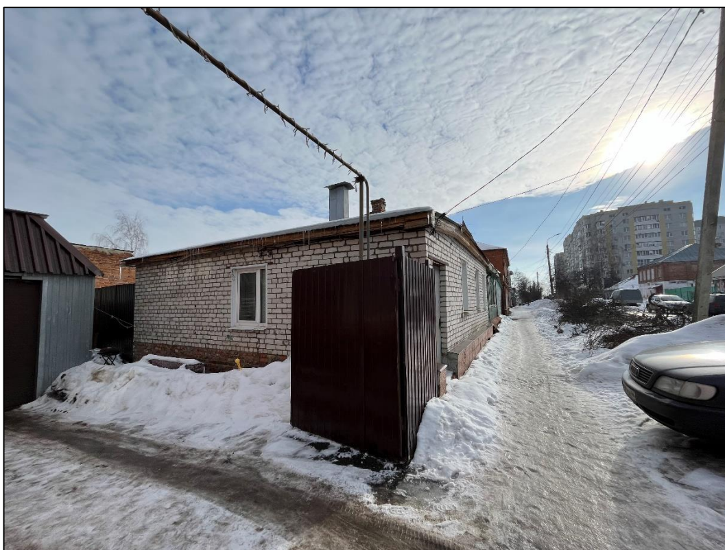
Т.ф.8. Общй вид на Объект с северо-запада
