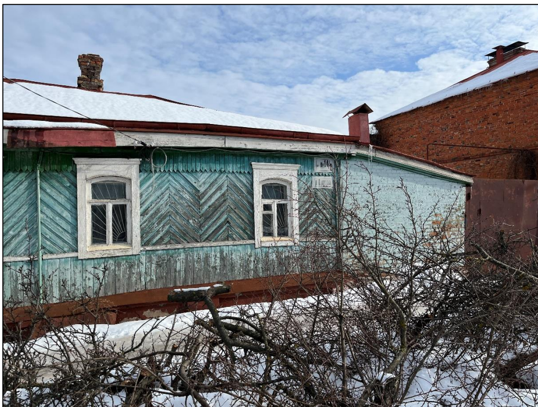
Т.ф.4. Общий вид на Объект с запада
