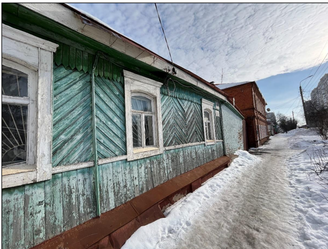
Т.ф.7. Общй вид на Объект с северо-запада
