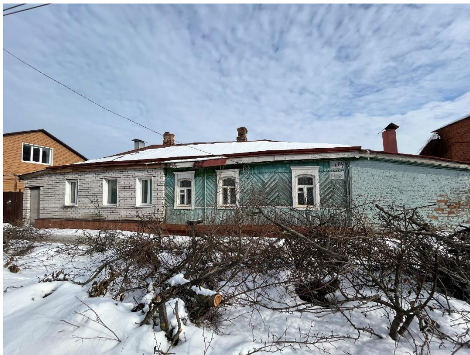
Фотография территории месторасположения Объекта – г. Курск, ул. Дружининская, 14 Вид с юго-запада. Декабрь 2024 г.
