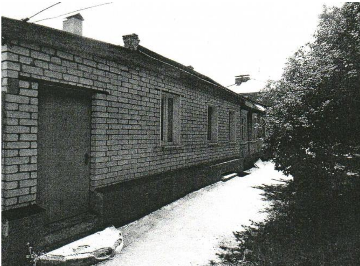
27. Главный фасад здания Объекта. Период создания: 2019 г. Источник: Акт натурального визуального обследования и фотофиксации объекта культурного наследия «Дом жилой, кон. XIX – нач. XX вв.», расположенного по адресу: Курская область, г. Курск, ул. Дружининская, 14 от 15.05.2019 № 27.
