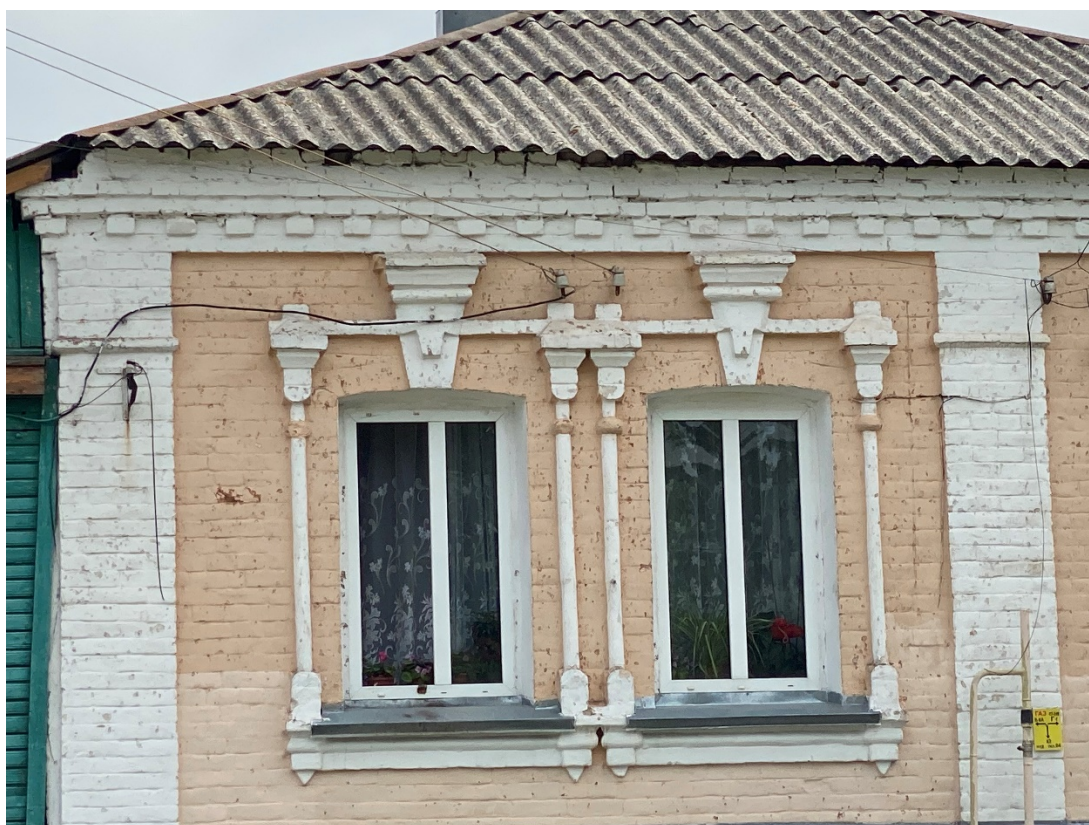
Фотография № 10. Вид с севера на Объект. Центральный фасад. Фрагмент.
