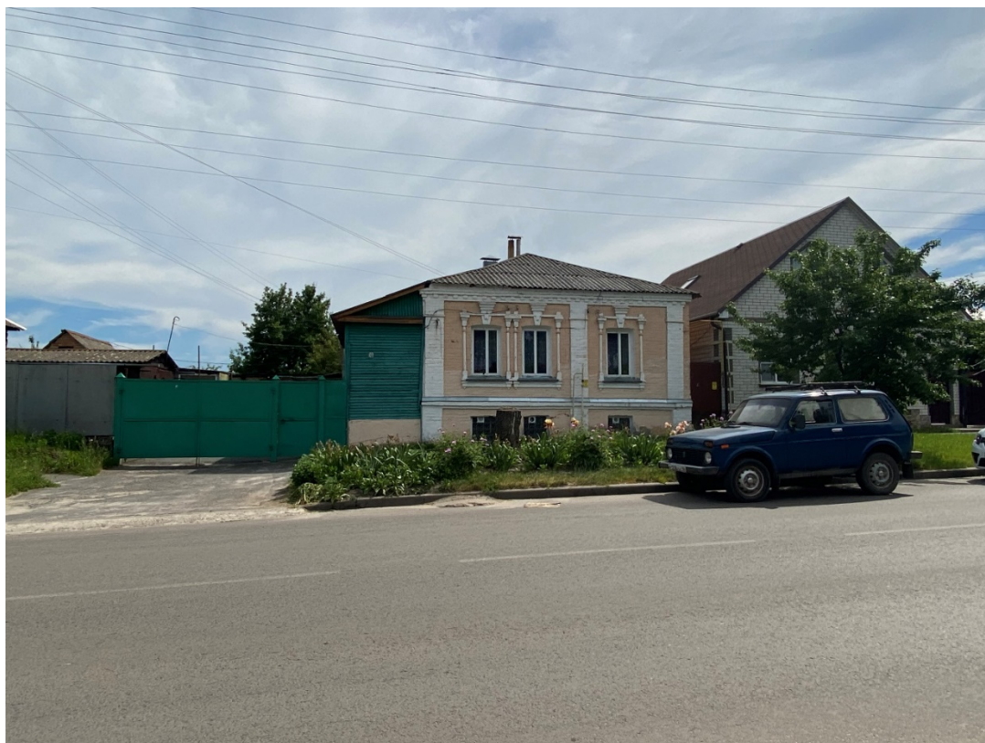
Фотография № 5. Вид с севера на Объект.
