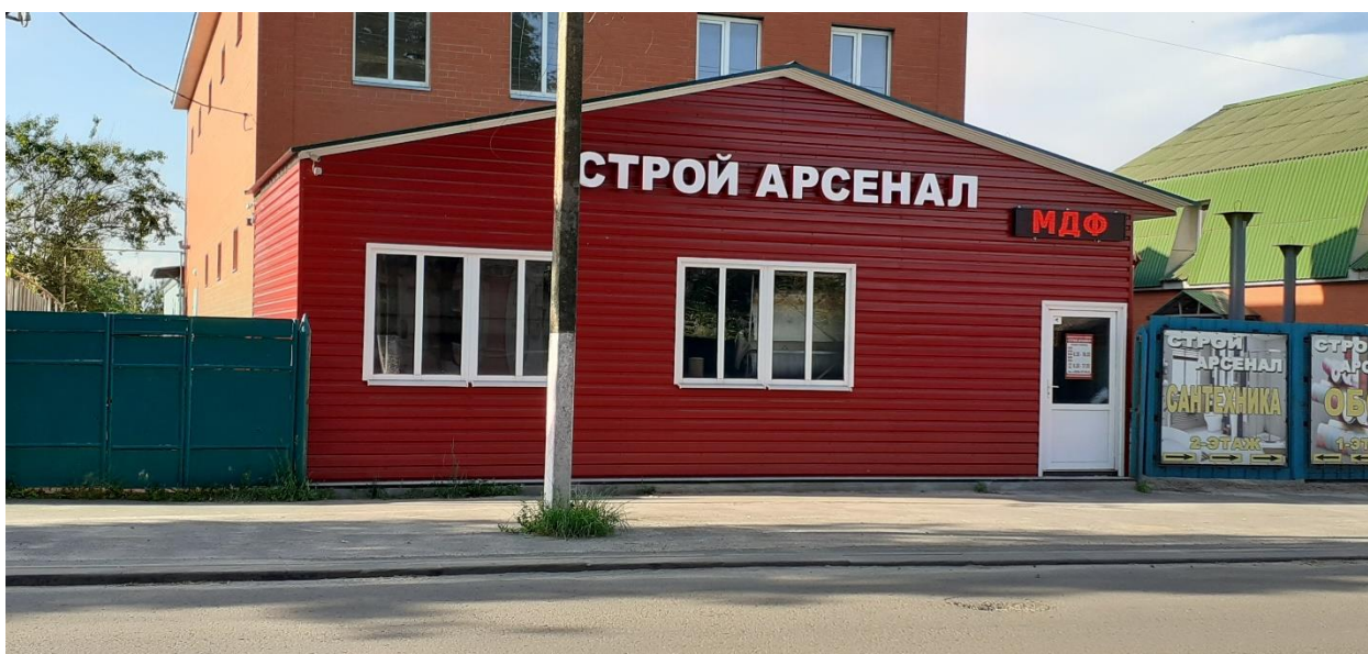
Фотография № 10. Вид с юга на Объект. Центральный (южный) фасад. Фрагмент.
