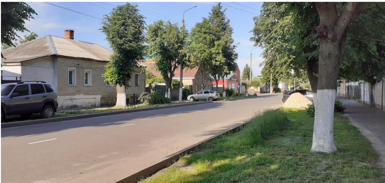
Фотография № 9. Вид с юго-запада на Объект.
