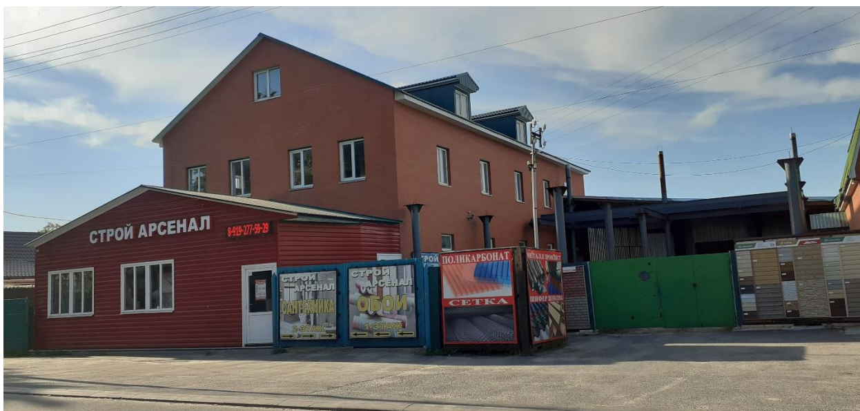
Фотография № 2. Вид с юго-востока на Объект.
