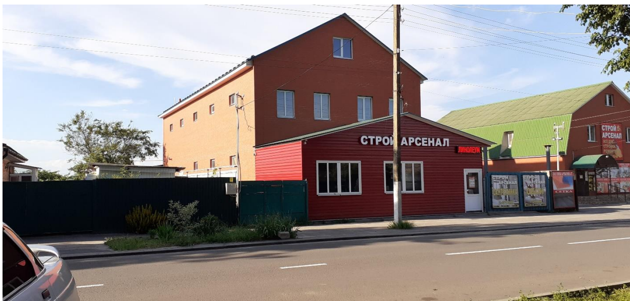
Фотография № 6. Вид с юго-запада на Объект.
