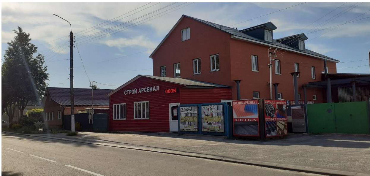
Фотография № 1. Вид с юго-востока на Объект.
