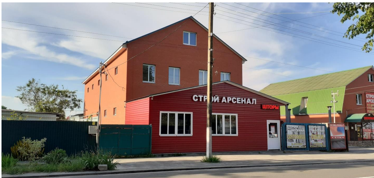
Фотография № 5. Вид с юго-запада на Объект.
