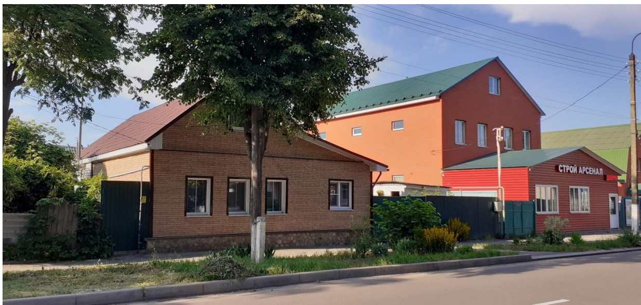
Фотография № 7. Вид с юго-запада на Объект.
