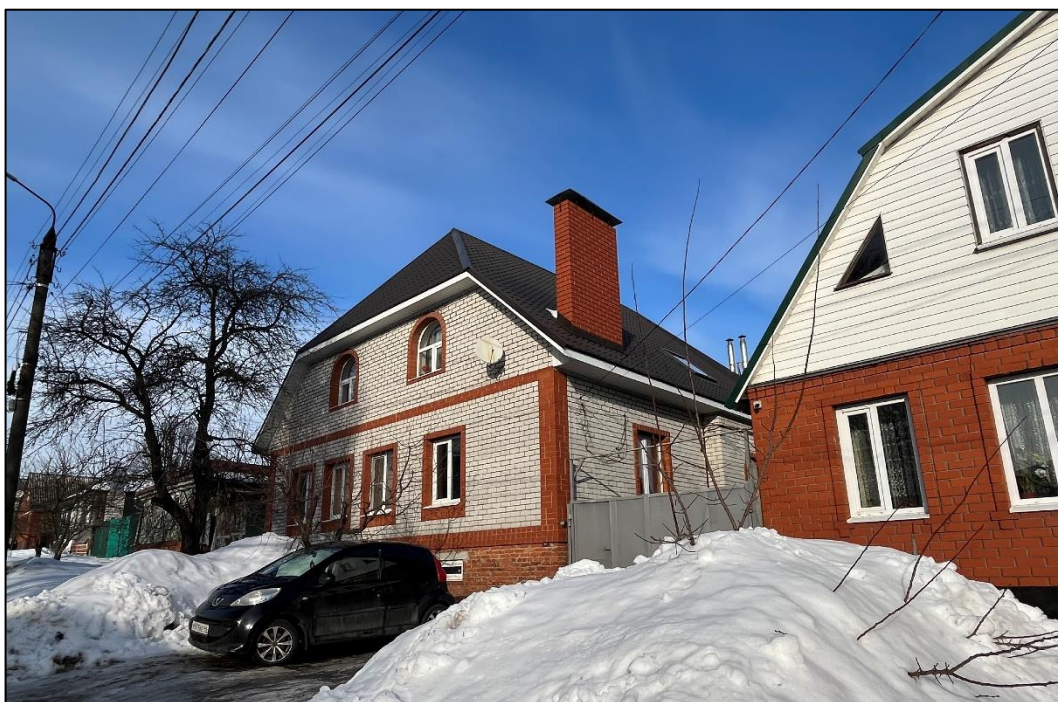
Т.ф.8. Общий вид на Объект с юго-запада
