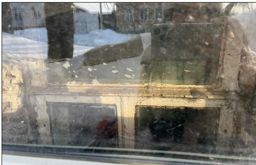
Т.ф.10. Вид на фрагмент Об'єкта с юго-запада
