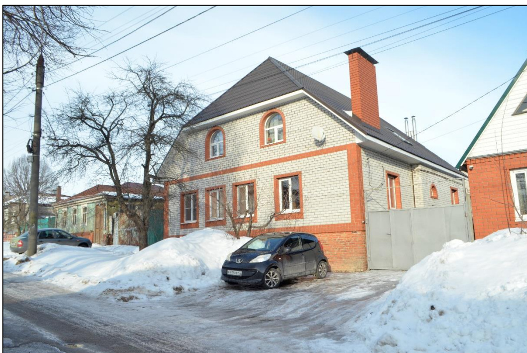
Т.ф.4. Общий вид на Объект с юго-запада
