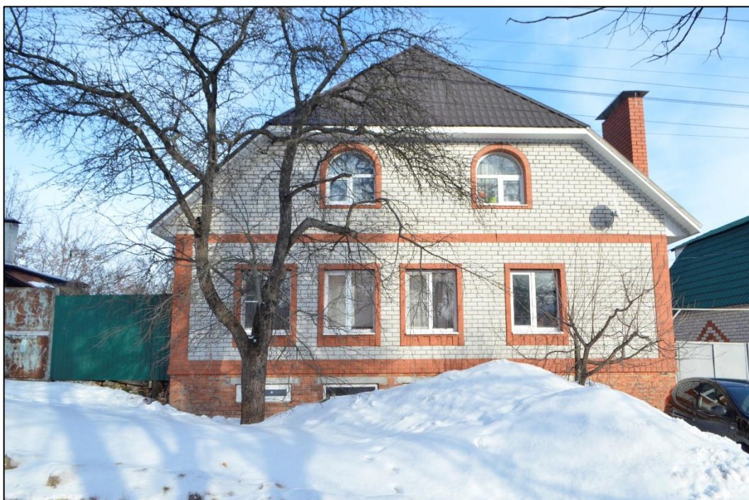
Т.ф.2. Общий вид на Объект с юго-запада
