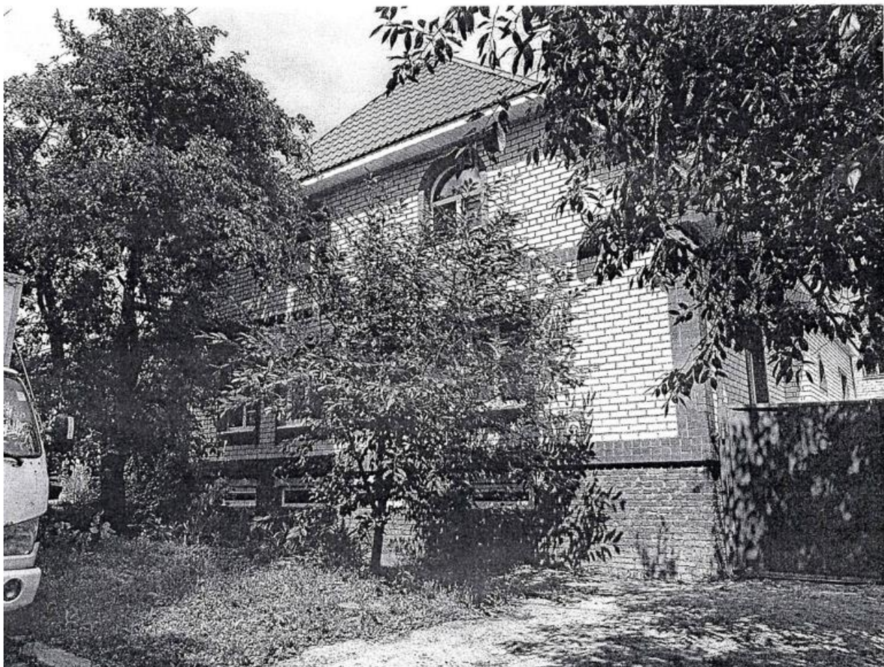
25. Главный фасад здания Объекта. Период создания: 2018 г. Источник: Акт проведения осмотра выявленного объекта культурного наследия «Дом жилой, кон. XIX – нач. XX вв.», расположенного по адресу: Курская область, г. Курск, улица Рассыльная, 26 от 13 июля 2018 г. № 354.
