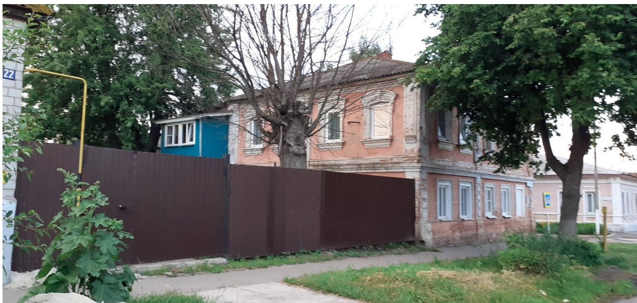
Фотография № 9. Вид с юго-запада на Объект.
