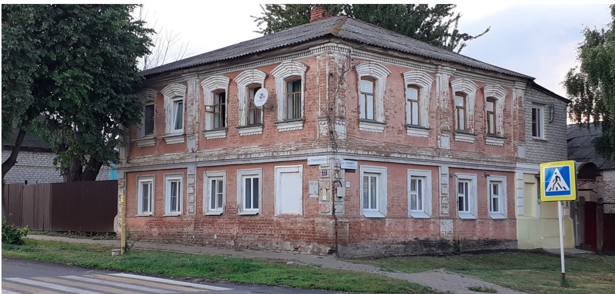
Фотография № 8. Вид с юго-востока на Объект.
