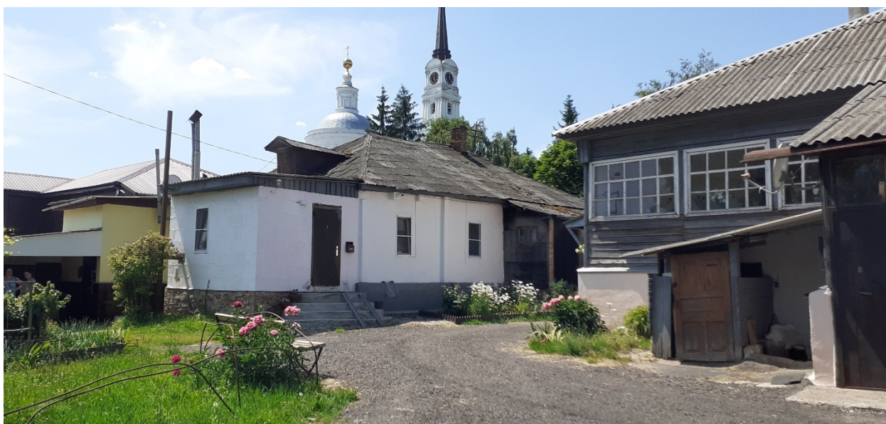
Фотография № 8. Вид с северо-востока на Объект.
