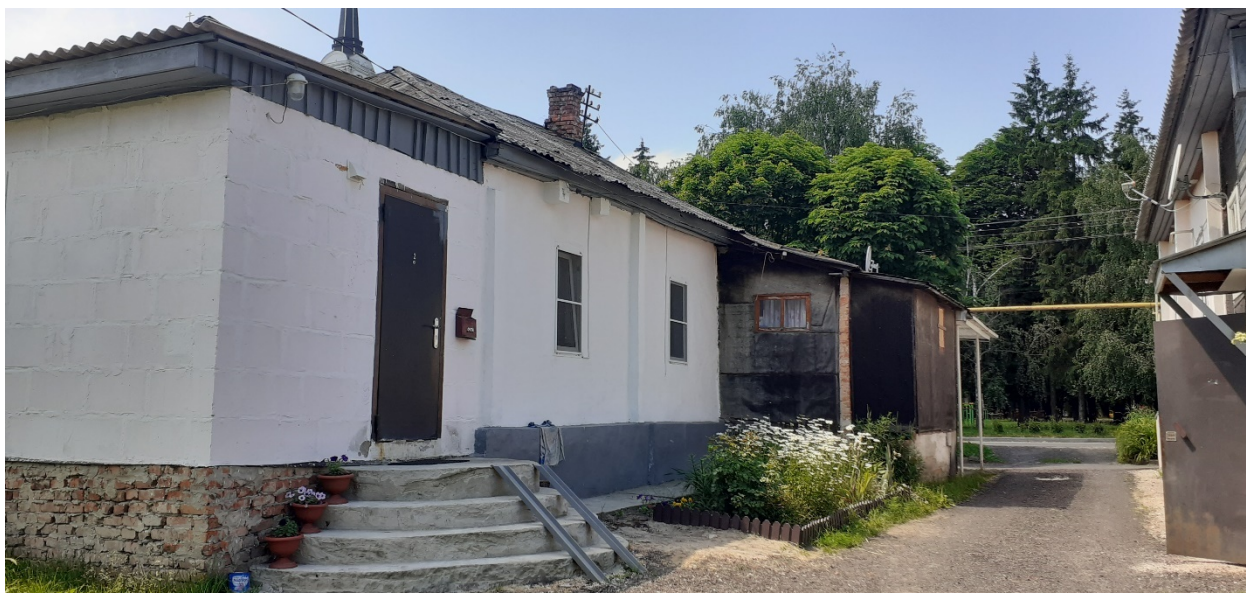
Фотография № 9. Вид с востока на Объект.
