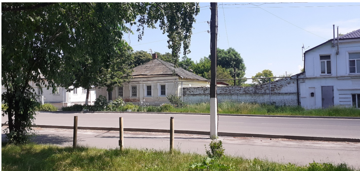
Фотография № 3. Вид с юго-запада на Объект.
