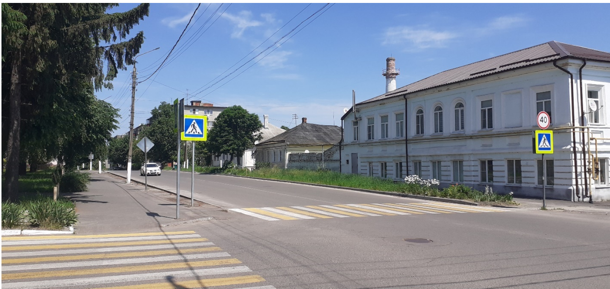
Фотография № 1. Вид с юго-запада на Объект.
