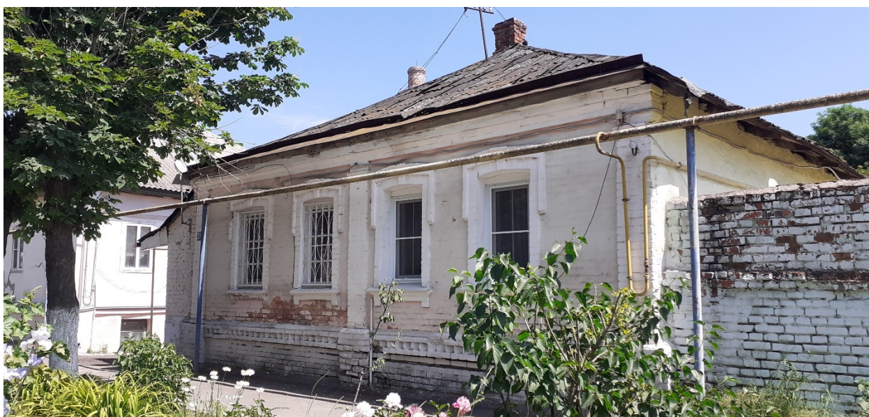
Фотография № 4. Вид с юго-запада на Объект.
