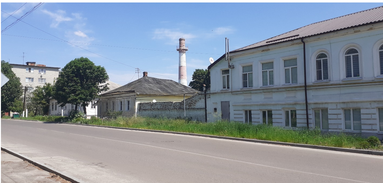
Фотография № 2. Вид с юго-запада на Объект.
