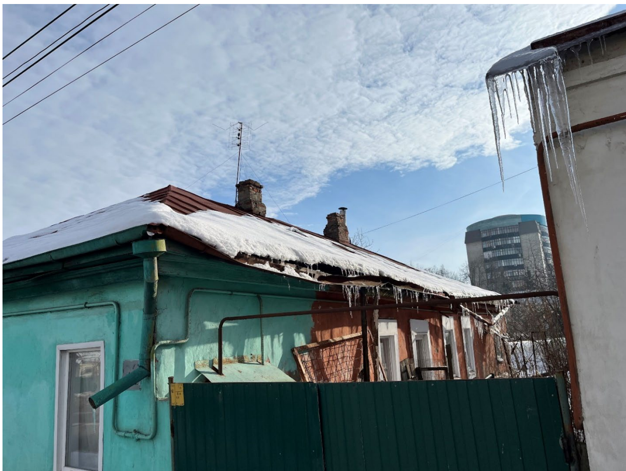
Т.ф. 3. Вид с запада на боковой фасад Объекта
