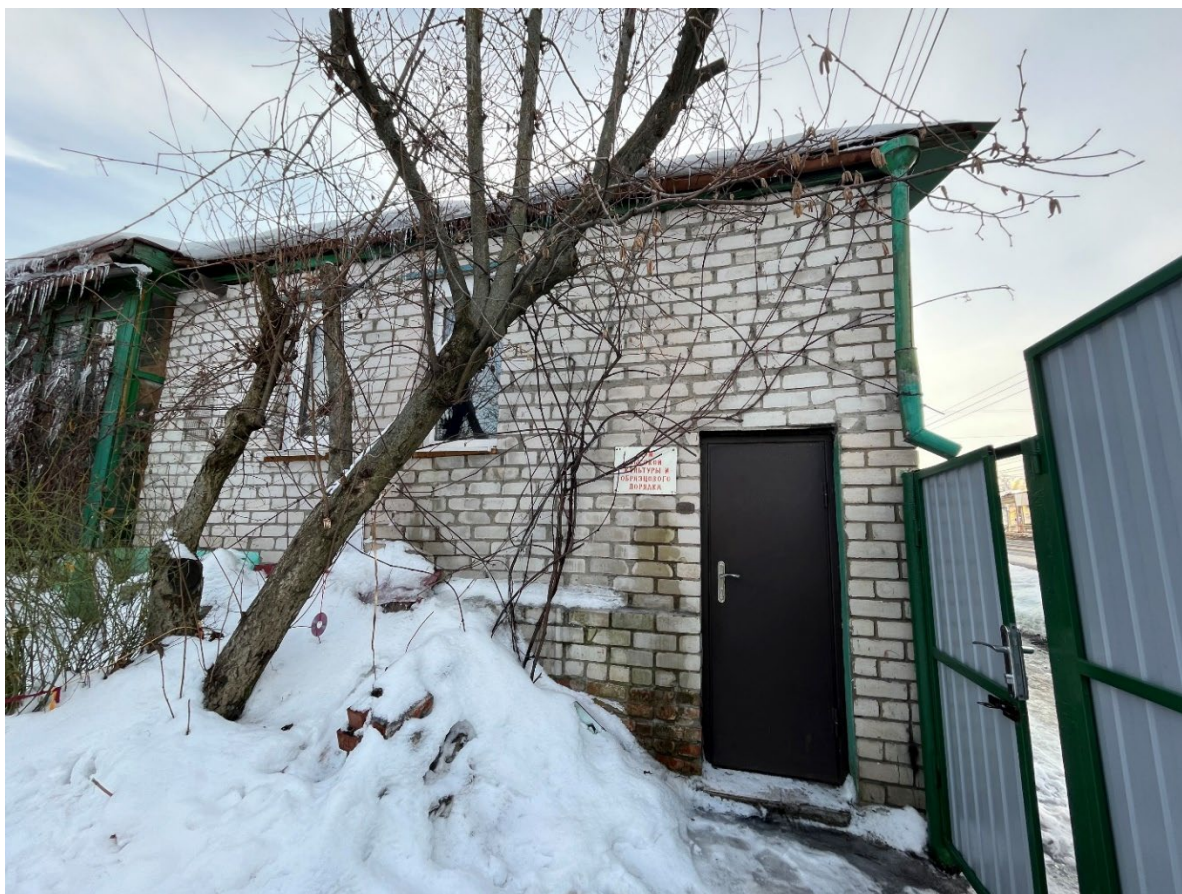
Т.ф. 17. Вид с северо-востока на кирпичную пристройку к боковому фасаду Объекта
