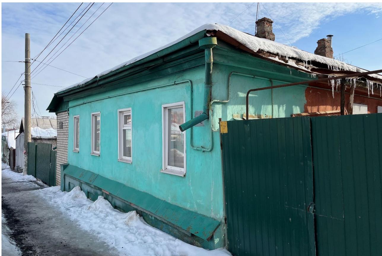
Т.ф. 7. Вид с запада на главный и боковой фасады Объекта
