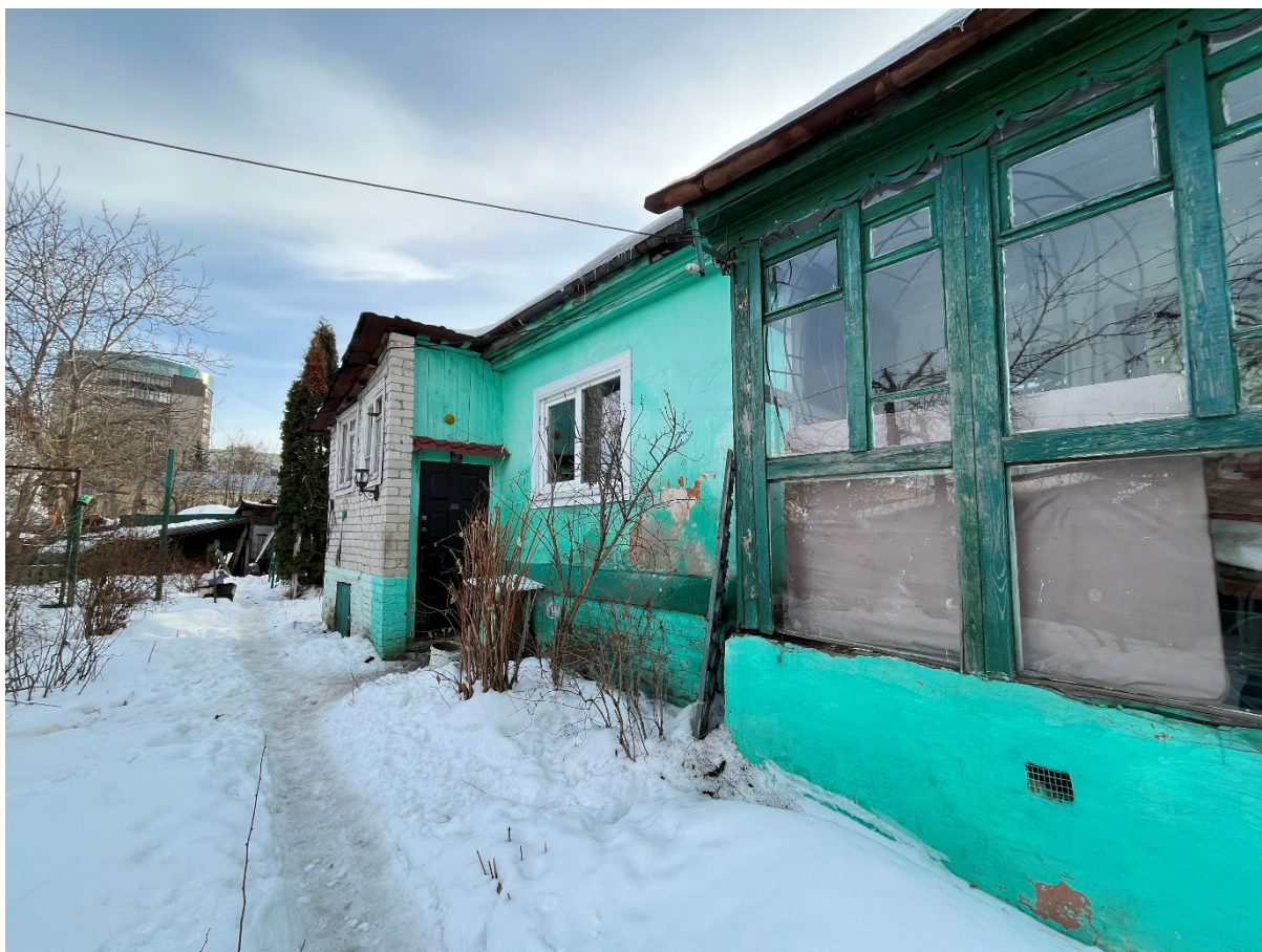
Т.ф. 13. Вид с севера на северо-восточный фасад Объекта
