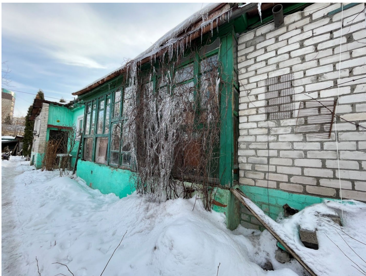
Т.ф. 16. Вид с севера на боковой фасад Объекта с поздними пристройками
