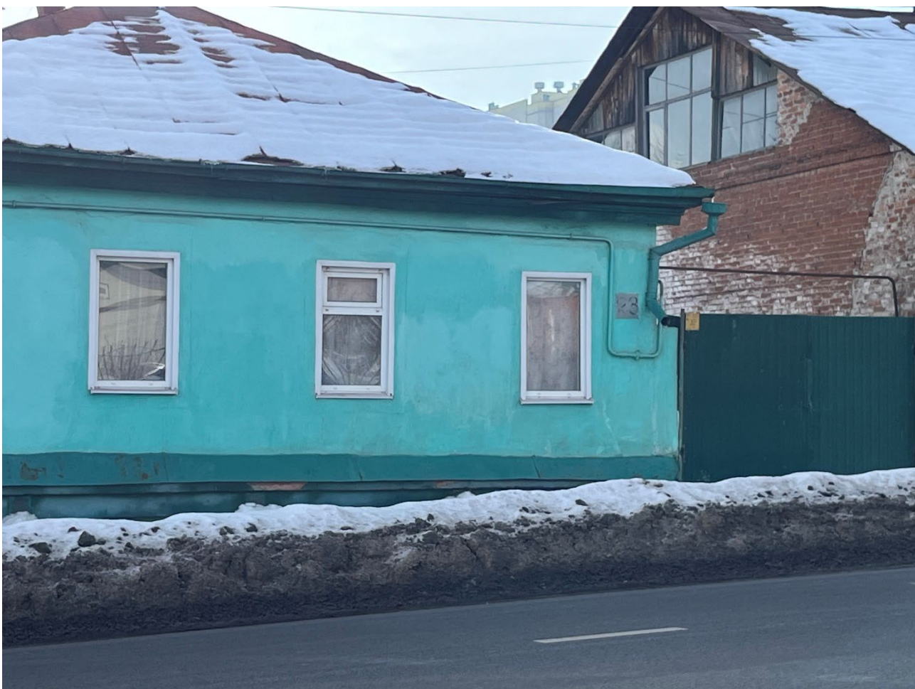
Т.ф. 6. Вид с севера на главный фасад Объекта
