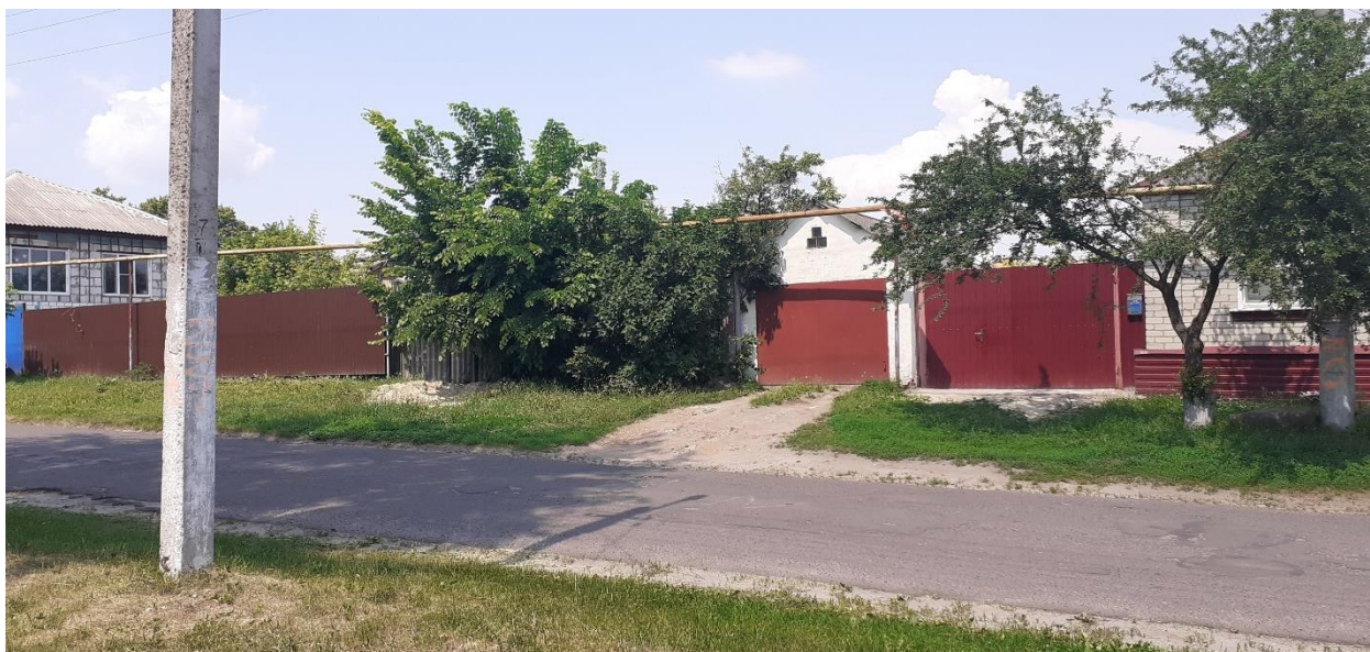
Фотография № 3. Вид с юго-востока на Объект.
