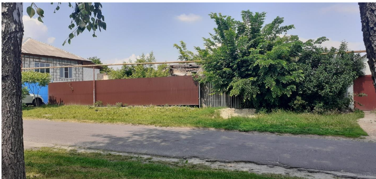
Фотография № 5. Вид с юго-востока на Объект.
