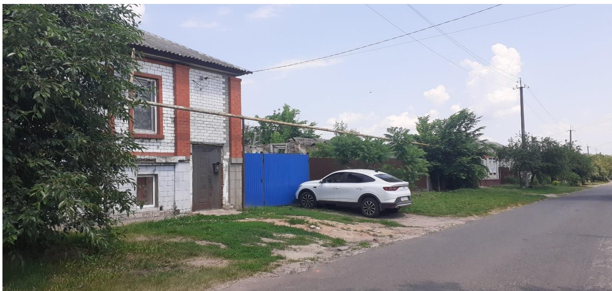
Фотография № 9. Вид с юго-запада на Объект.
