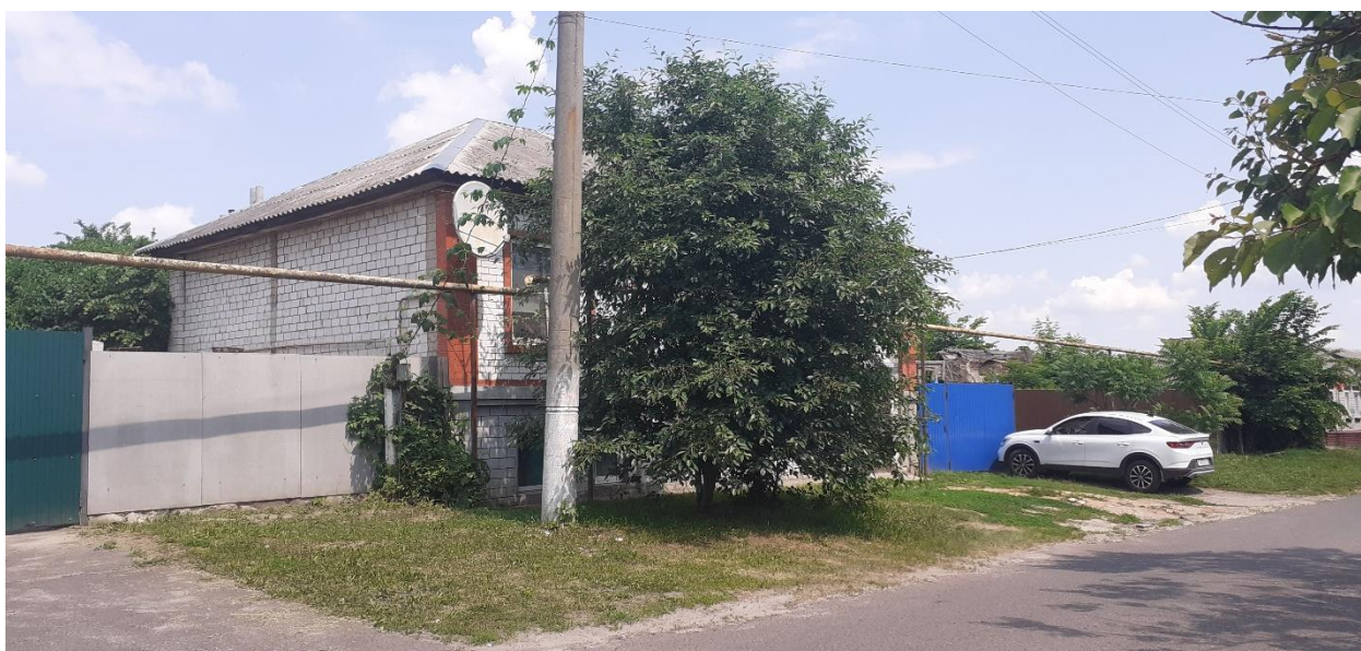
Фотография № 10. Вид с юго-запада на Объект.
