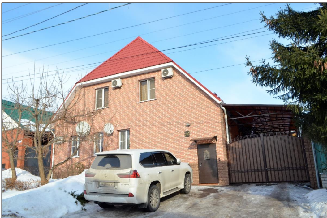
Т.ф.2. Общй вид на Объект с юга
