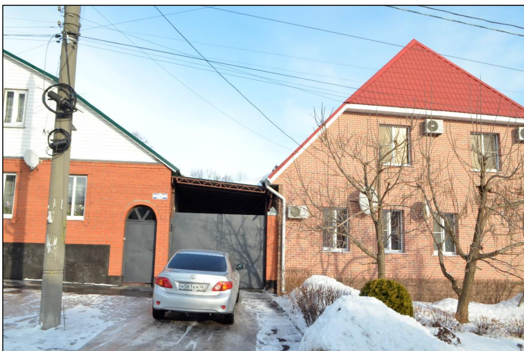
Т.ф.4. Общий вид на Объект с юго-запада
