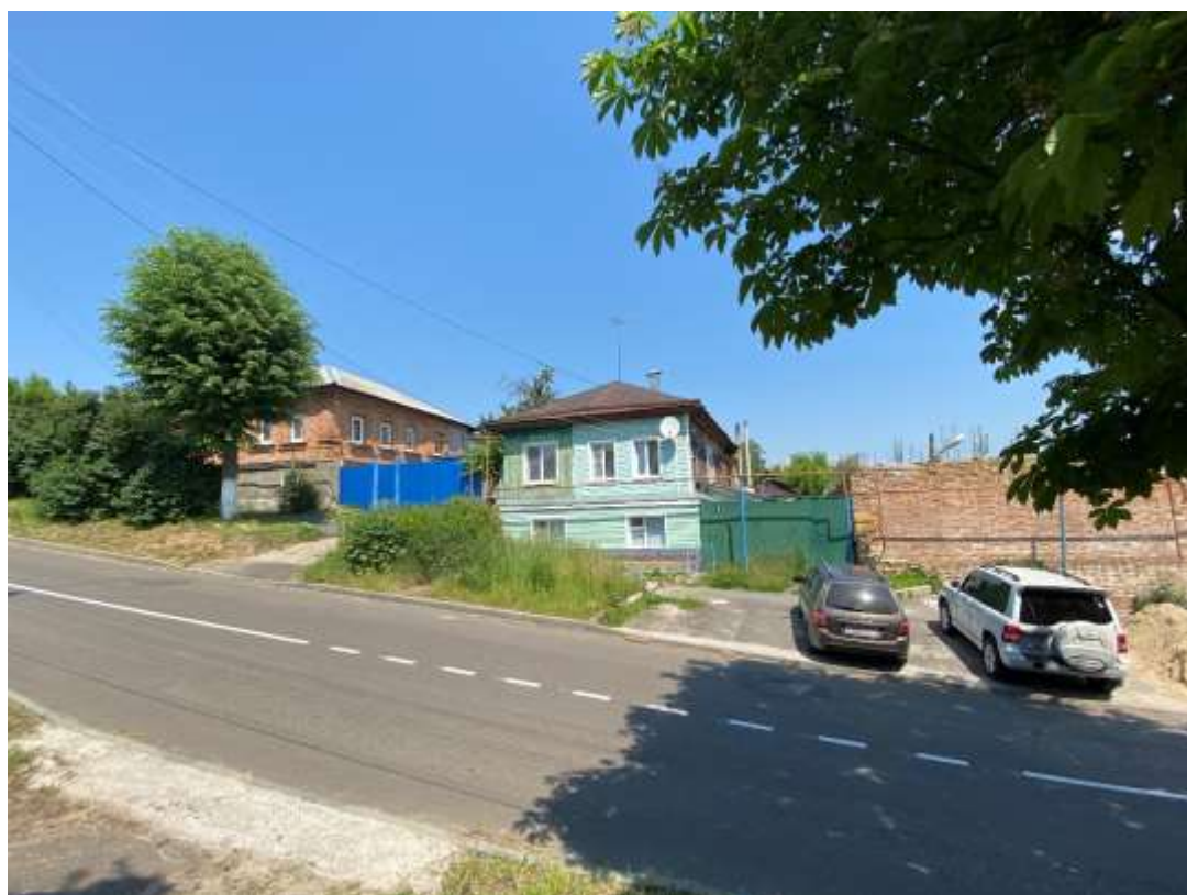
Фотография № 2. Вид с юго-востока на Объект.
