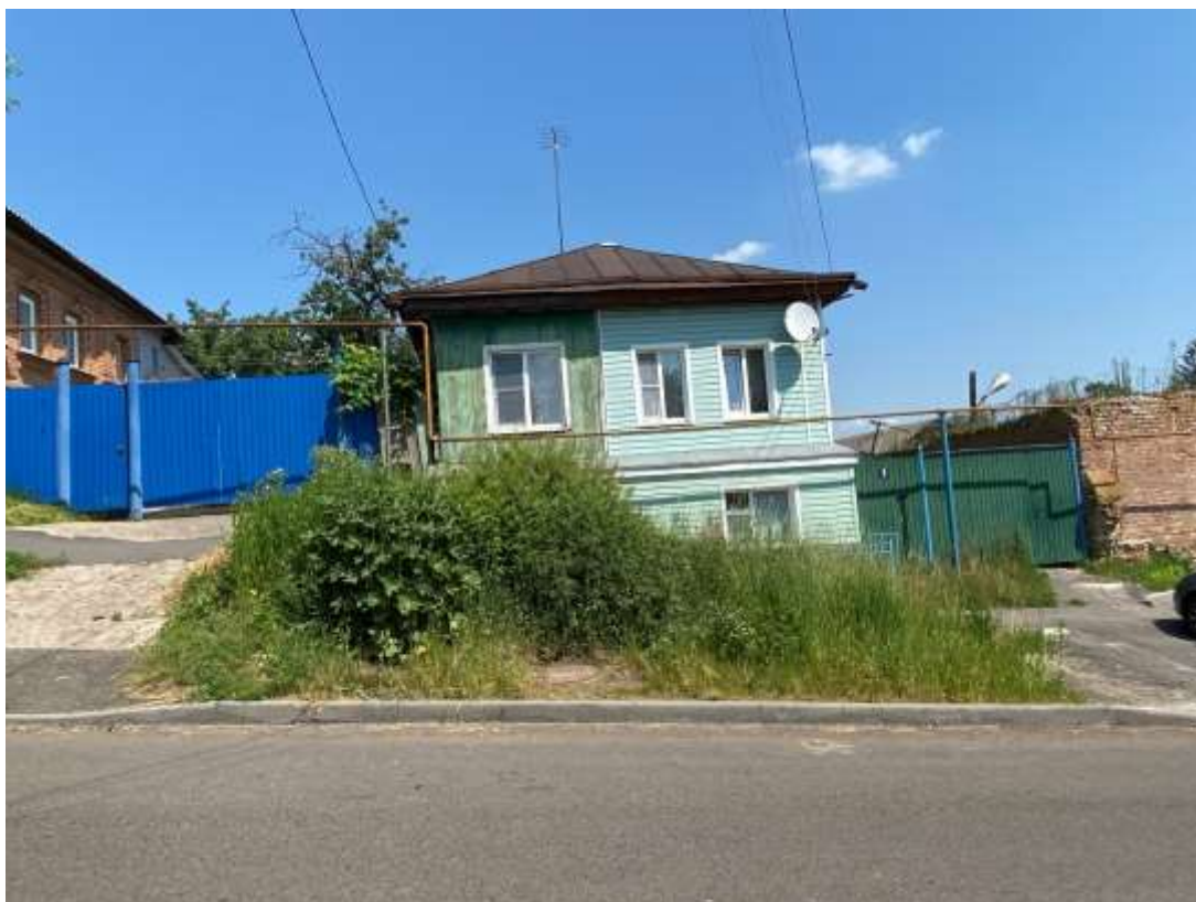
Фотография № 7. Вид с юга на Объект.
