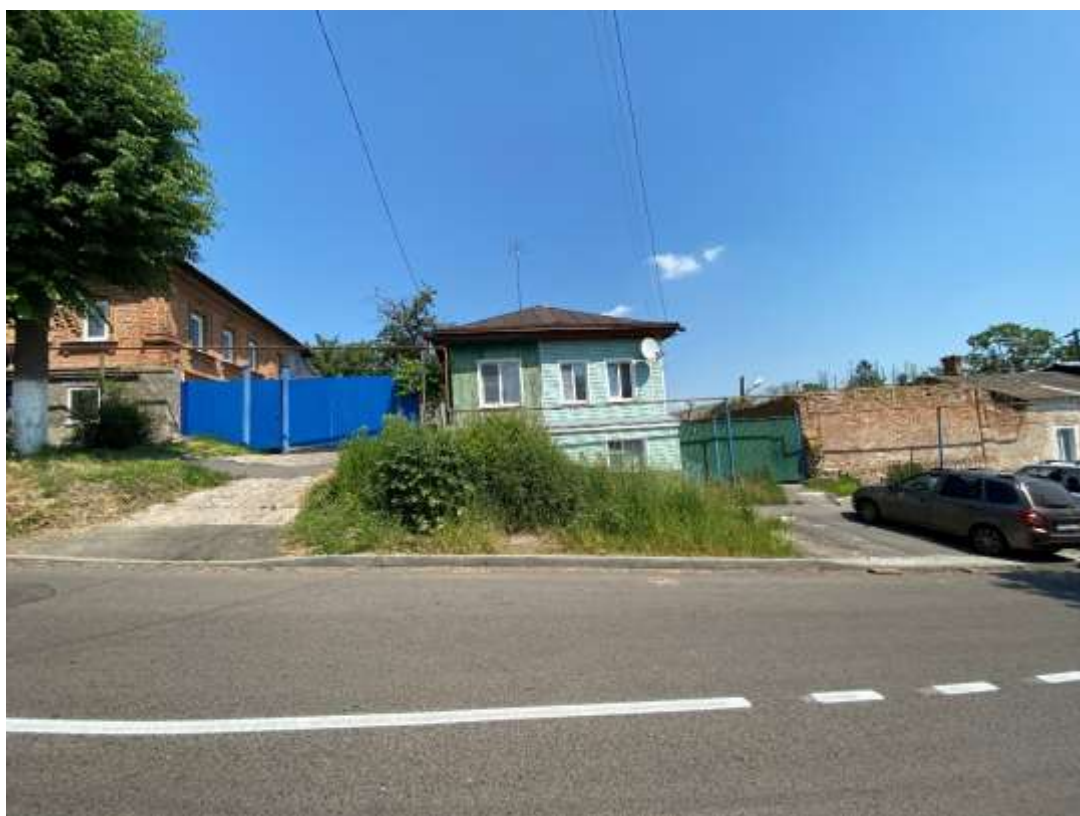
Фотография № 6. Вид с юга на Объект.
