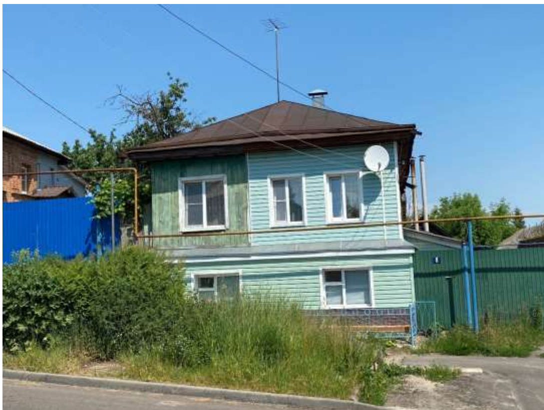
Фотография № 5. Вид с юга на Объект.
