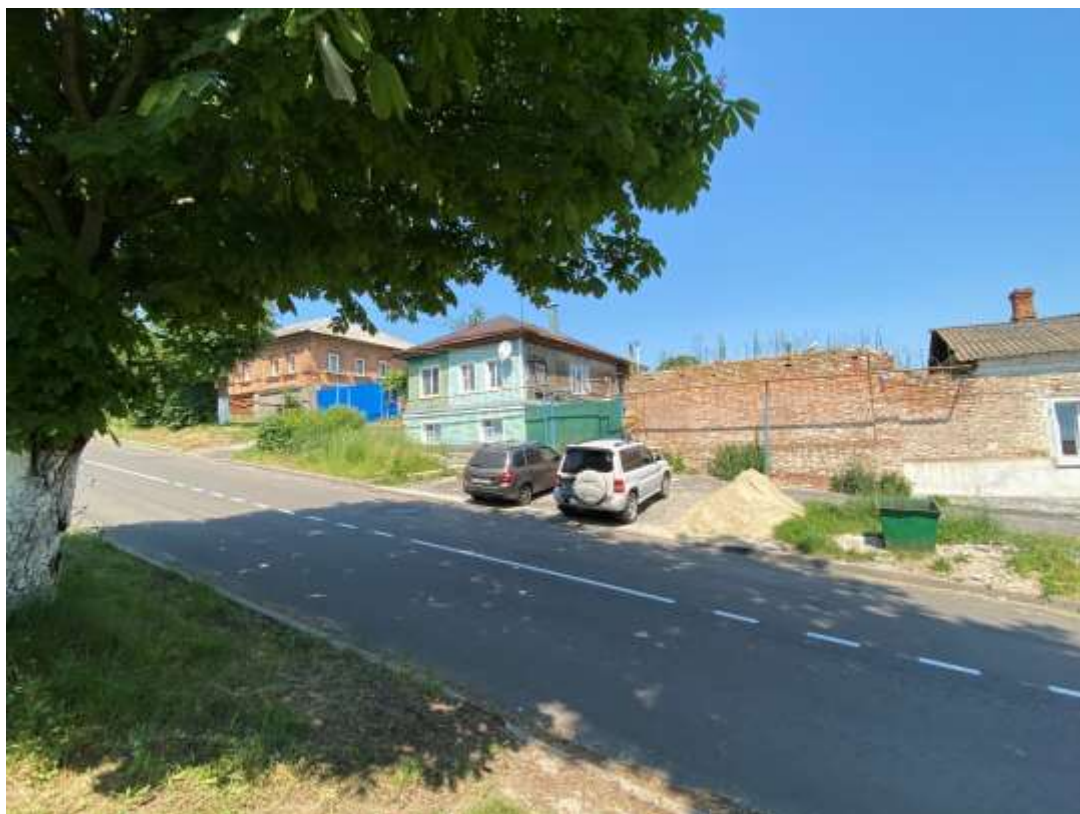
Фотография № 1. Вид с юго-востока на Объект.
