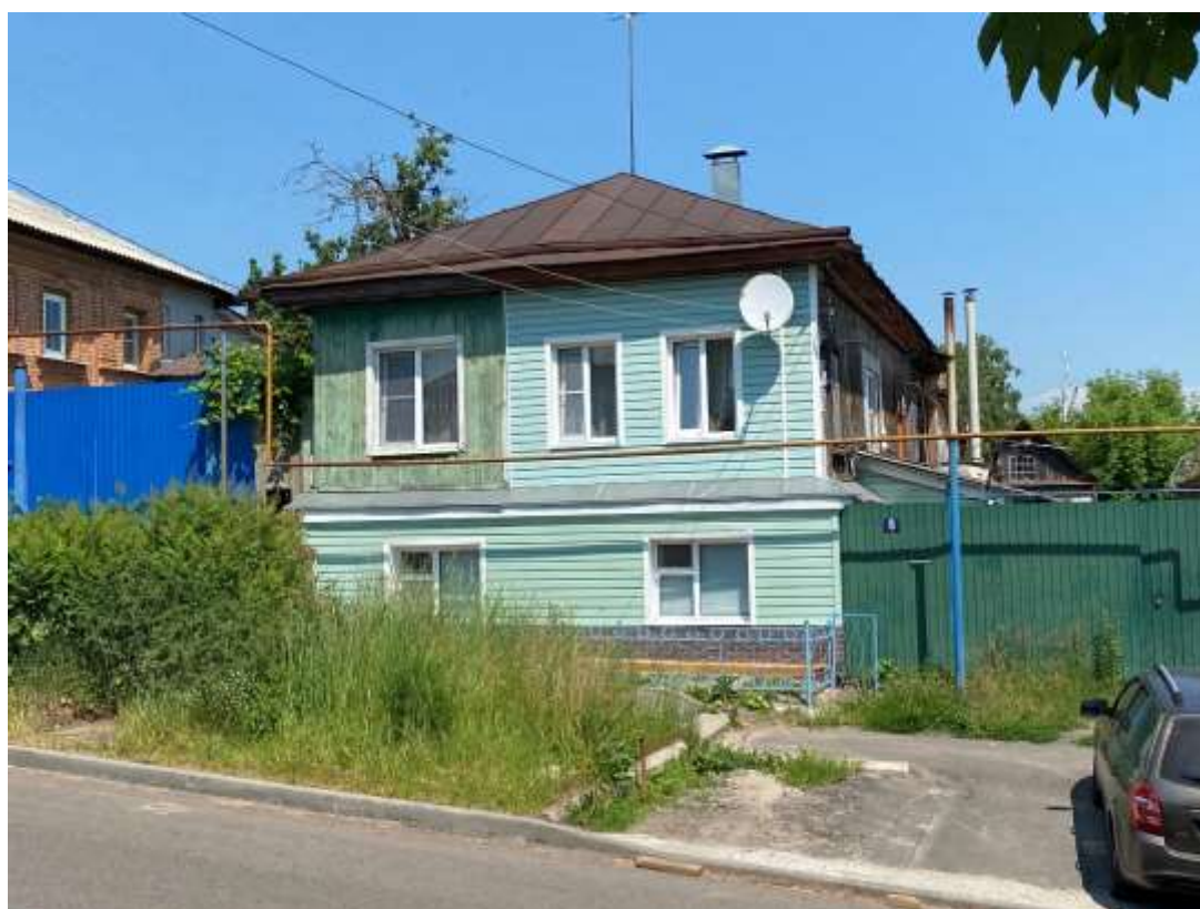
Фотография № 4. Вид с юго-востока на Объект.
