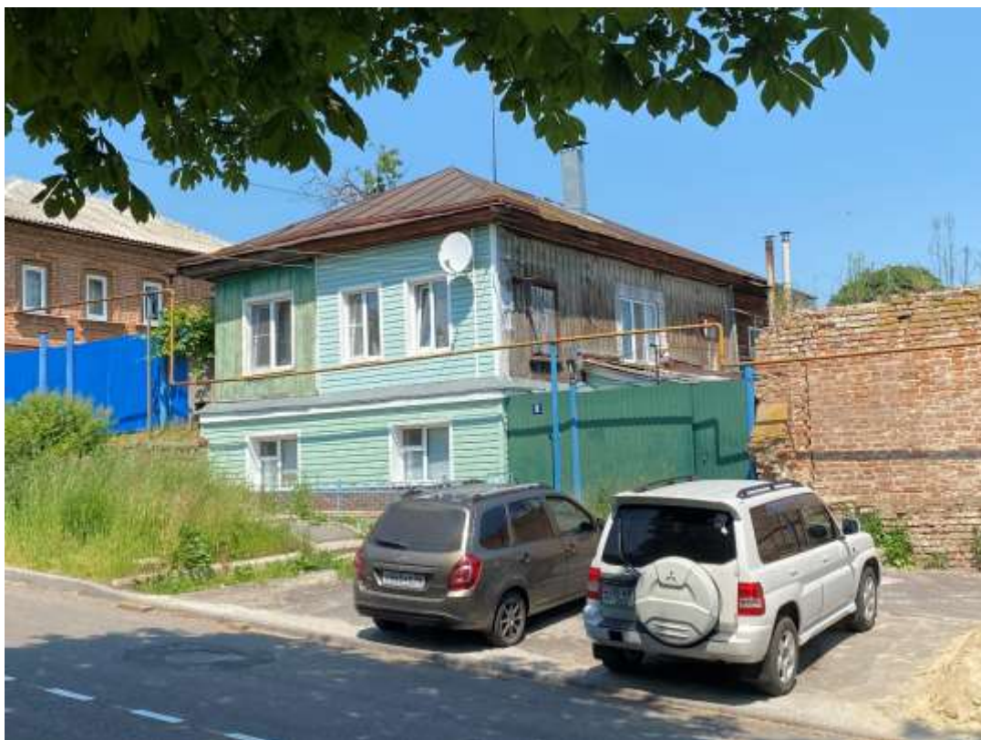
Фотография № 3. Вид с юго-востока на Объект.
