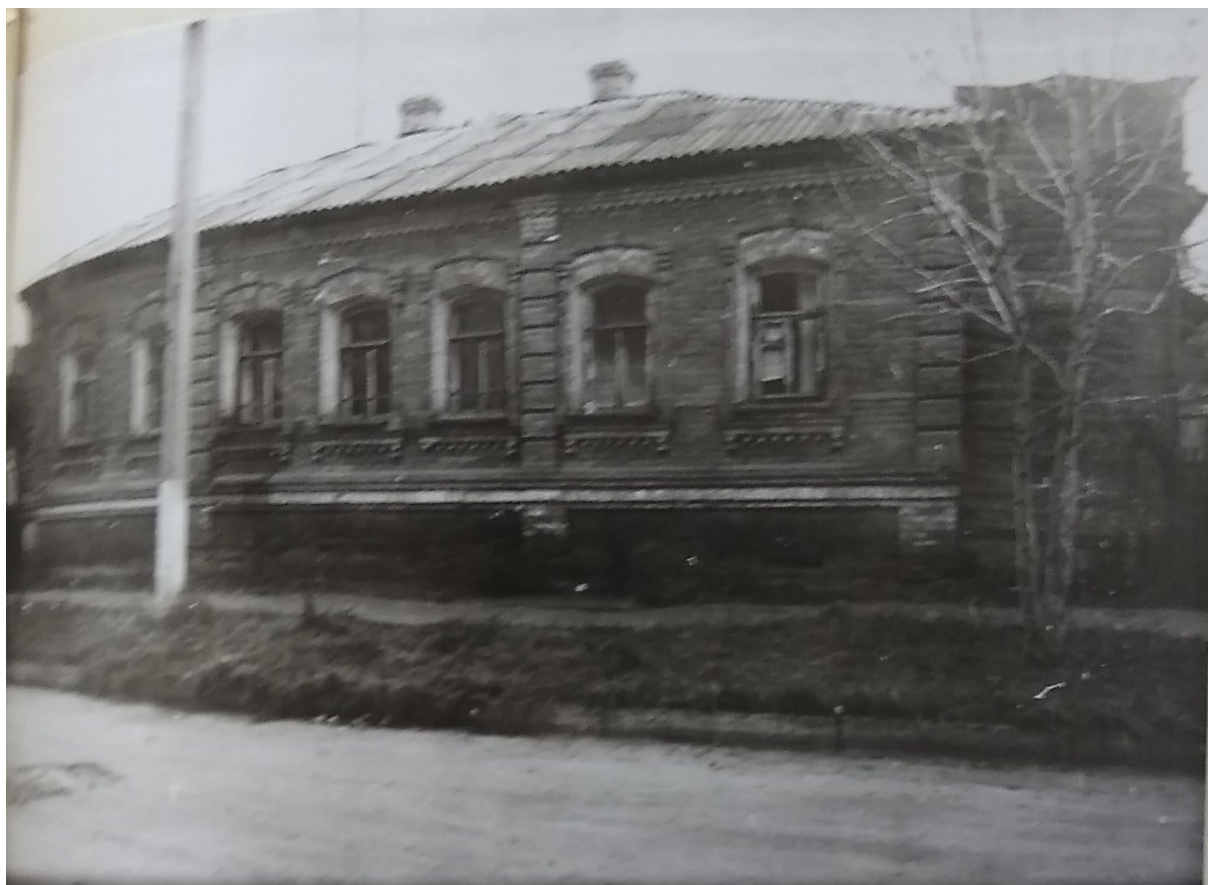
18. Дом по ул. Ленина, 68. Здание Объекта на фотографии в «Проекте охранных зон г. Рыльска Курской обл.» 1990 года.
