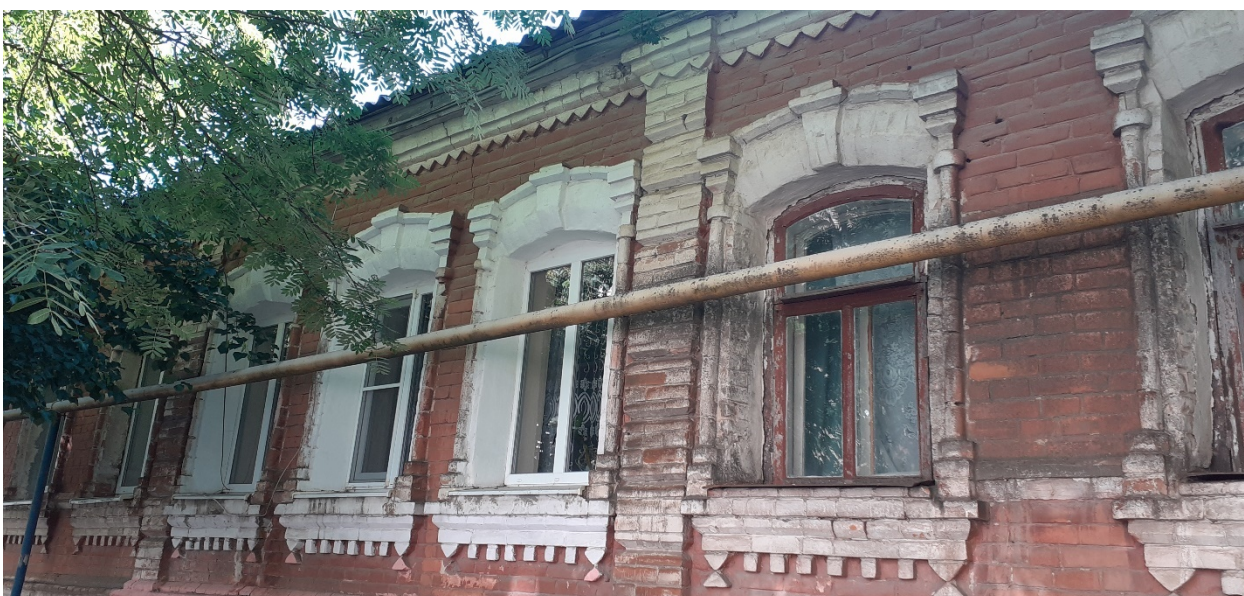
Фотография № 6. Вид с северо-востока на Объект.
