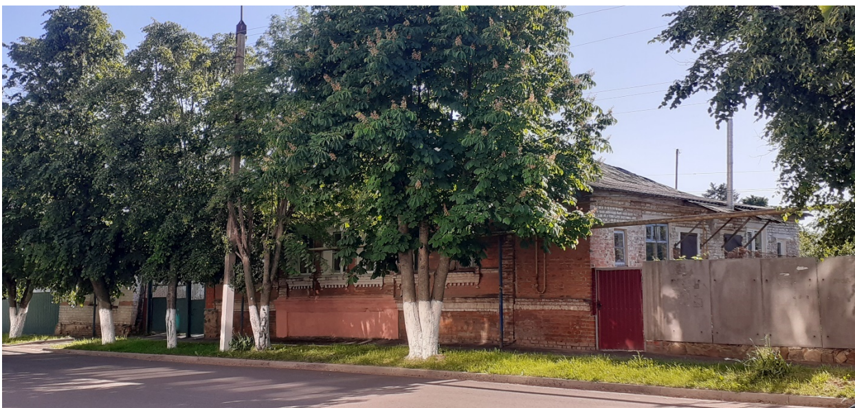
Фотография № 10. Вид с северо-востока на Объект.
