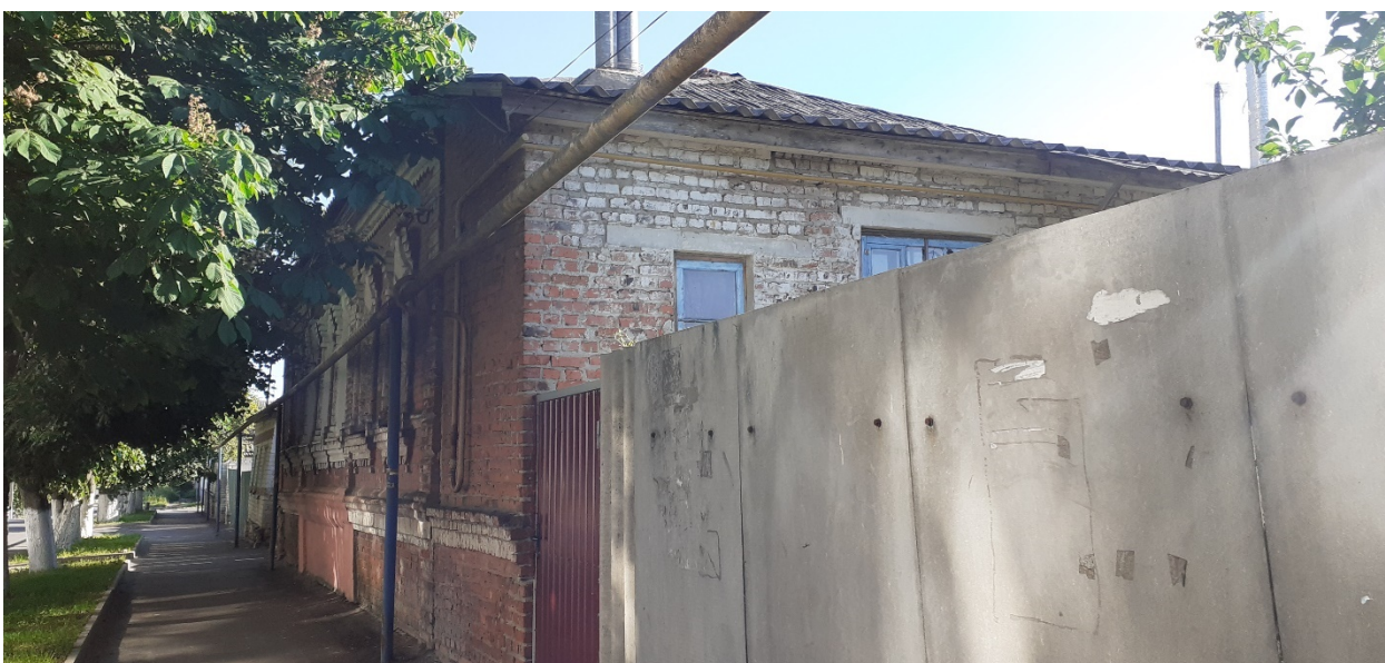
Фотография № 8. Вид с северо-востока на Объект.
