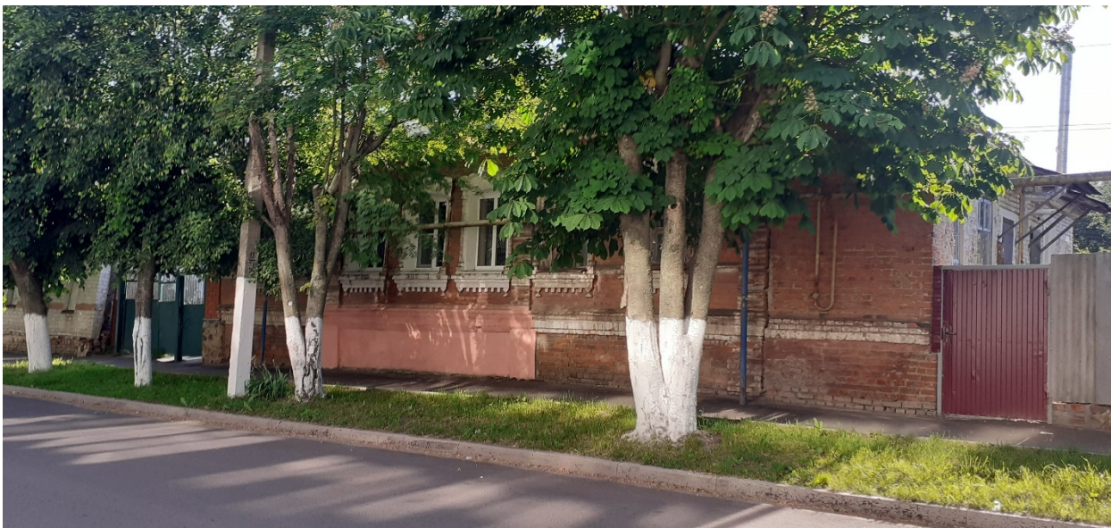
Фотография № 7. Вид с северо-востока на Объект.
