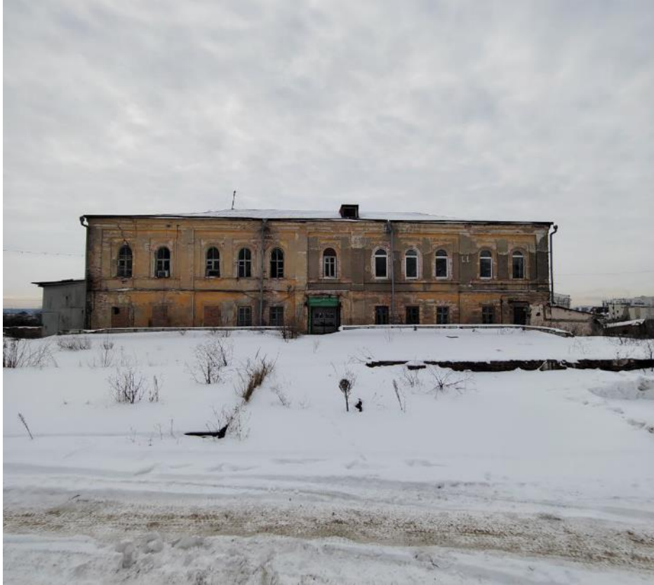
Ф. 2. Северный фасад. Общий вид. 19.01.2026 г.
