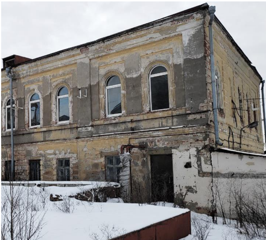
Ф. 5. Вид с Северо-Востока. Фрагмент. 19.01.2026 г.
