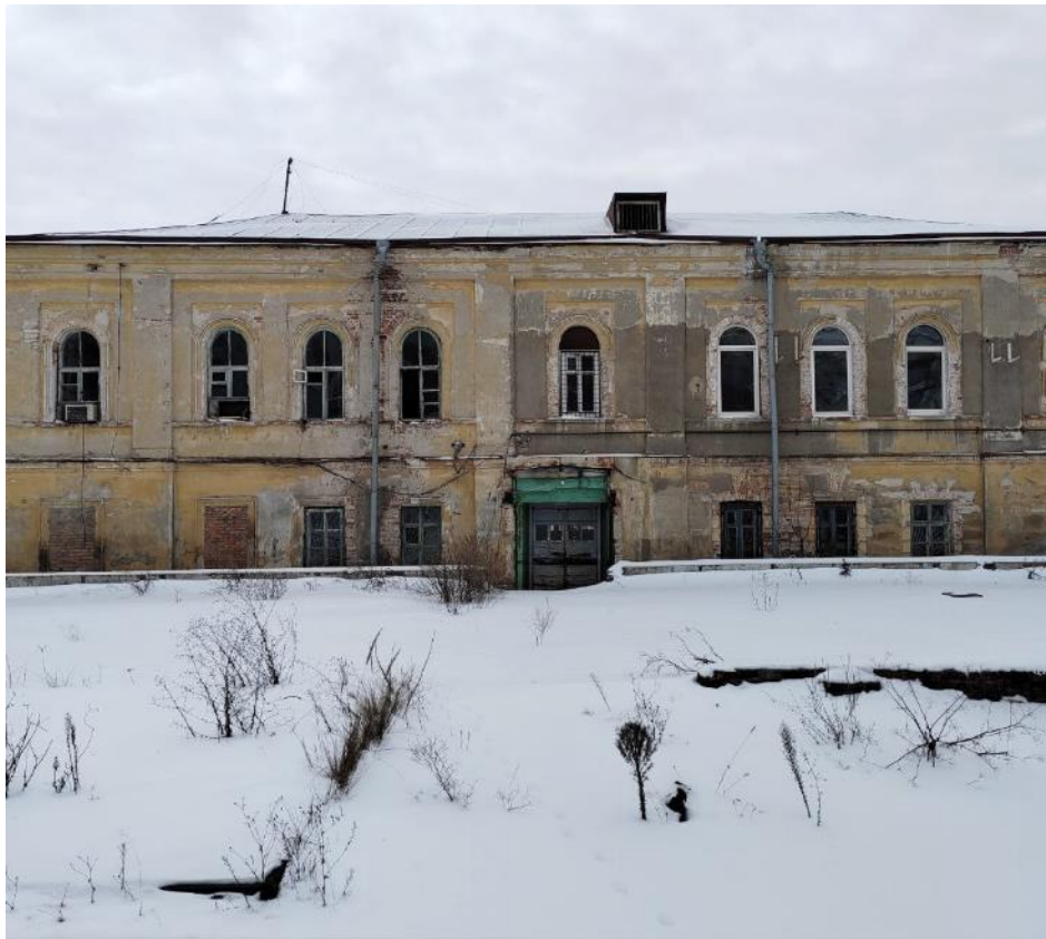
Ф. 3. Северный фасад. Фрагмент. 19.01.2026 г.
