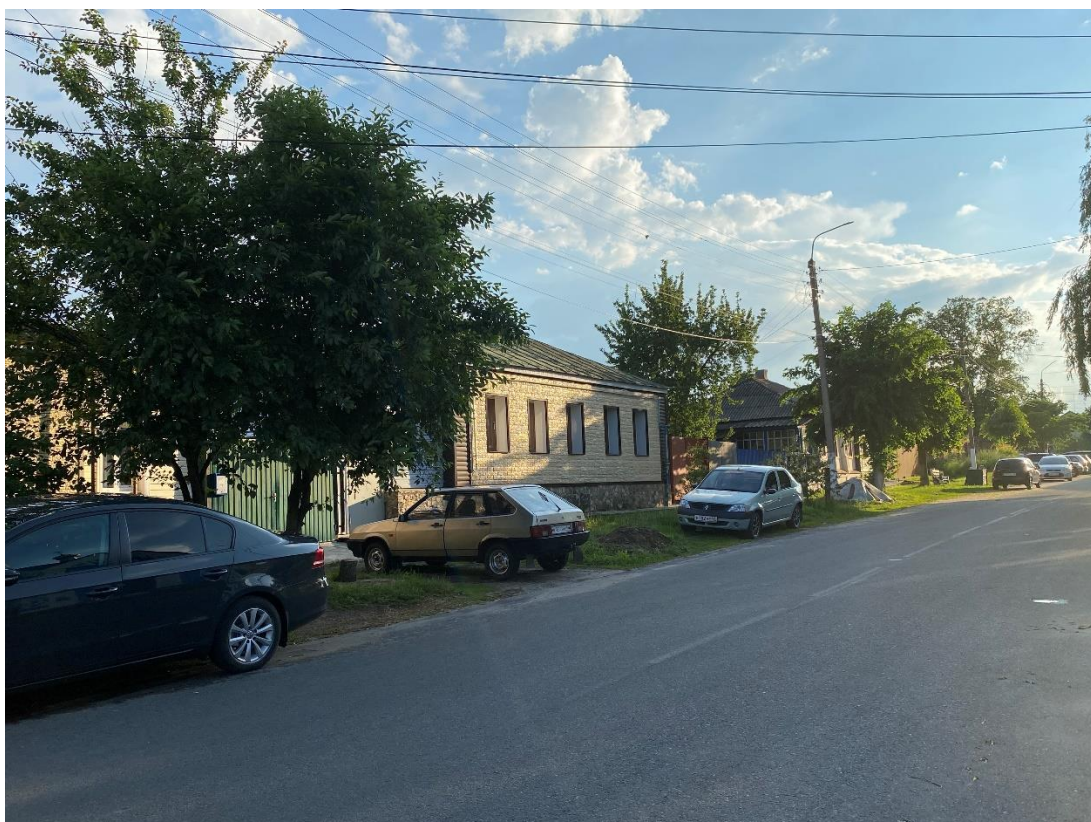
Фотография № 2. Вид с северо-востока на Объект.
