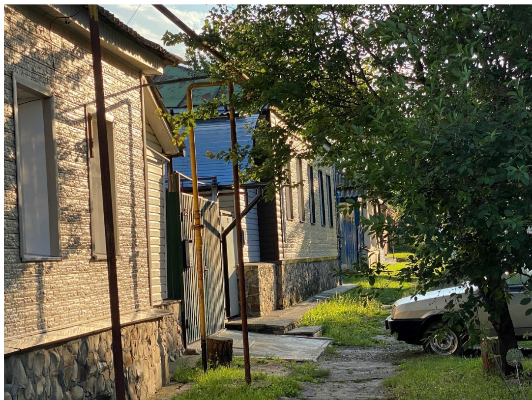
Фотография № 4. Вид с востока на Объект.
