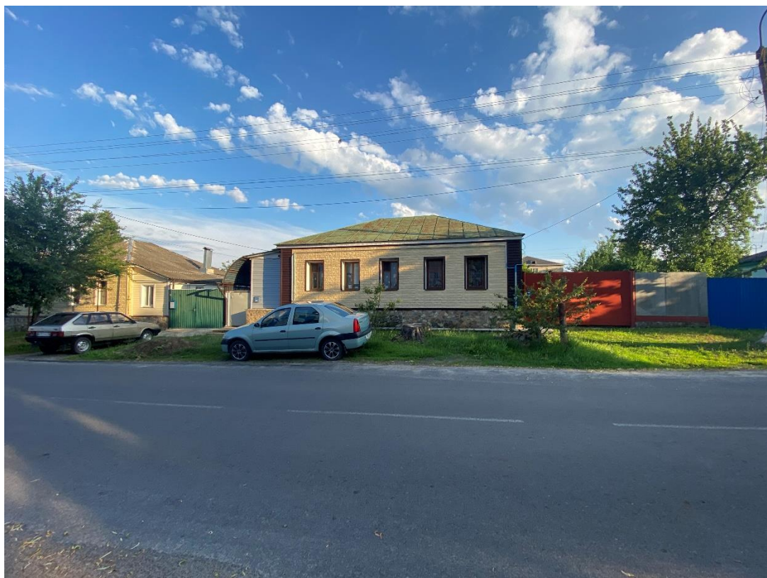
Фотография № 7. Вид с севера на Объект.
