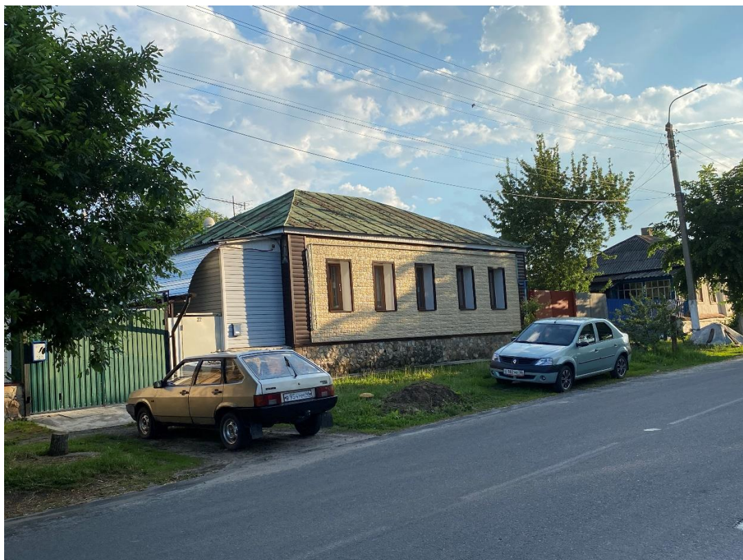
Фотография № 3. Вид с северо-востока на Объект.
