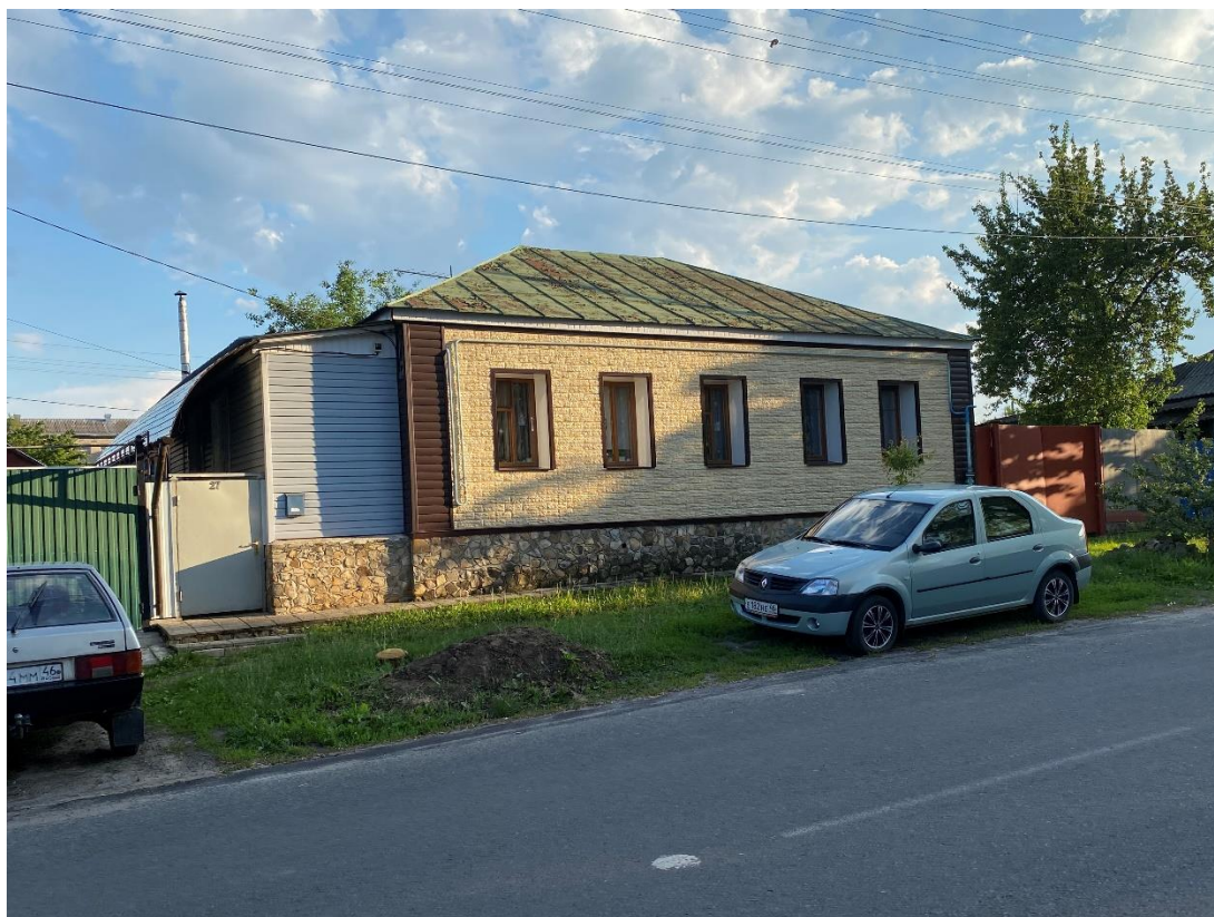
Фотография № 5. Вид с северо-востока на Объект.
