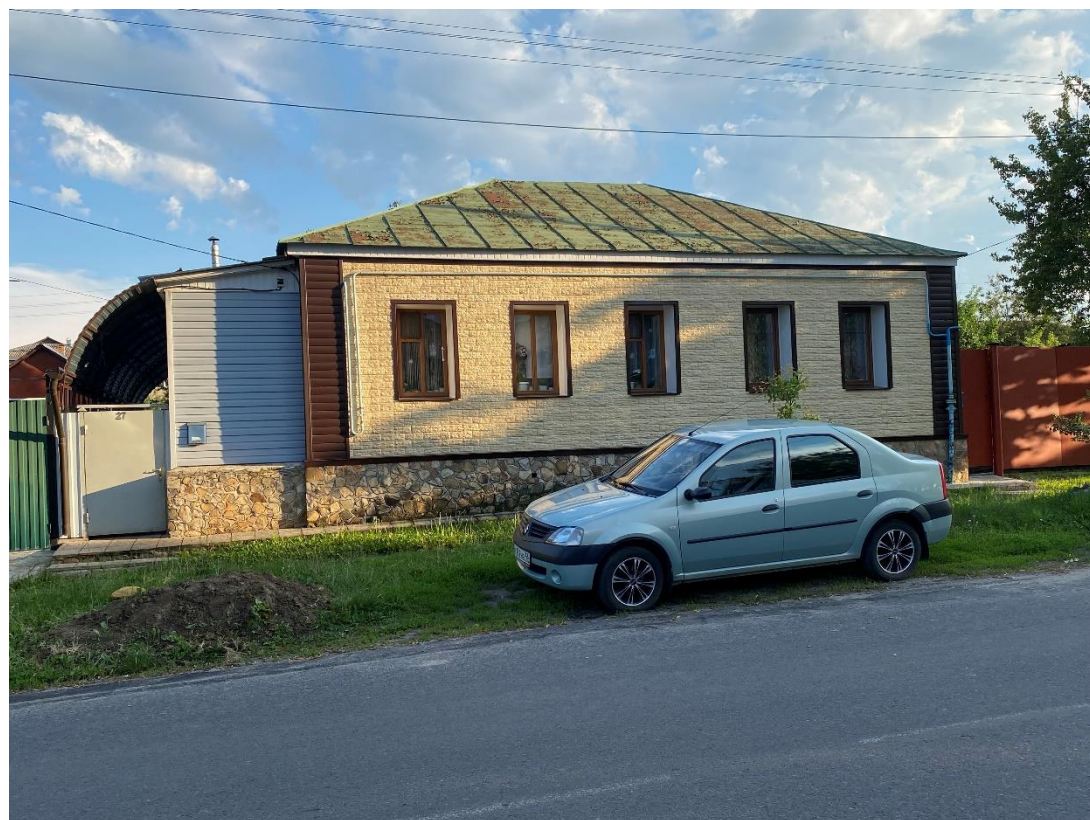
Фотография № 6. Вид с севера на Объект.
