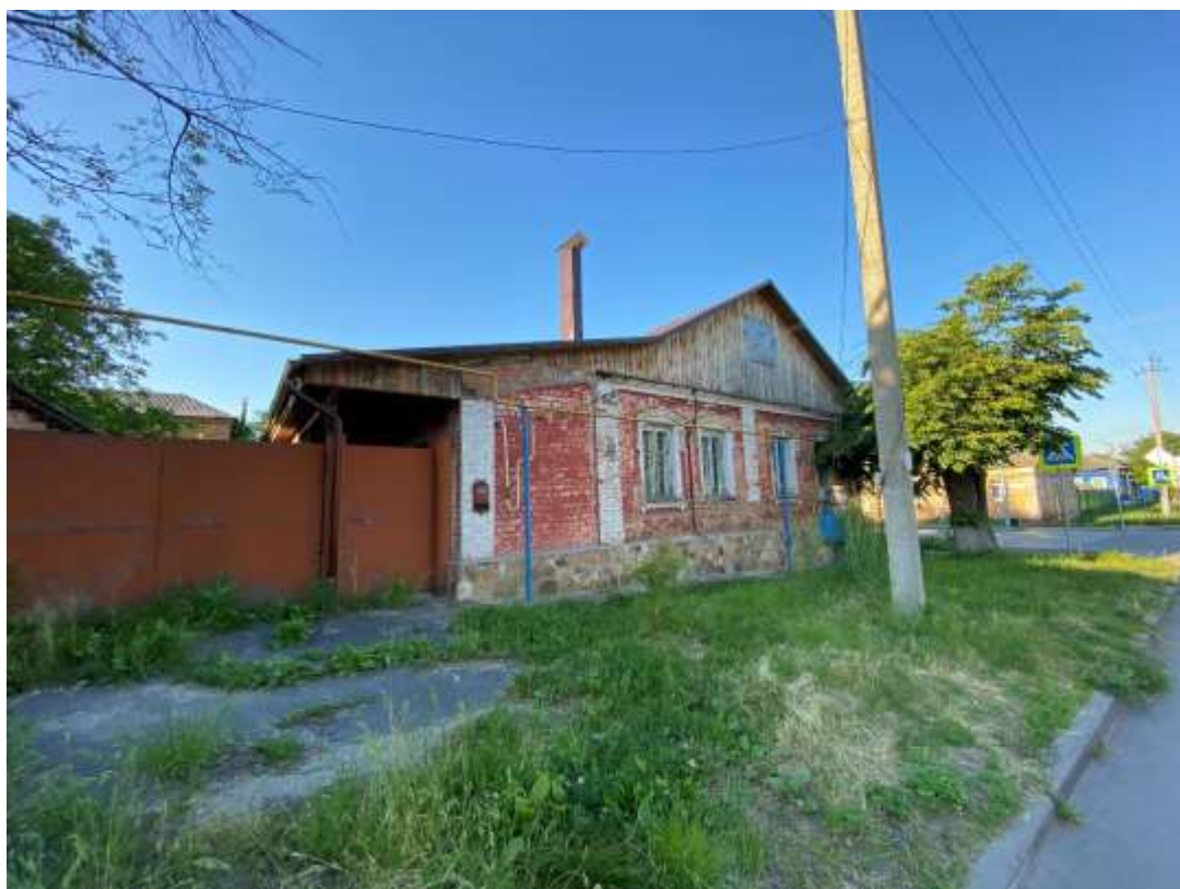
Фотография № 2. Вид с юго-запада на Объект.
