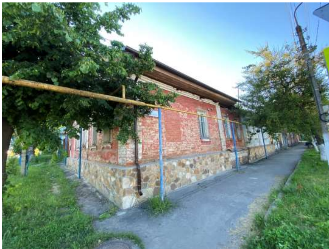
Фотография № 7. Вид с юго-востока на Объект.
