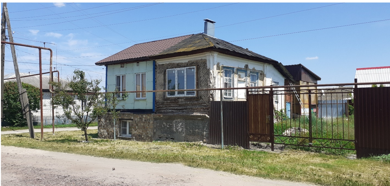
Фотография № 3. Вид с юго-запада на Объект.
