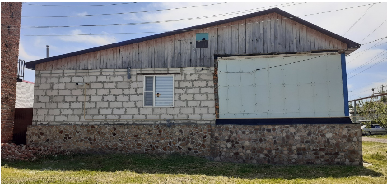
Фотография № 9. Вид с севера на Объект.
