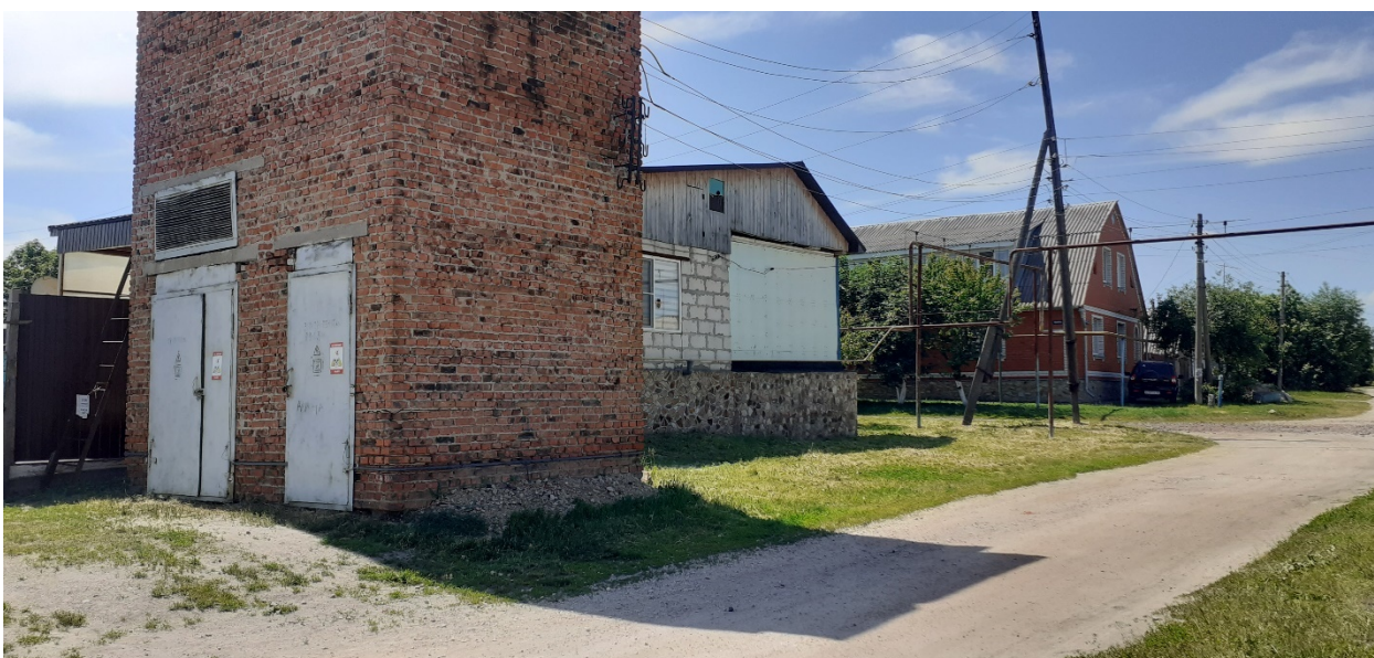
Фотография № 10. Вид с северо-востока на Объект.
