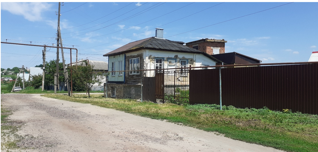
Фотография № 2. Вид с юго-запада на Объект.
