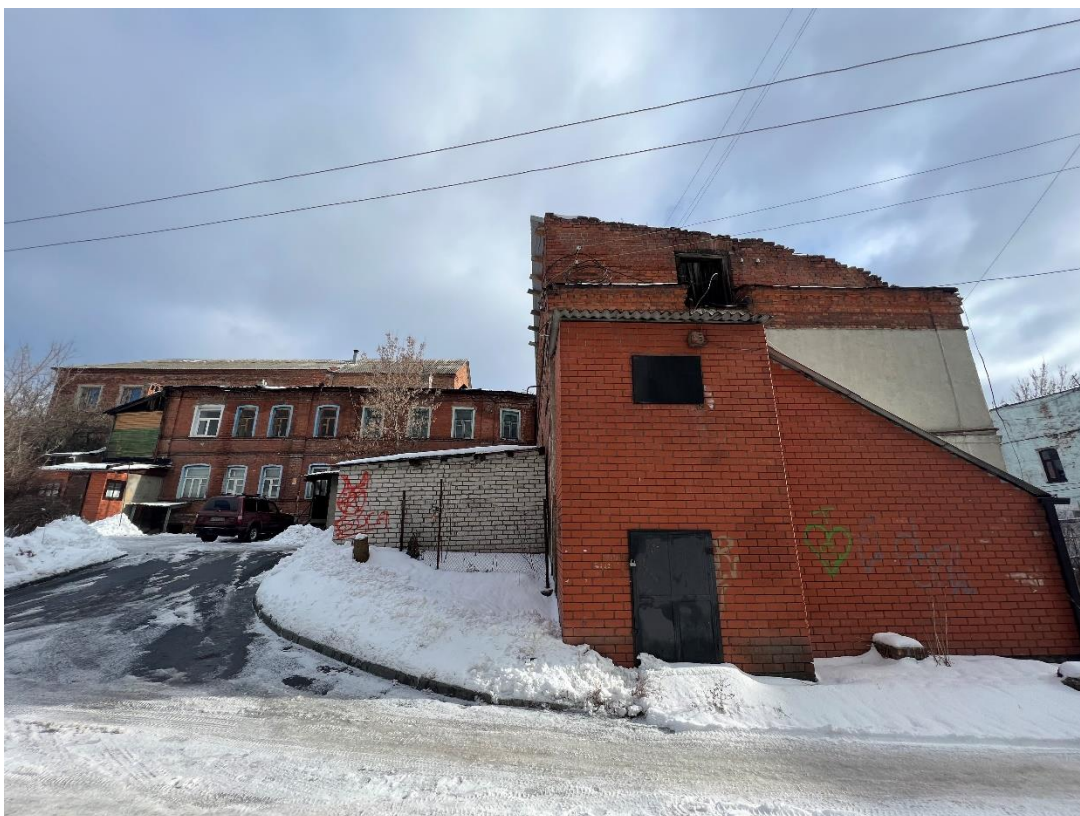
Фотография № 6. Вид с юго-запада на Объект.
