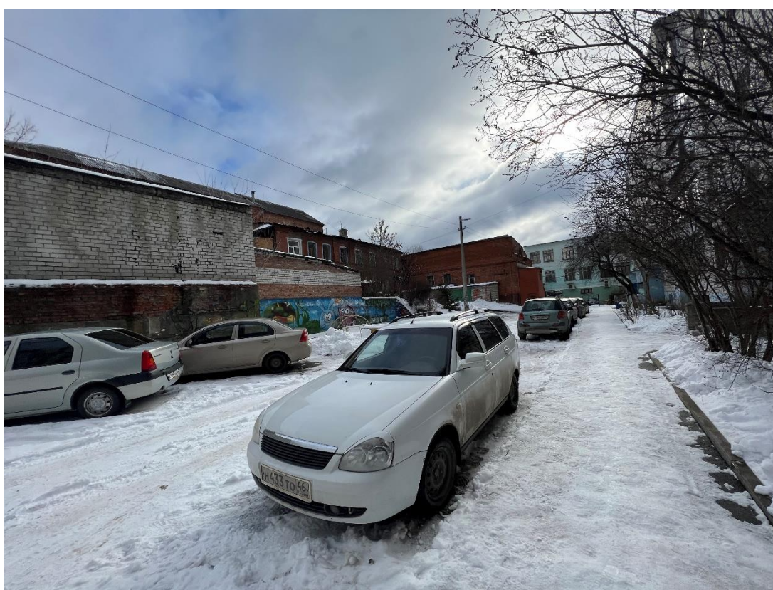
Фотография № 2. Вид с северо-запада на Объект.
