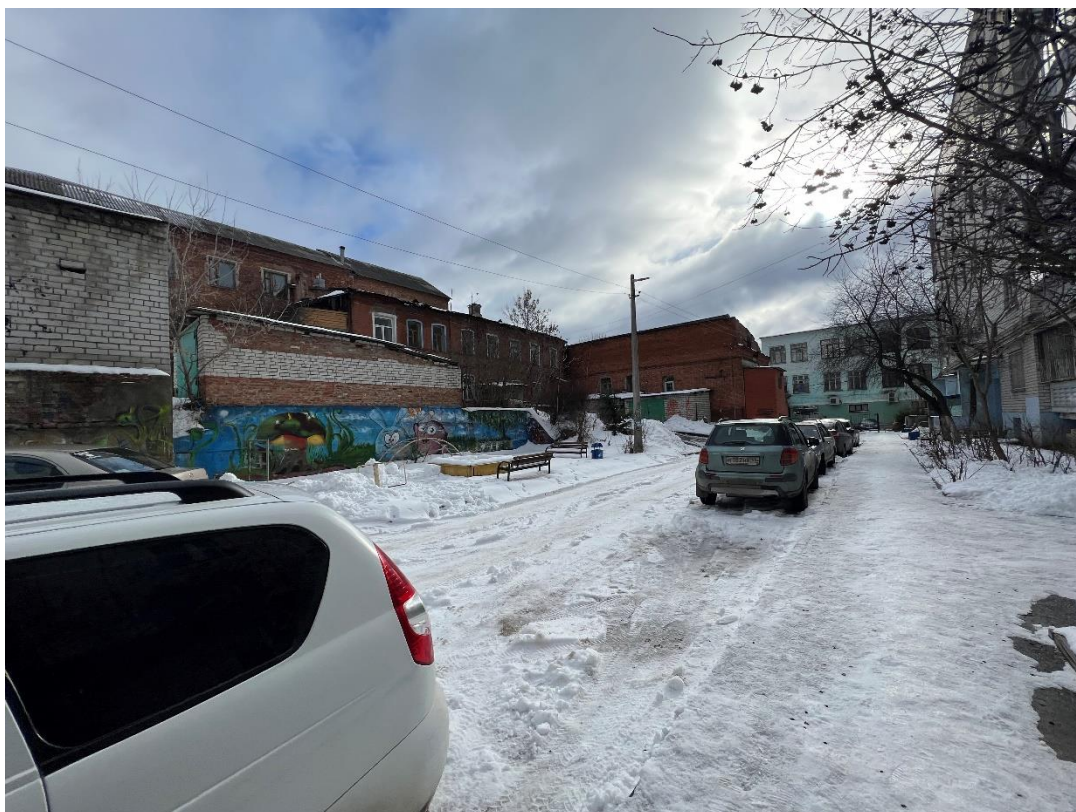
Фотография № 3. Вид с северо-запада на Объект.
