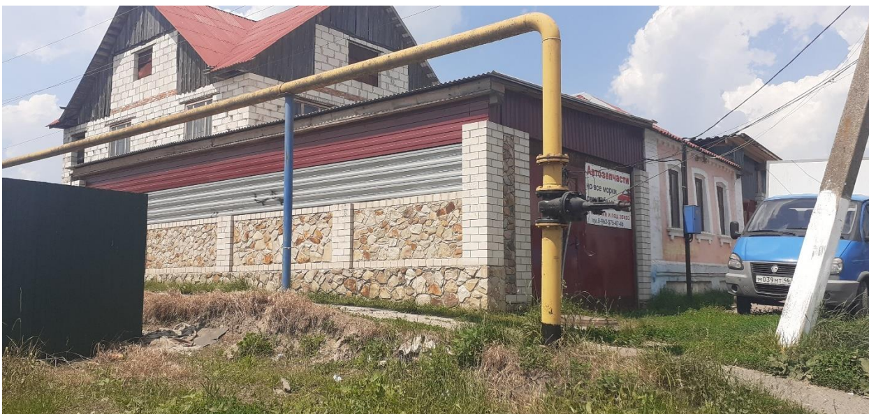
Фотография № 7. Вид с юго-востока на Объект.
