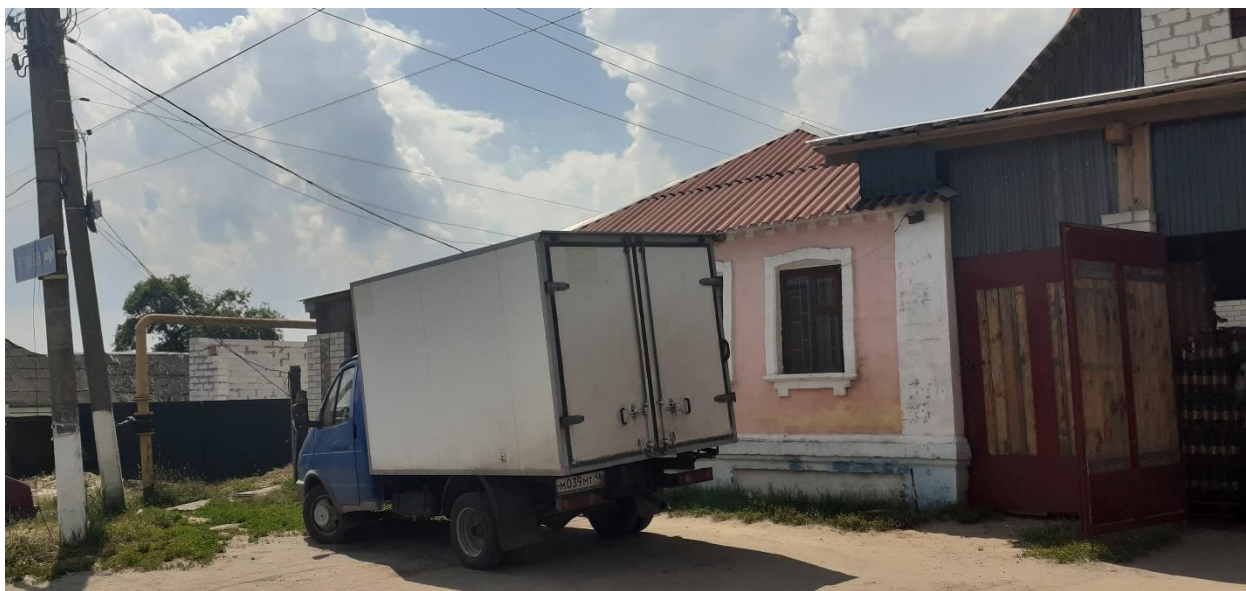
Фотография № 3. Вид с северо-востока на Объект. Центральный (восточный) фасад. Фрагмент.
