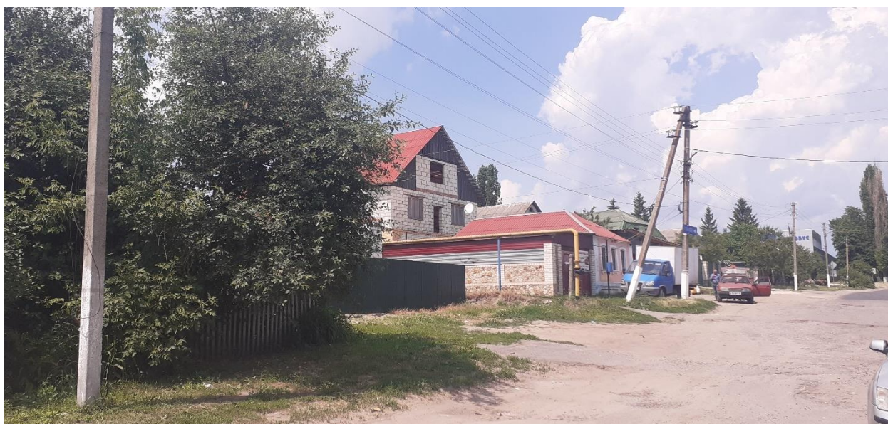
Фотография № 10. Вид с юго-востока на Объект.
