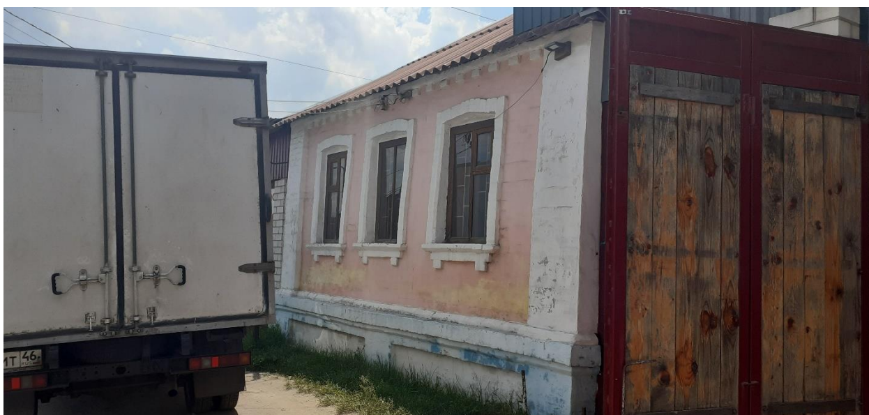
Фотография № 4. Вид с севера на Объект. Центральный (восточный) фасад.
