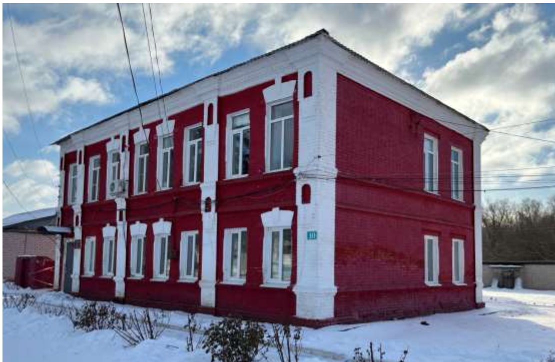
Т.ф. 1. Общий вид главного фасада Объекта.
