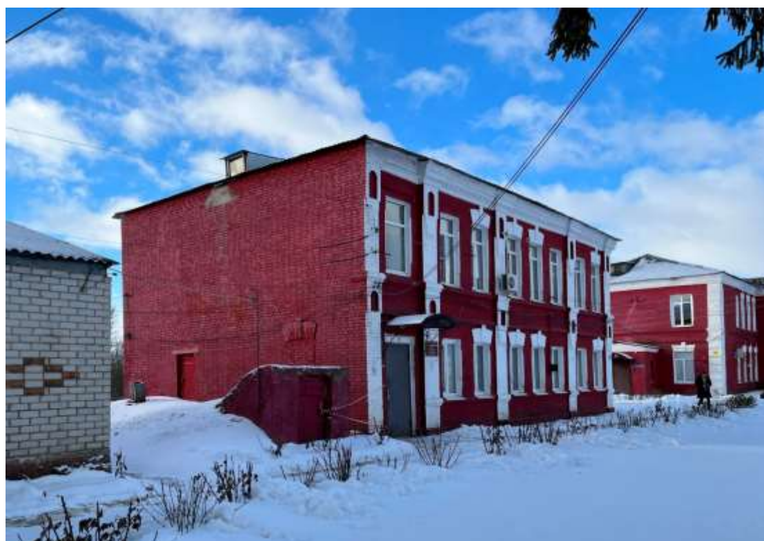
Т.ф. 2. Общий вид главного фасада Объекта.
