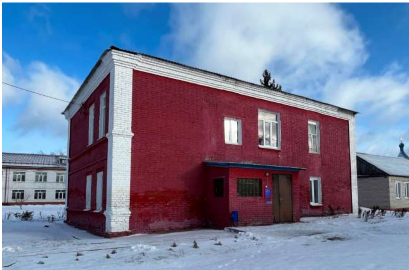
Т.ф. 5. Общий вид дворового фасада Объекта.
