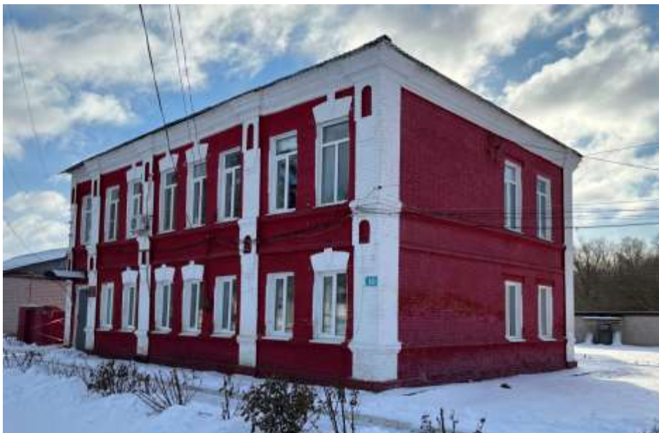
«Здание земской больницы» в п. Прямичино, ул. Октябрьская, д. 185
