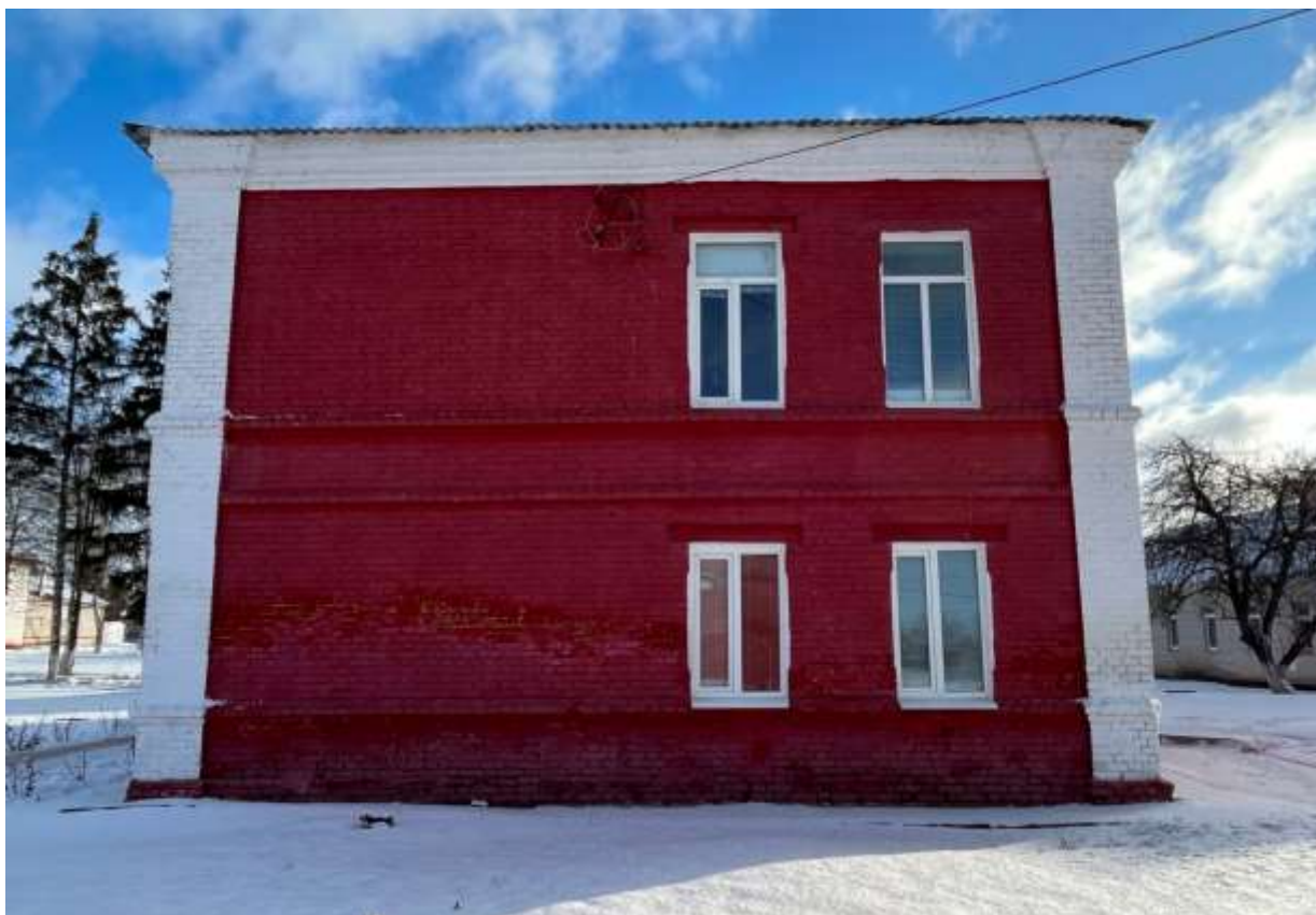
Т.ф. 3. Общій вид бокового фасада Объекта.
