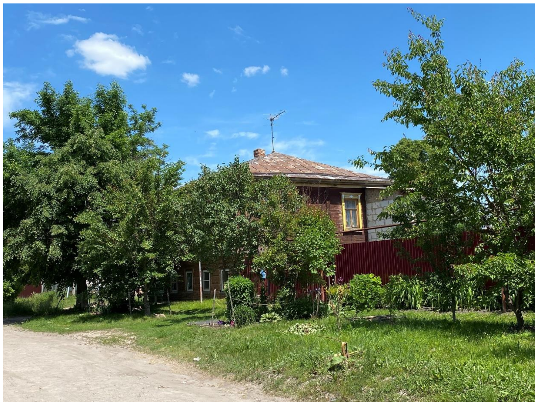
Фотография № 2. Вид с юго-запада на Объект.
