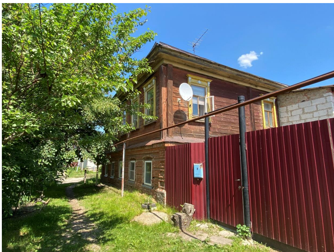
Фотография № 4. Вид с юго-запада на Объект.
