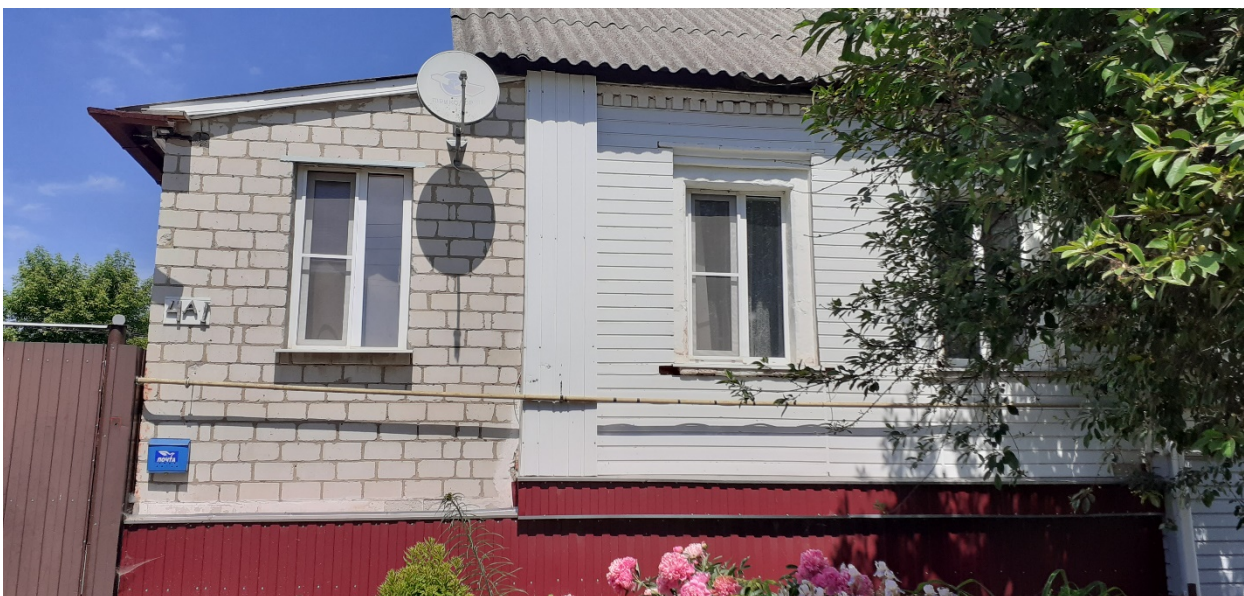
Фотография № 6. Вид с юга на Объект. Центральный фасад. Фрагмент.
