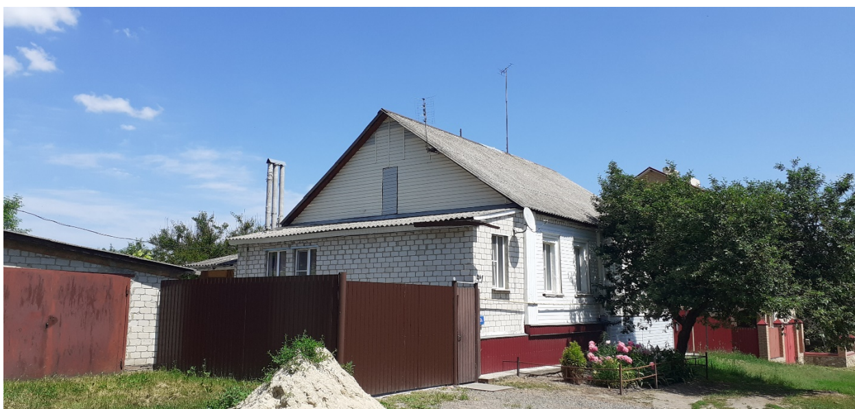
Фотография № 4. Вид с юго-запада на Объект.
