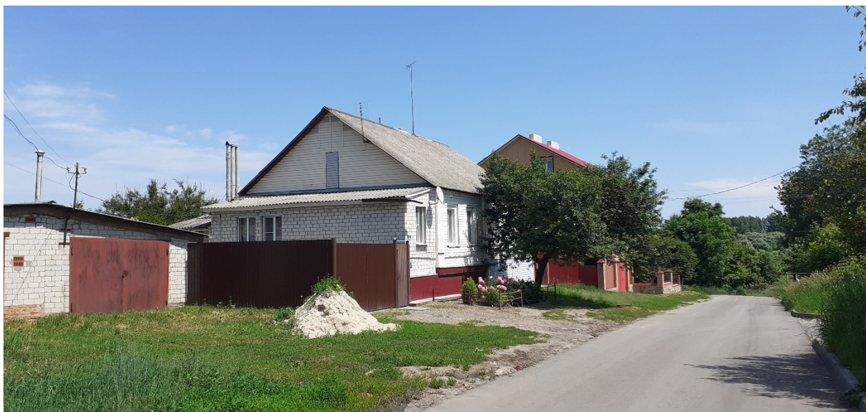
Фотография № 3. Вид с юго-запада на Объект.
