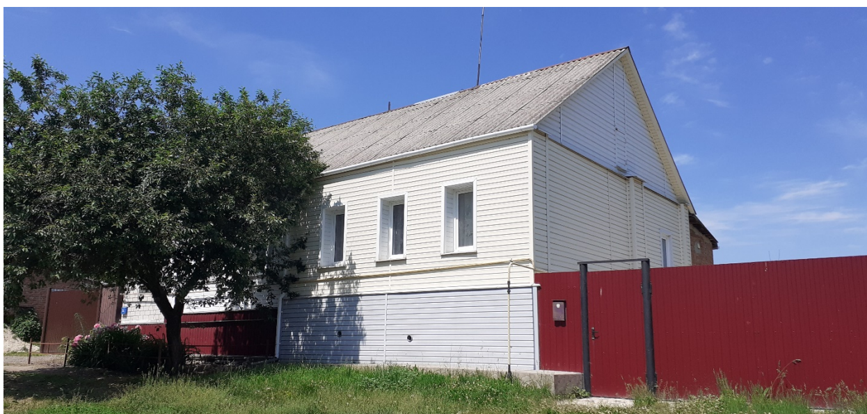
Фотография № 8. Вид с юго-востока на Объект.
