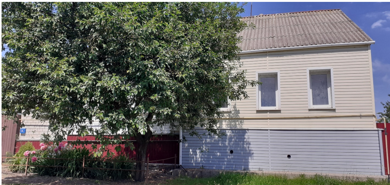
Фотография № 7. Вид с юга на Объект. Центральный фасад. Фрагмент.
