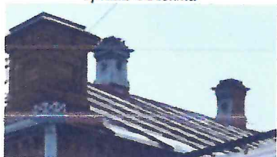
Печные трубы, фальц
