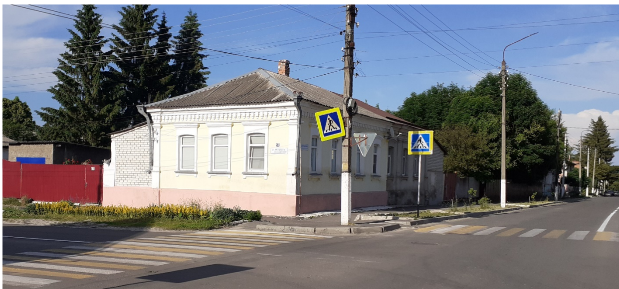
Фотография Объекта. Вид с юго-запада на Объект. 23.05.2022 г. Автор: Е.М. Федосеева
