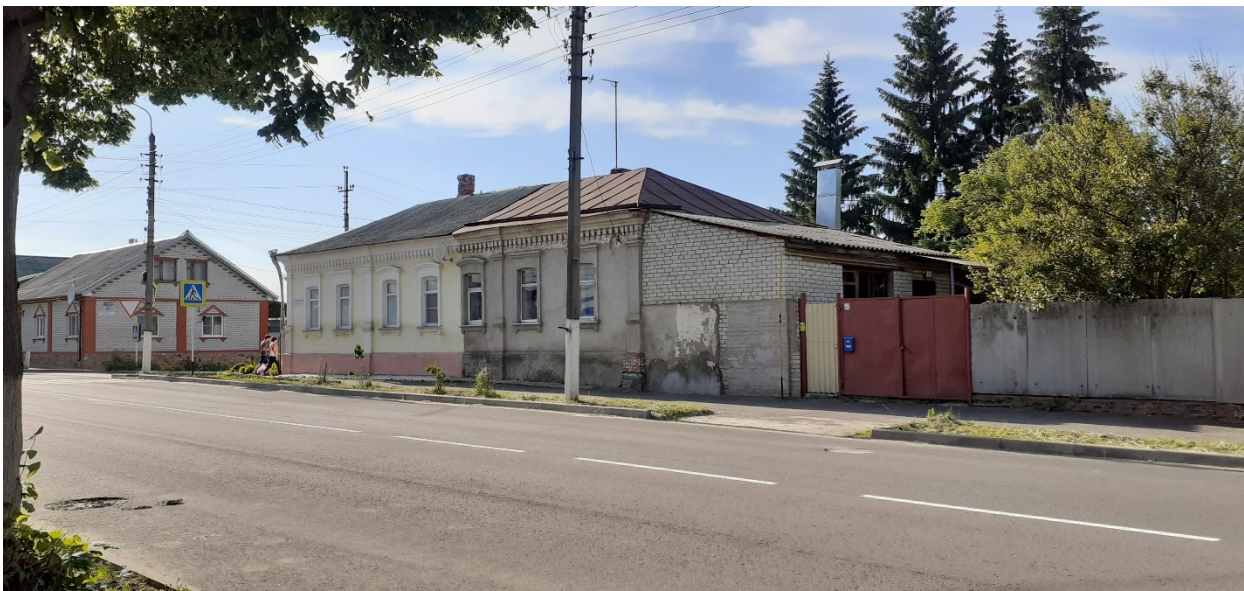
Фотография № 3. Вид с юго-востока на Объект.
