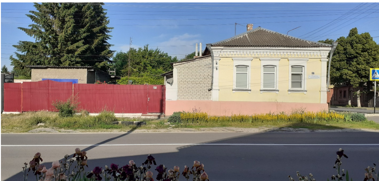
Фотография № 9. Вид с запада на Объект.
