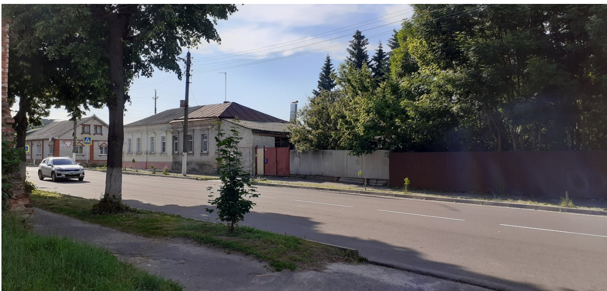
Фотография № 2. Вид с юго-востока на Объект.
