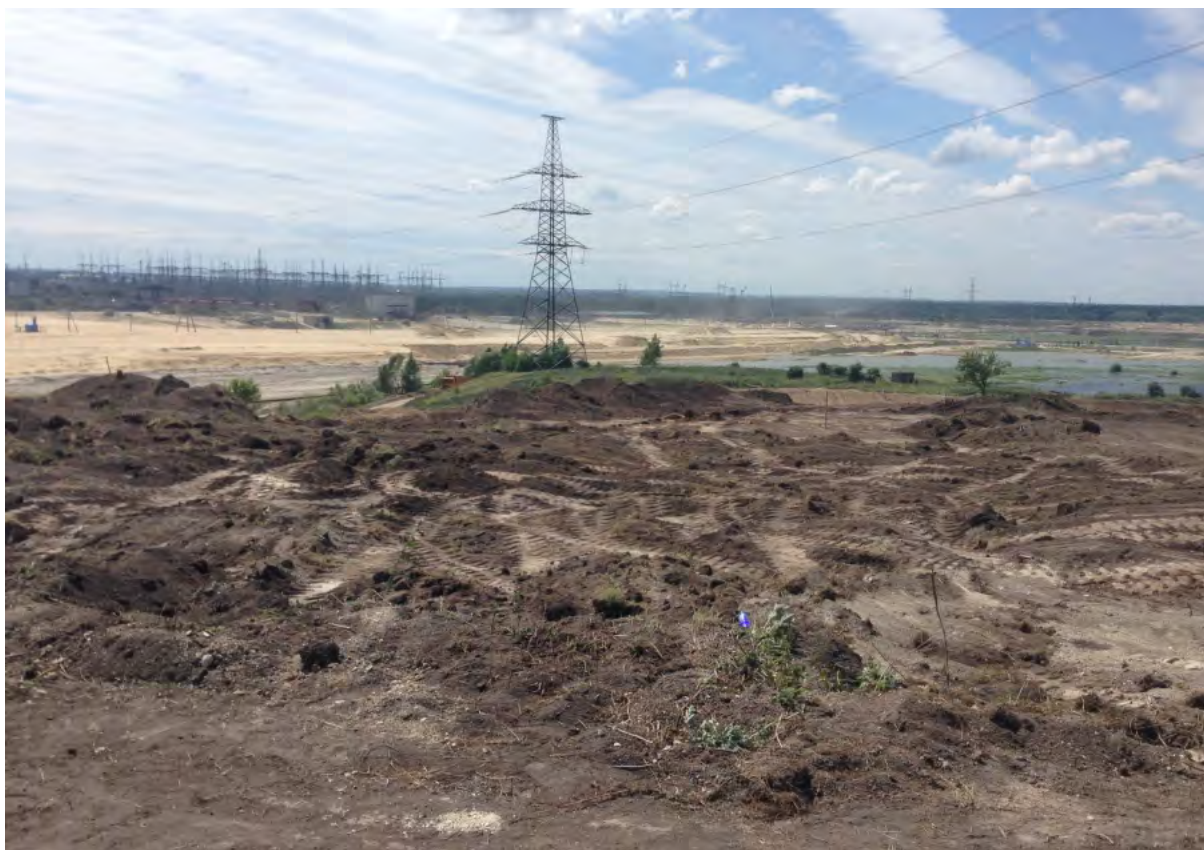
Рис. 95. Место проведения работ перед сдачей заказчику.
