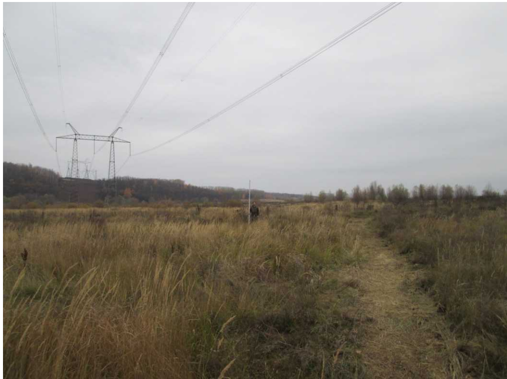
Илл. 33. КРО-2013. Общий вид участков обследования в зоне строительства КАЭС-2. Снимок №26. Участок II очереди. Вид с ЮВ.
