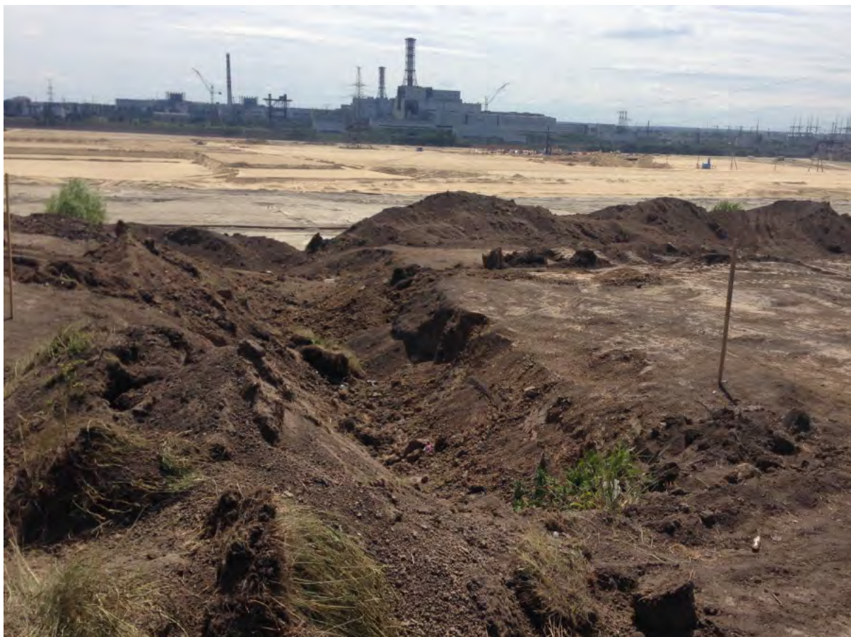
Рис. 96. Место проведения работ перед сдачей заказчику.
