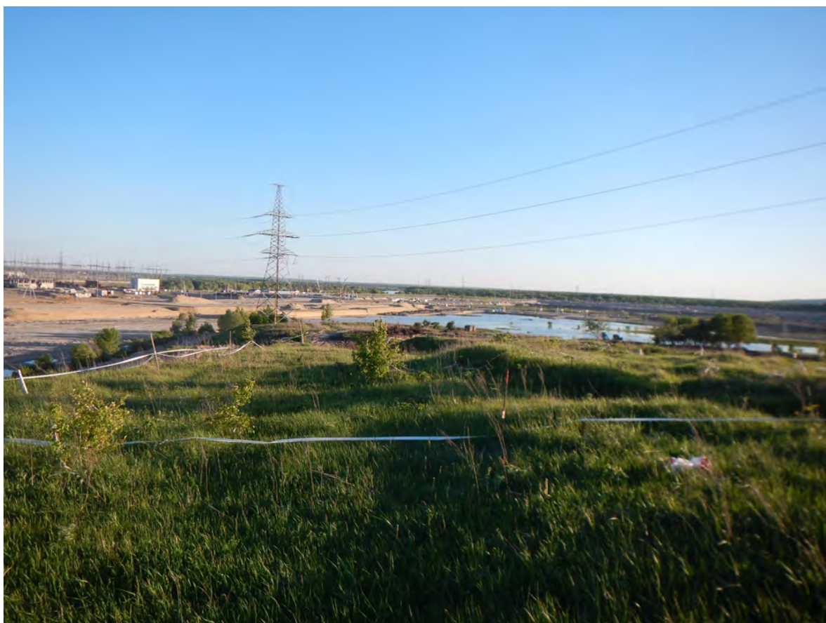
Рис. 15 .Площадка поселения перед началом работ. Вид с севера.
