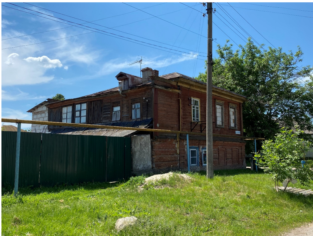
Фотография № 11. Вид с северо-востока на Объект.
