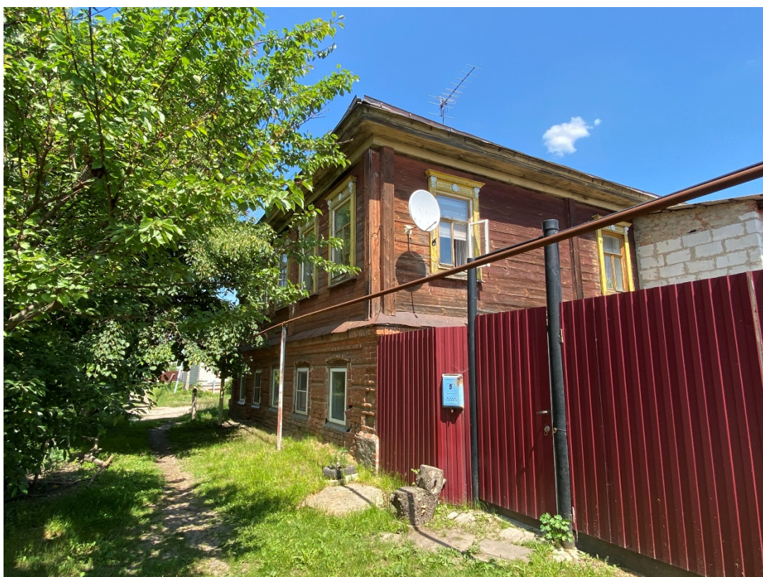
Фотография № 4. Вид с юго-запада на Объект.
