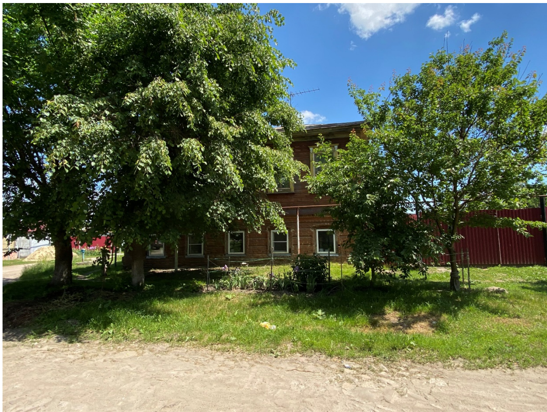
Фотография № 5. Вид с запада на Объект.
