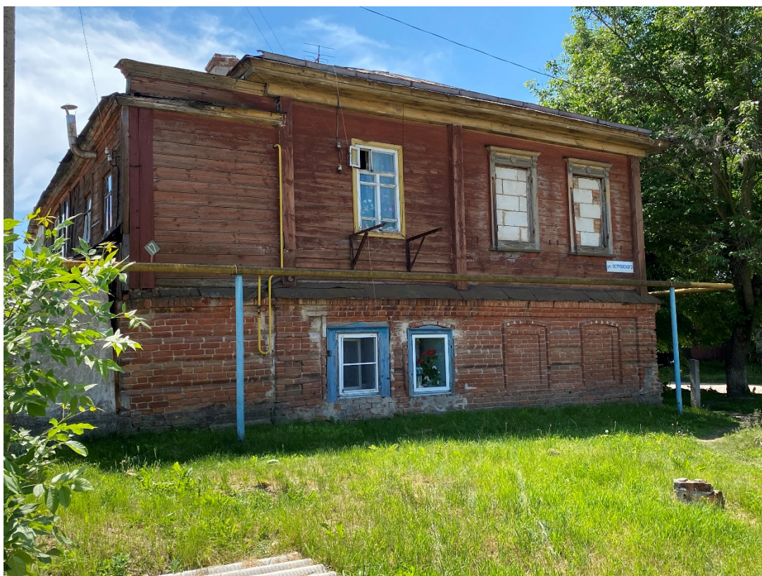
Фотография № 10. Вид с северо-востока на Объект.
