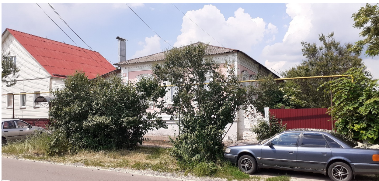
Фотография № 8. Вид с юго-востока на Объект.
