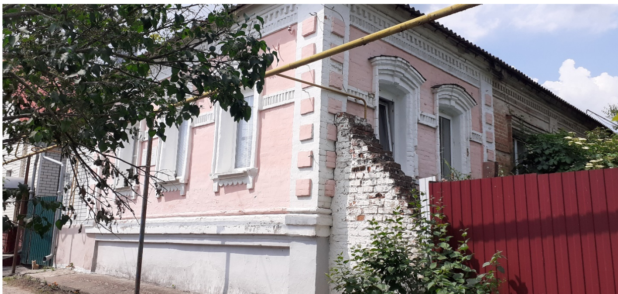
Фотография № 7. Вид с юго-востока на Объект.
