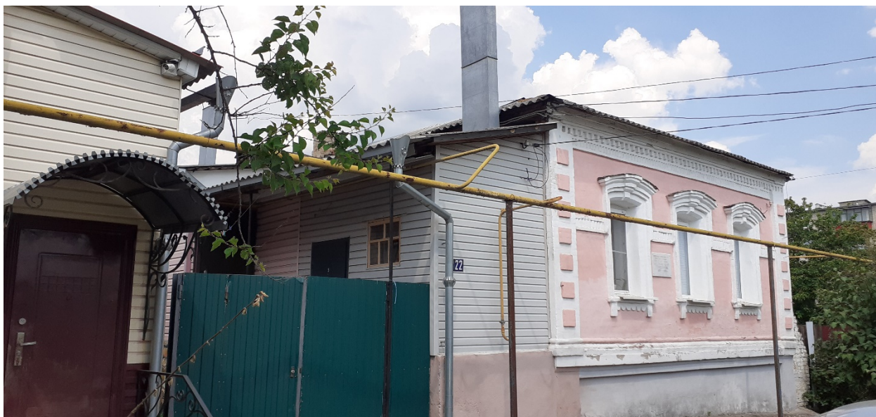
Фотография № 3. Вид с юго-запада на Объект.
