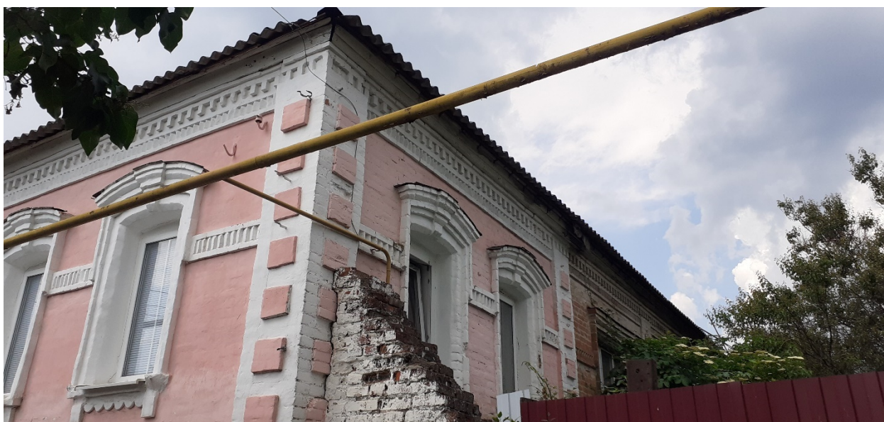
Фотография № 10. Вид с юго-востока на Объект.
