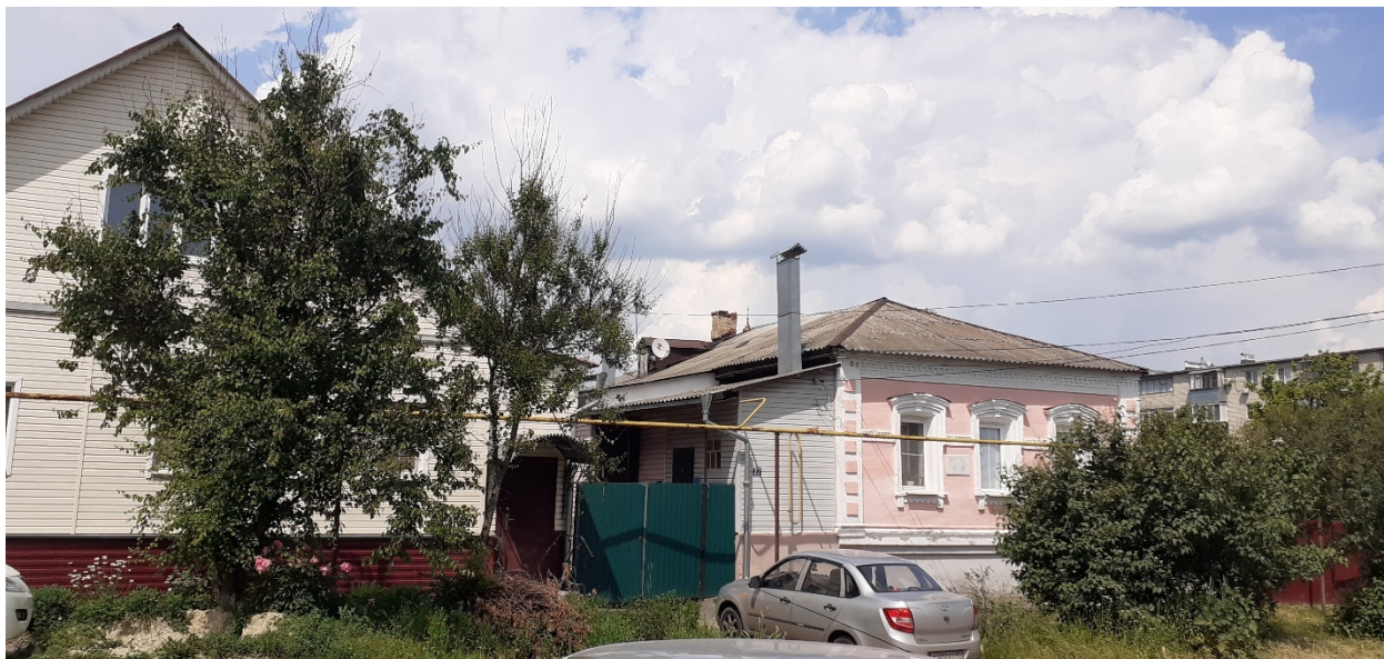
Фотография № 1. Вид с юго-запада на Объект.
