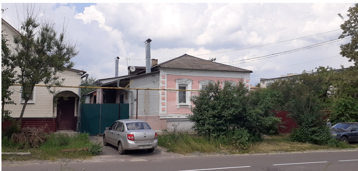
Фотография № 4. Вид с юго-запада на Объект.
