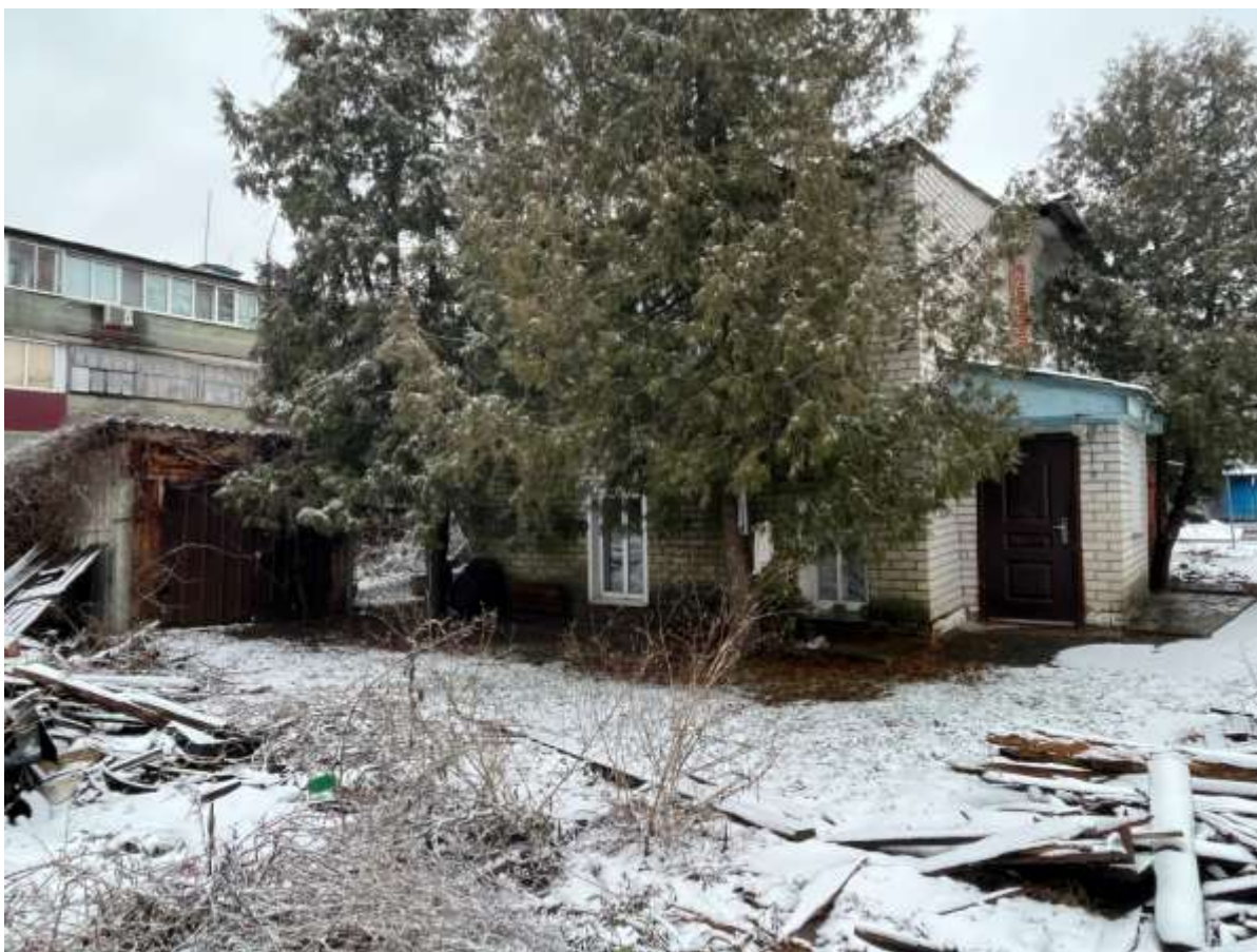
Т.ф. 7. Общий вид дворового фасада Объекта.
