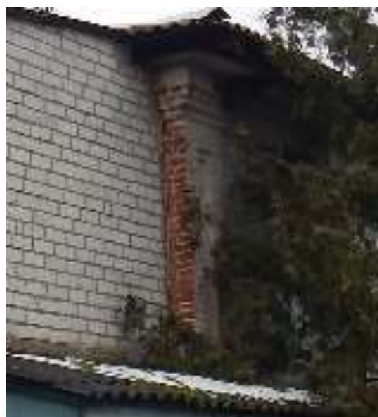
Венчающий карниз и угловая лопатка восточного фасада, перетекающие на северный фасад
