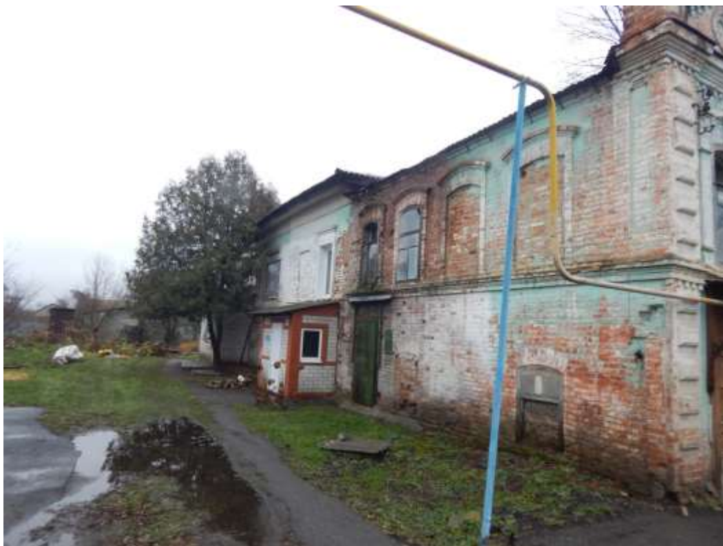
Т.ф. 3. Боковой фасад Объекта со стороны ул. Щепкина.
