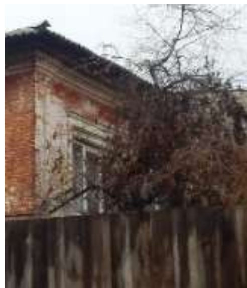
Восточный фасад, оформление оконного проема
