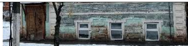
Оформление цокольного этажа
