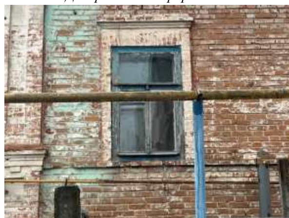
Оформление оконного проема
