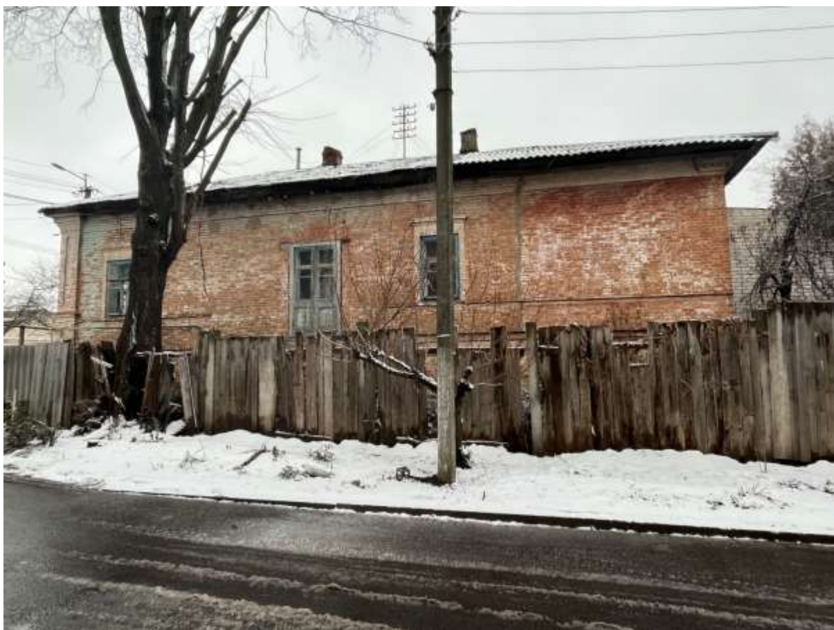
Т.ф. 8. Общий вид бокового фасада Объекта.
