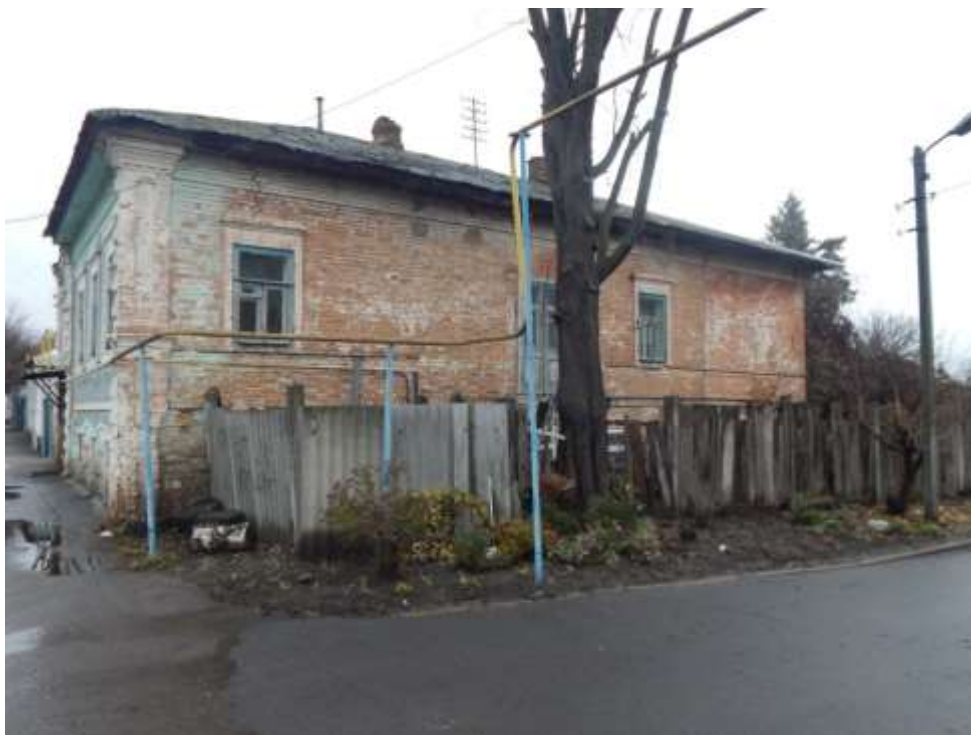
Т.ф. 2. Боковой фасад Объекта со стороны ул. Щепкина.
