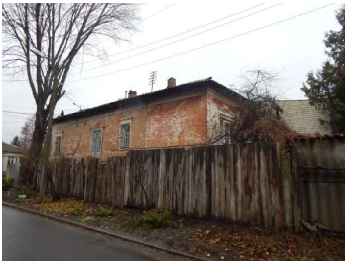
Т.ф. 6. Общий вид бокового фасада Объекта.
