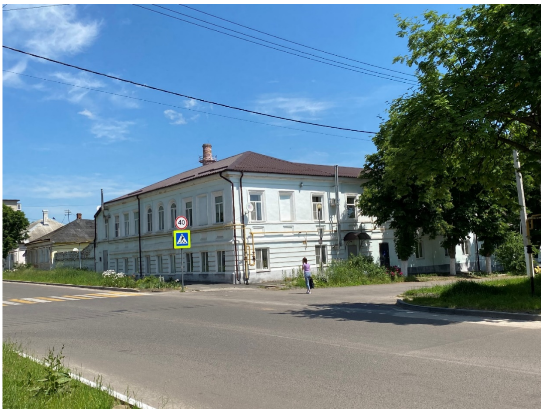
Фотография № 3. Вид с юго-запада на Объект.
