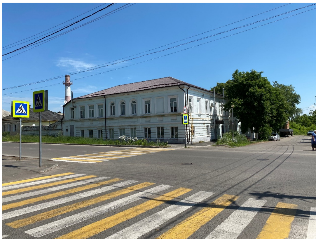
Фотография № 2. Вид с юго-запада на Объект.
