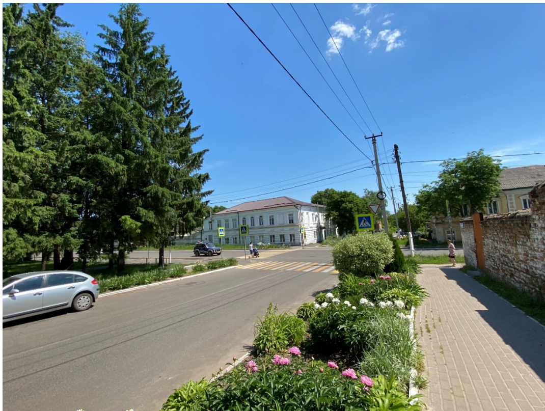
Фотография № 1. Вид с юго-запада на Объект.
