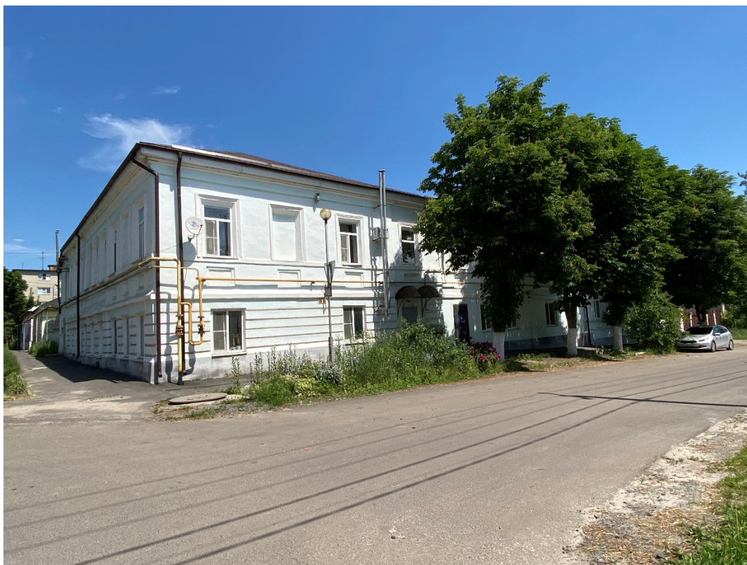
Фотография № 7. Вид с юго-запада на Объект.
