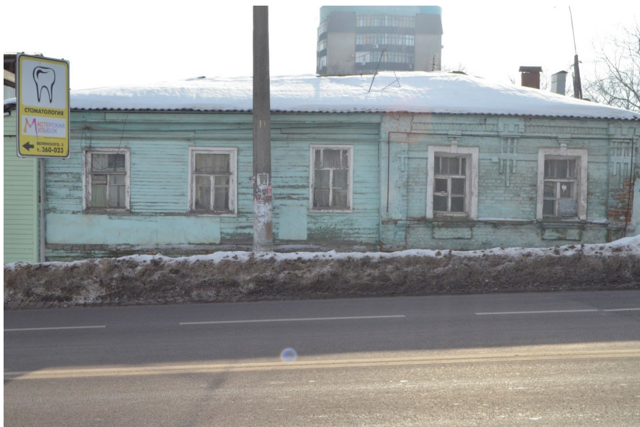
Т.ф. 3. Общий вид с северо-запада на главный фасад Объекта
