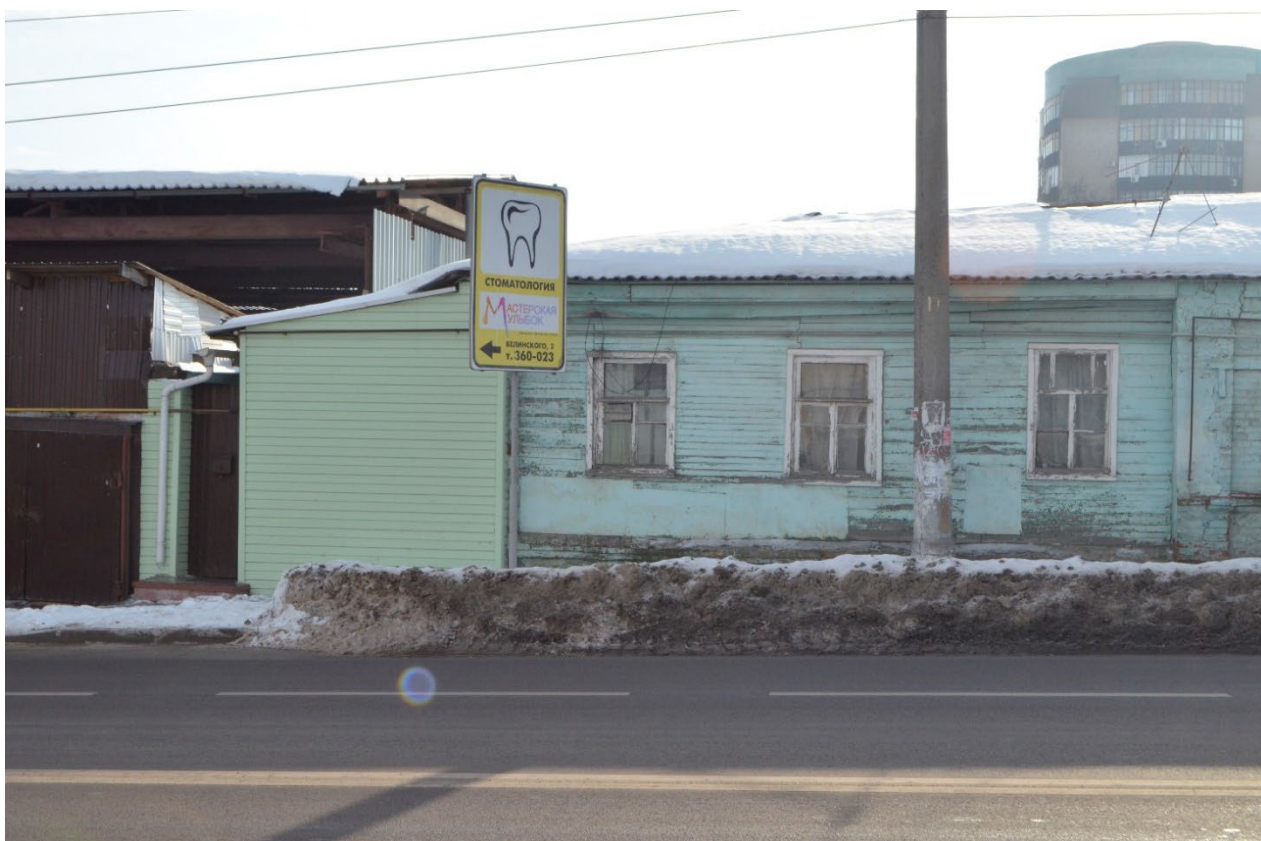
Т.ф. 2. Вид с северо-запада со стороны ул. Красной Армии на главный фасад Объекта
