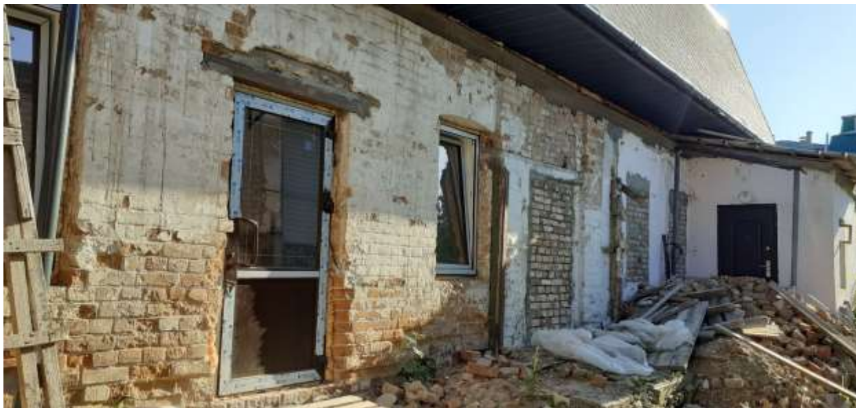
Фотография № 5. Дворовый (северный) фасад Объекта.
