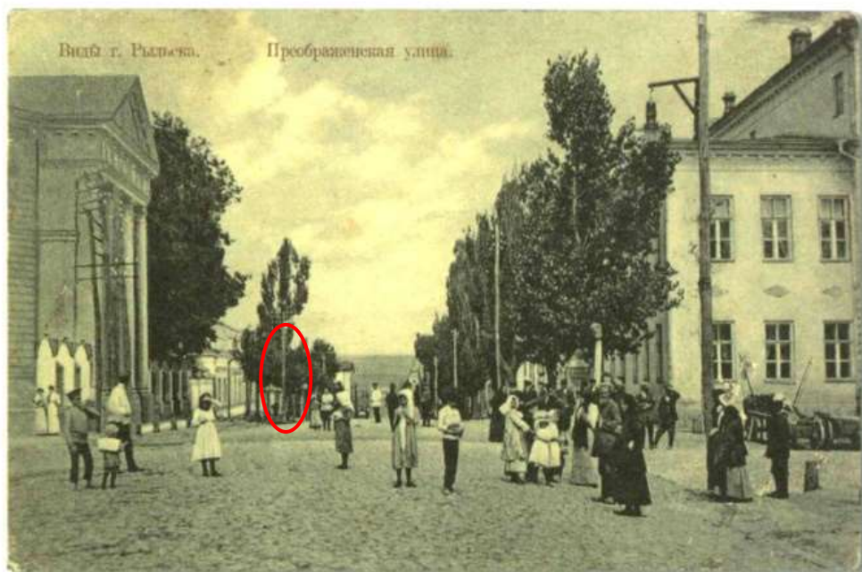
Преображенская улица (ныне — Ленина) в районе пересечения с ул. Выходцевской (ныне — К. Либкнехта). Вид в северном направлении. Слева — придел с колоннами — вход в Покровскую церковь. Справа — двухэтажное здание с надстройкой — еще один дом купцов Филимоновых. Сейчас в этом здании расположены службы районной милиции (ул. Ленина, д. 75).
