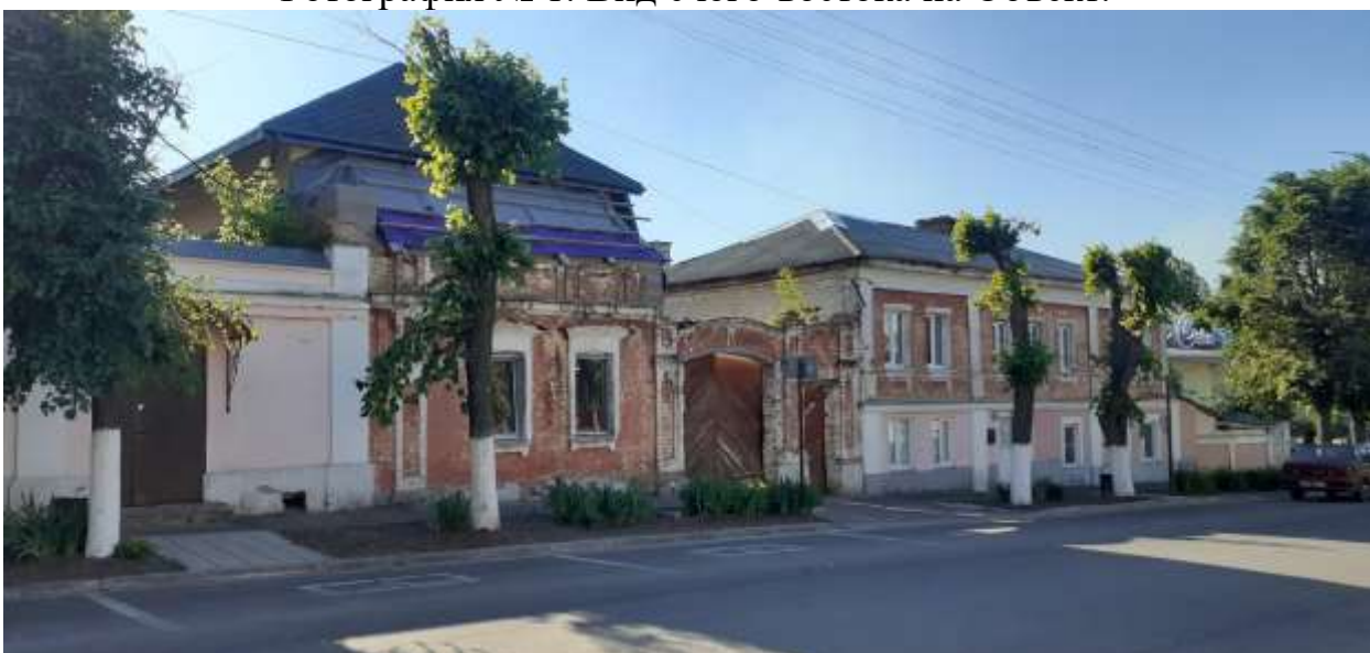
Фотография № 2. Вид с юго-востока на Объект.
