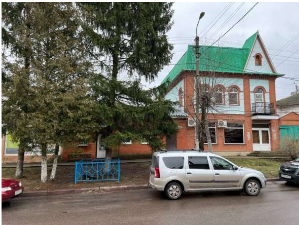
Т.ф. 3. Общий вид фасада Объекта со стороны ул. Розы Люксембург.
