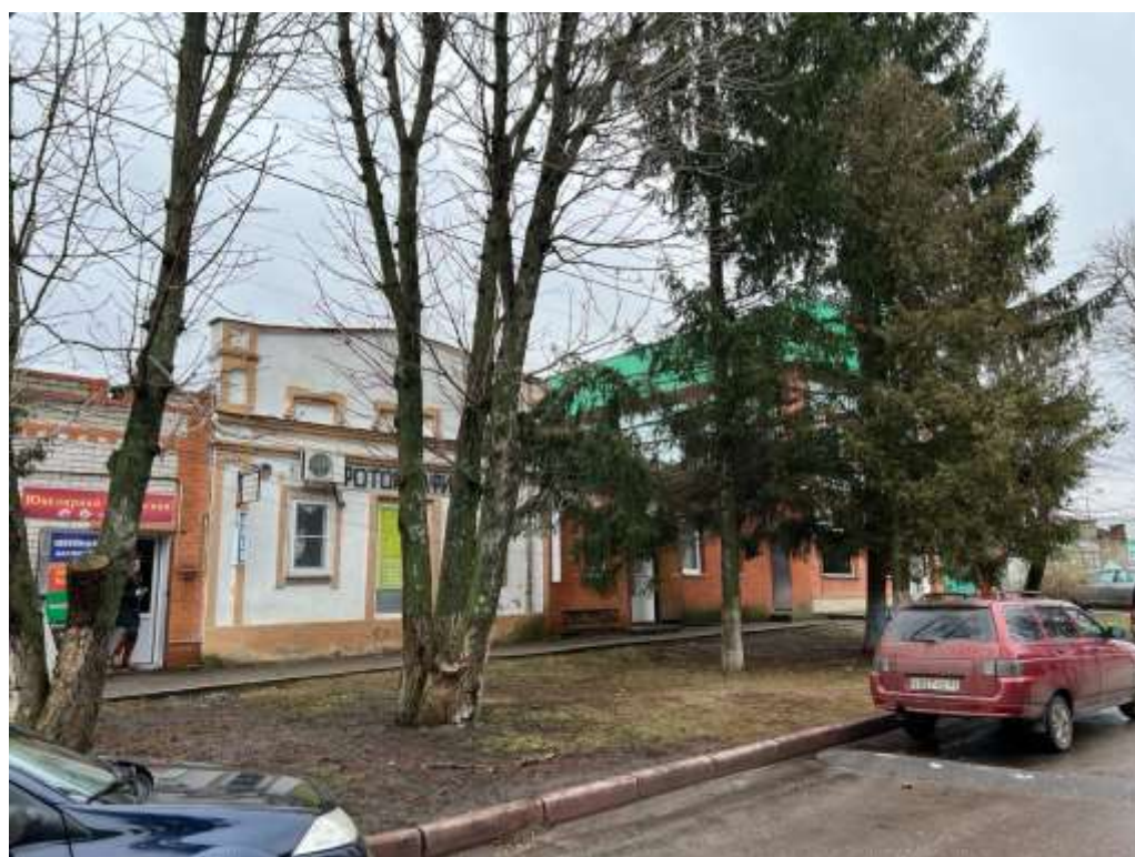
Т.ф. 2. Общий вид фасада Объекта со стороны ул. Розы Люксембург.
