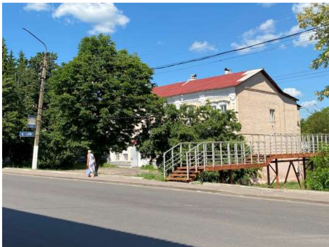
Фотография № 2. Вид с юго-запада на Объект.
