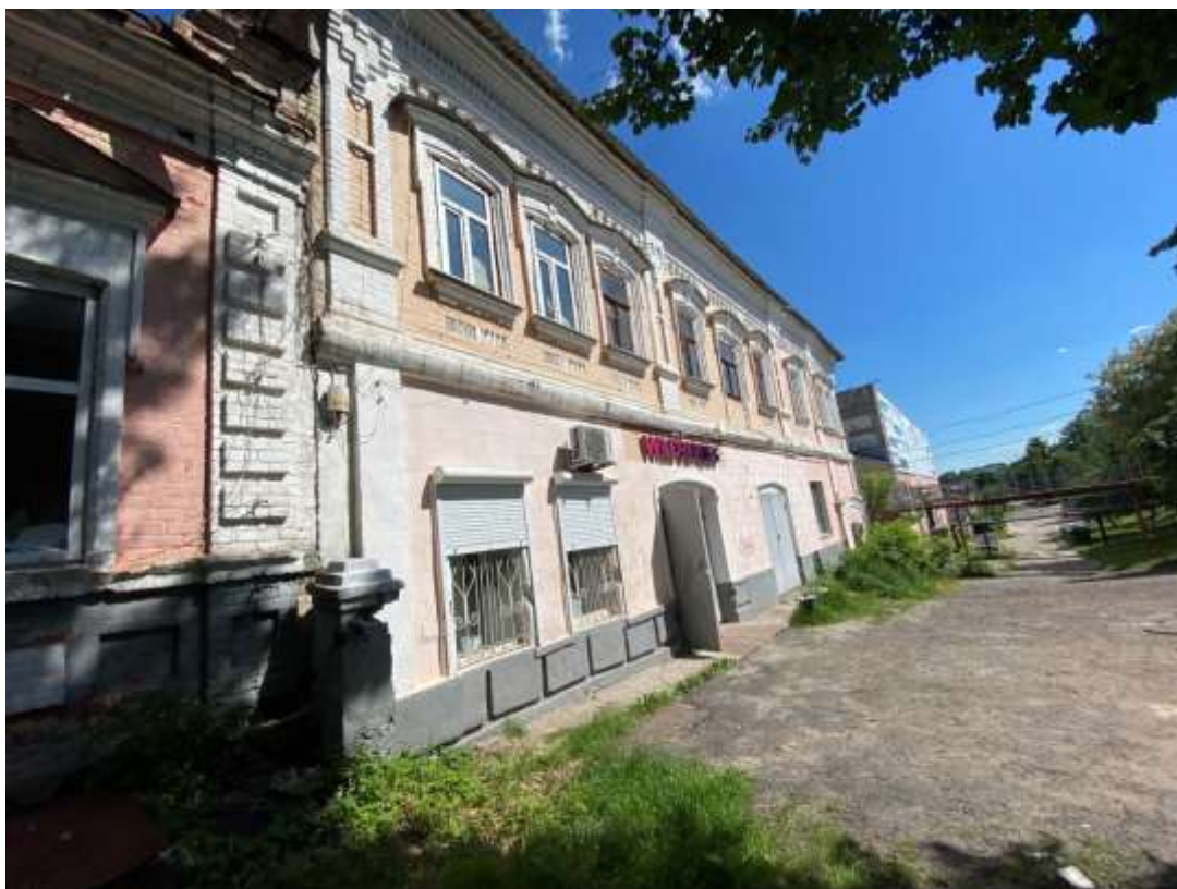
Фотография № 9. Вид с севера на Объект.
