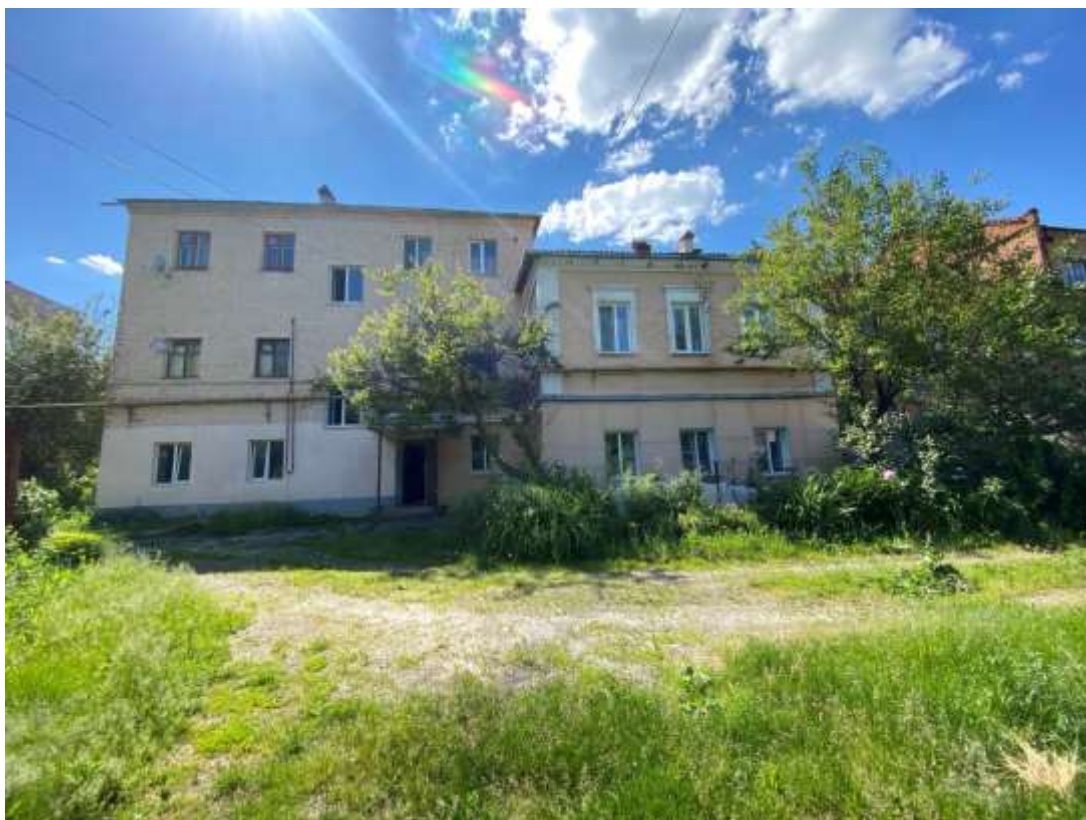
Фотография № 5. Вид с востока на Объект.
