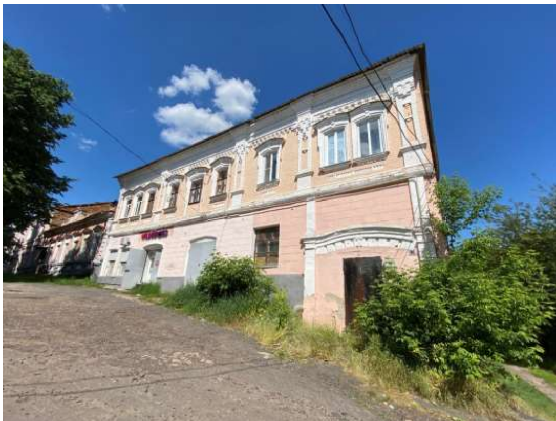
Фотография № 6. Вид с юго-запада на Объект.
