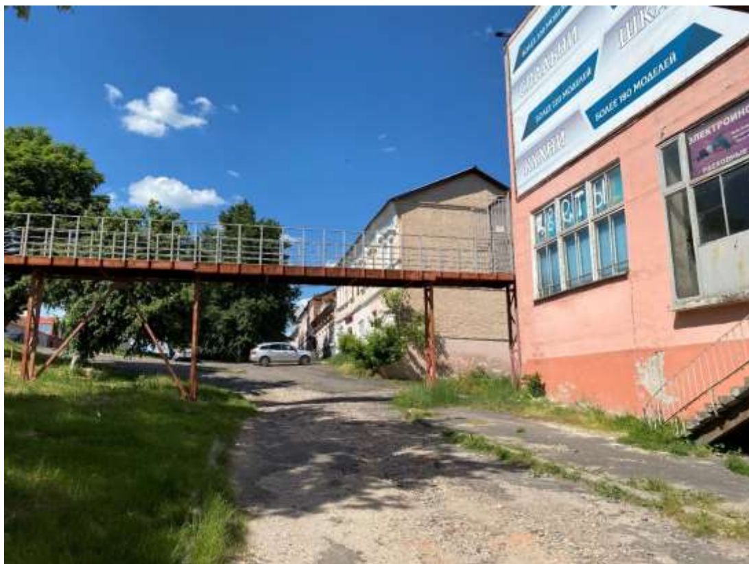
Фотография № 1. Вид с юга на Объект.
