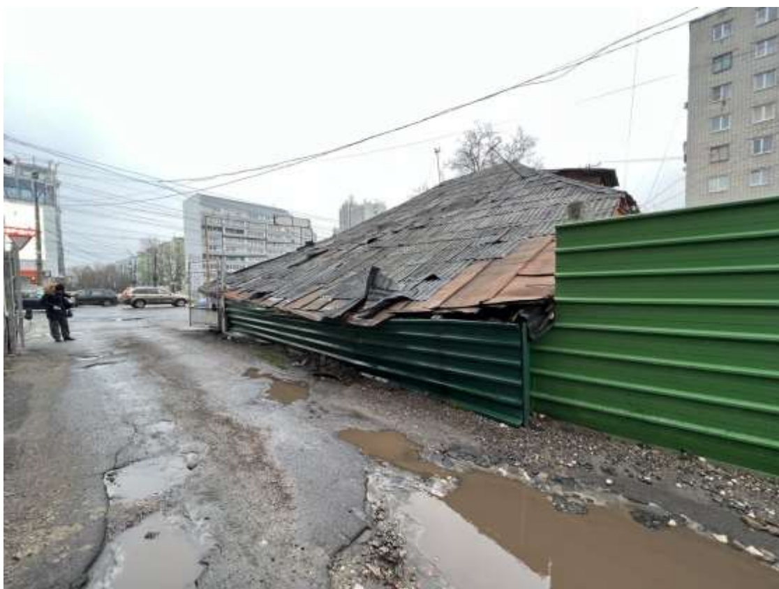
Фотография № 14. Вид с северо-запада на Объект.
