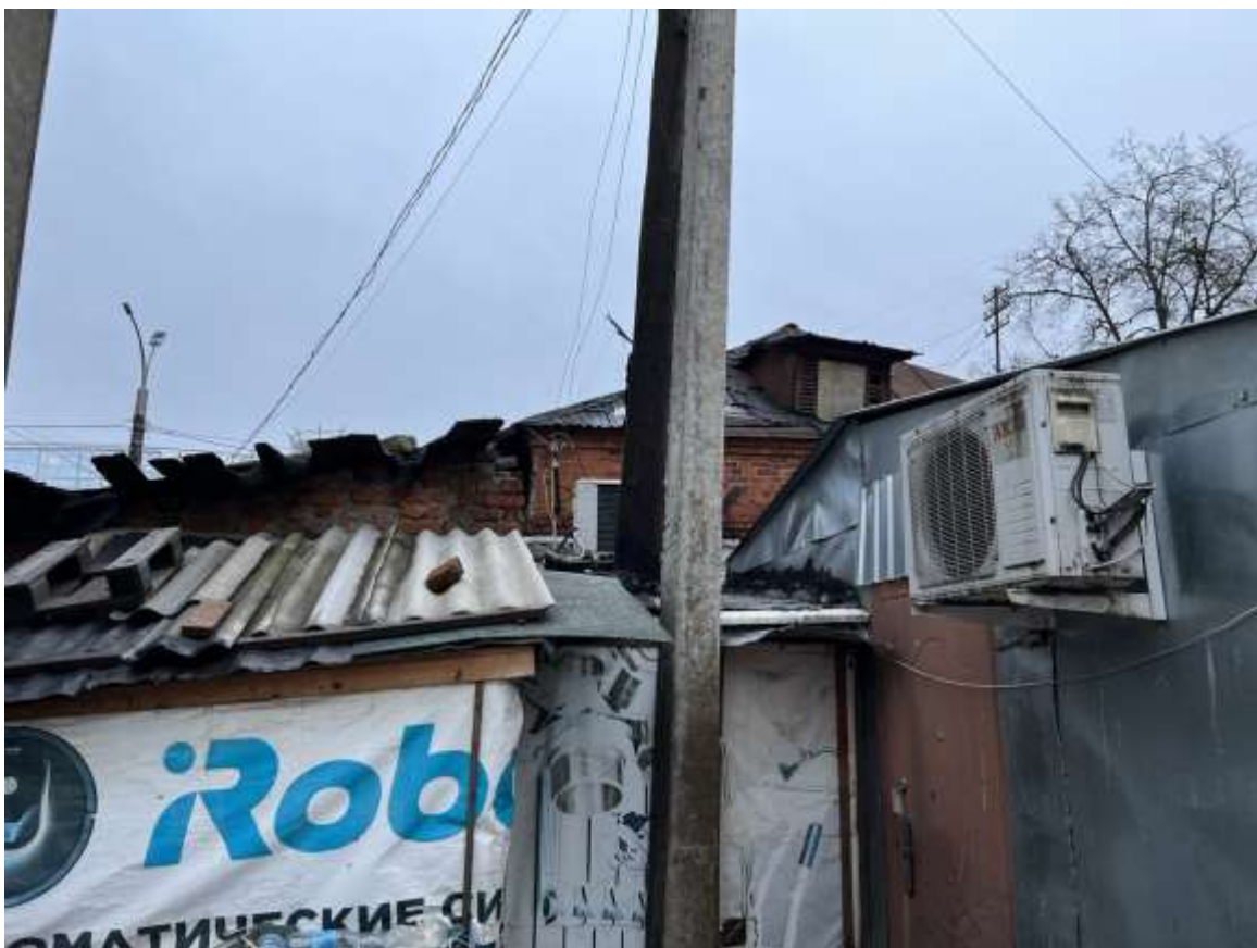
Фотография № 12. Вид с северо-запада на Объект.
