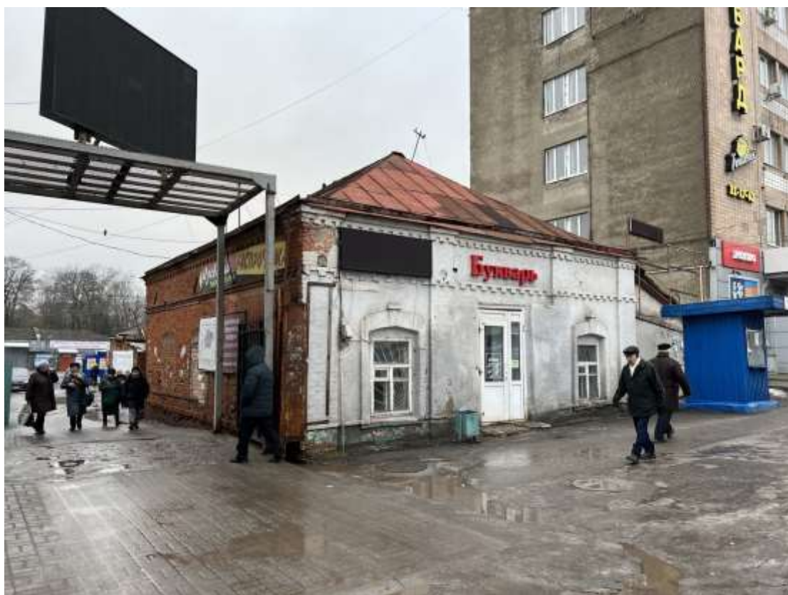
Фотография № 4. Вид с юго-востока на Объект.
