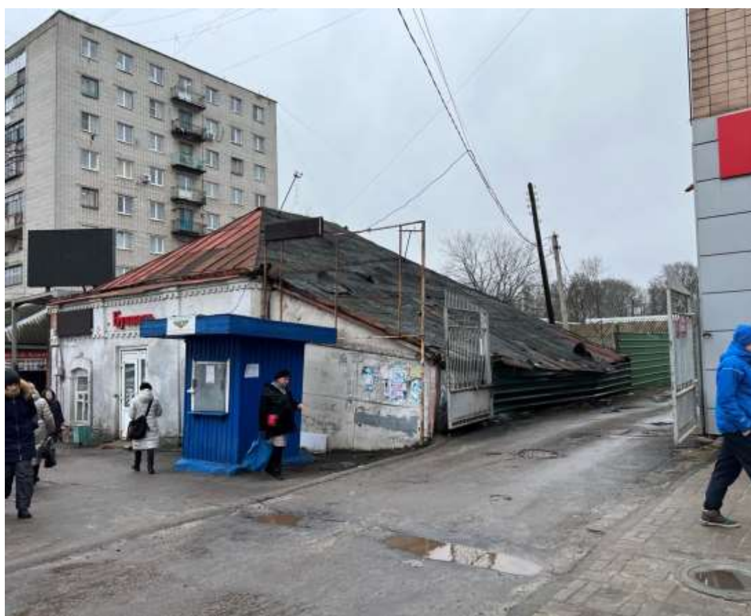
Фотография № 16. Вид с северо-востока на Объект.
