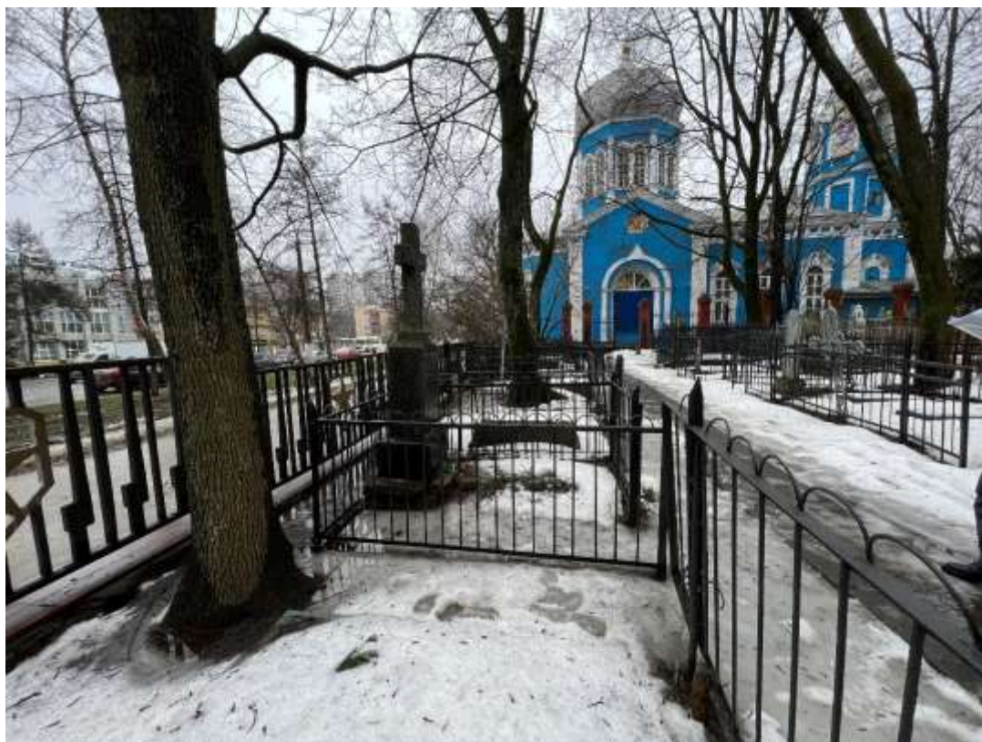
Фотография № 6. Вид с северо-запада на Объект.
