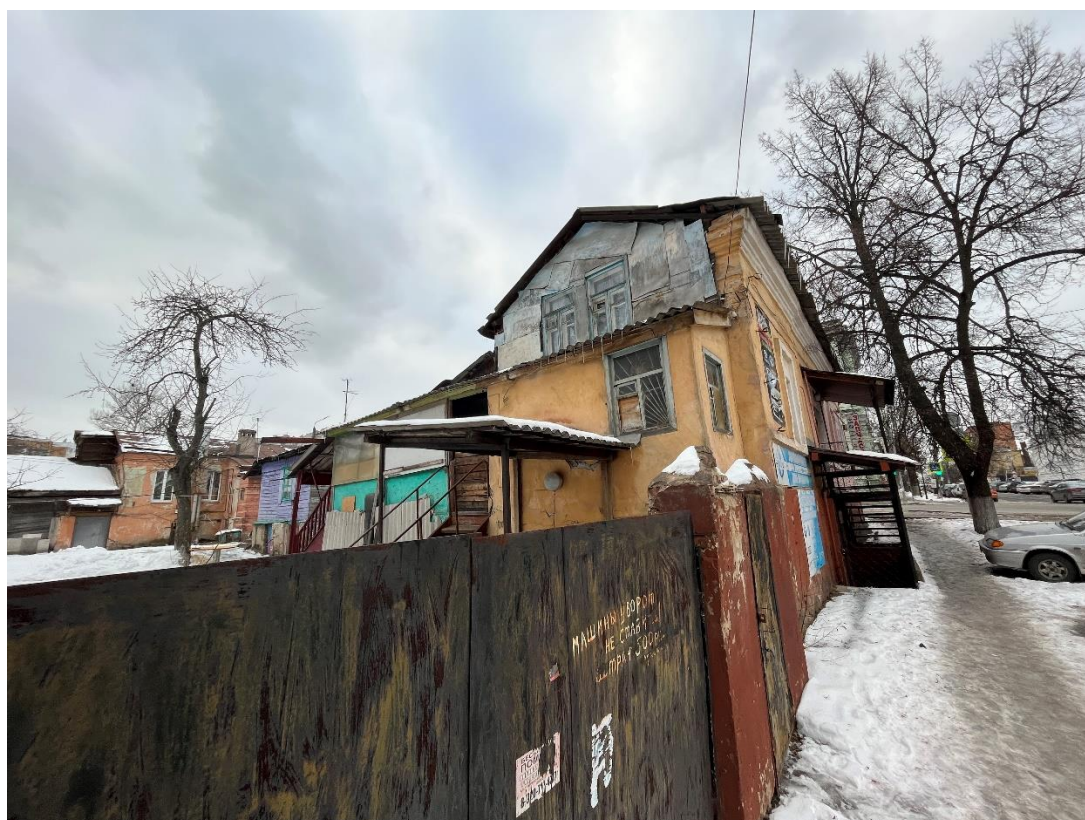
Фотография № 6. Вид с юго-востока на Объект.
