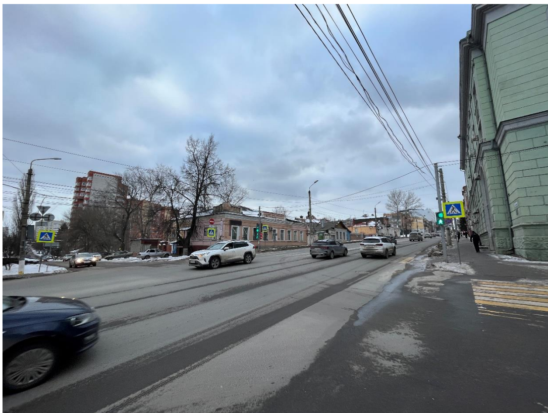
Фотография № 1. Вид с северо-востока на Объект.
