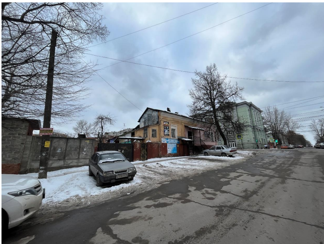
Фотография № 7. Вид с юго-востока на Объект.
