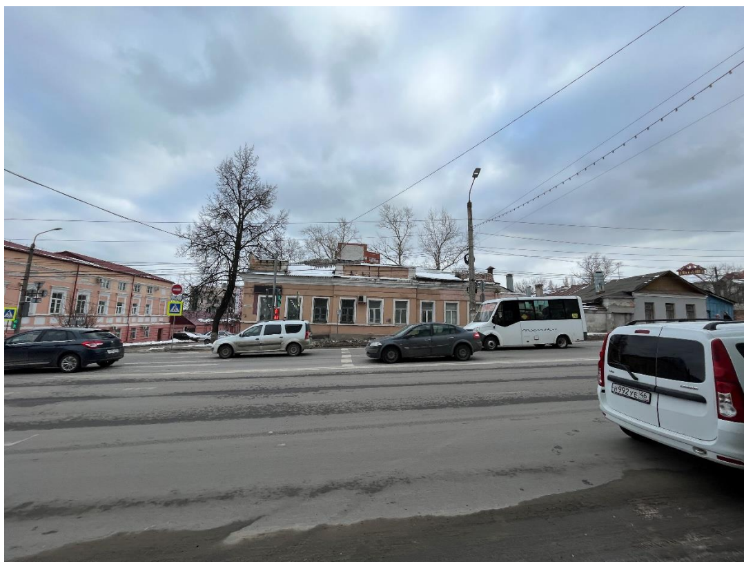
Фотография № 9. Вид с северо-запада на Объект.
