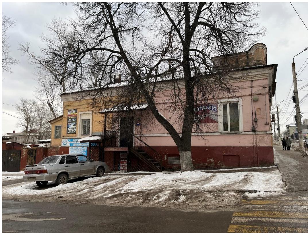
Фотография № 4. Вид с северо-востока на Объект.
