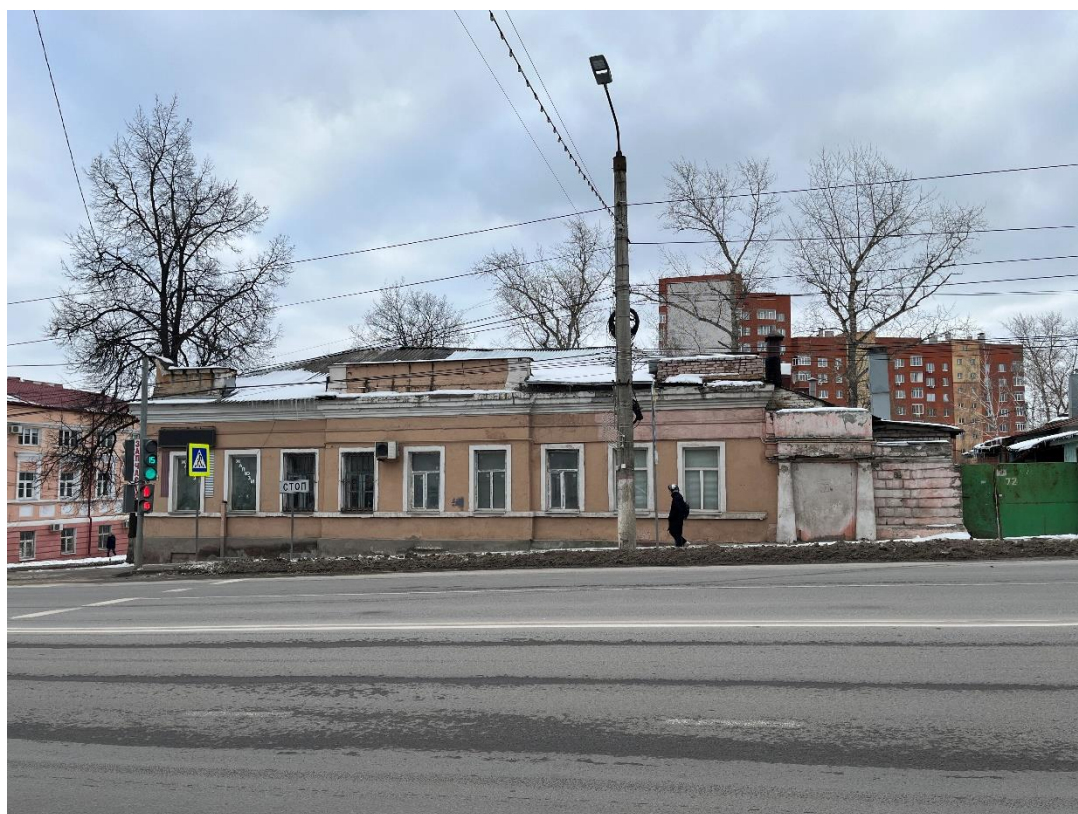
Фотография № 8. Вид с северо-запада на Объект.
