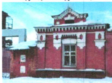
Вид на «Сторожка с приемным покоем», начало XX в. (г. Курск, ул. Халтурина, 16)
