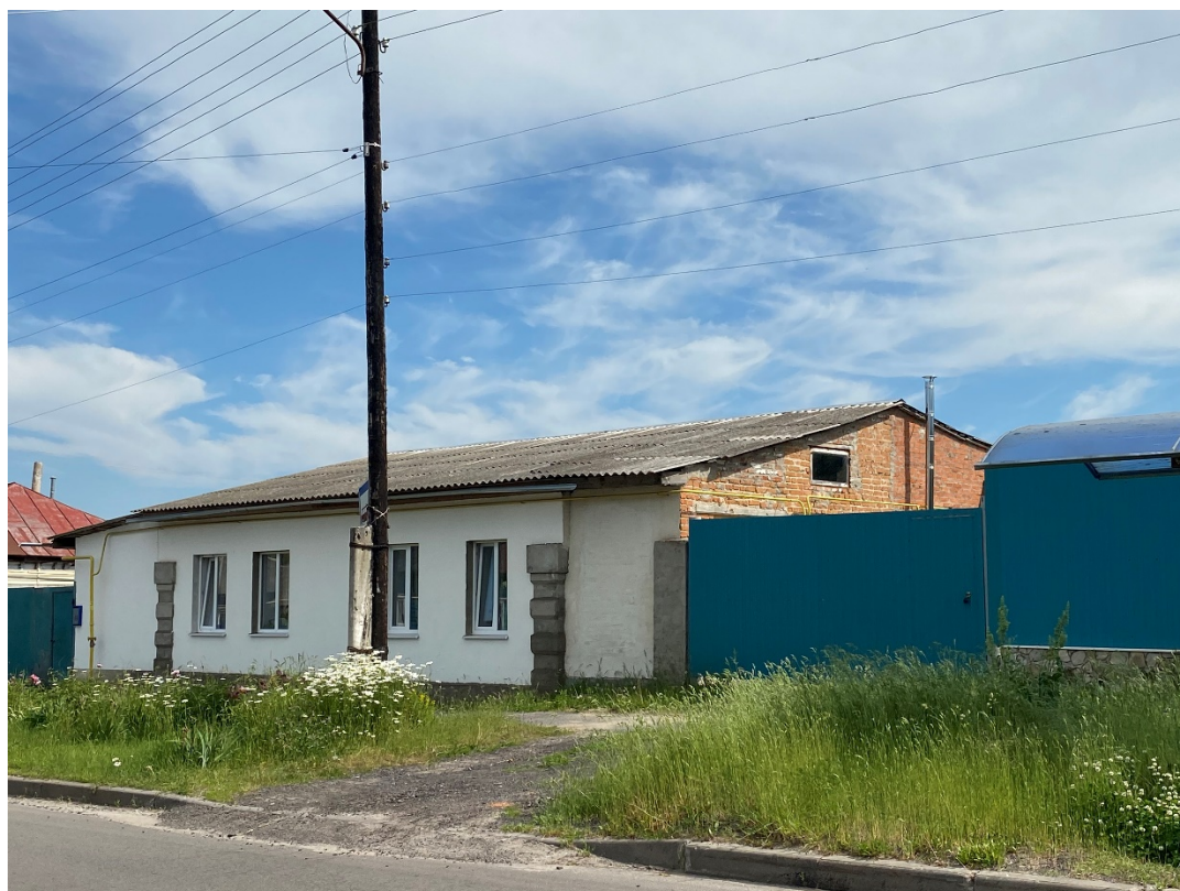
Фотография № 4. Вид с северо-запада на Объект.
