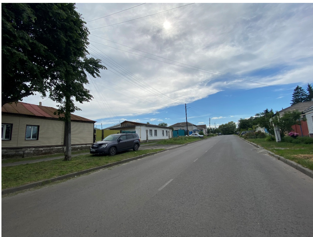
Фотография № 10. Вид с северо-востока на Объект.
