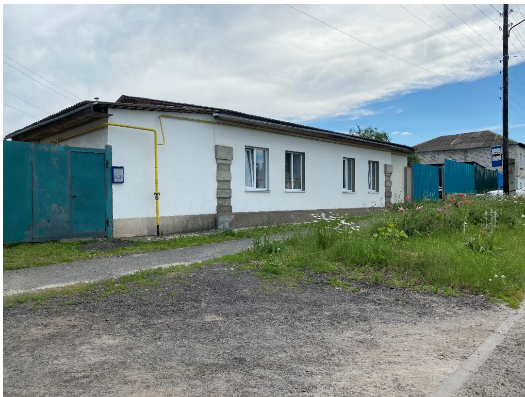
Фотография № 7. Вид с северо-востока на Объект.
