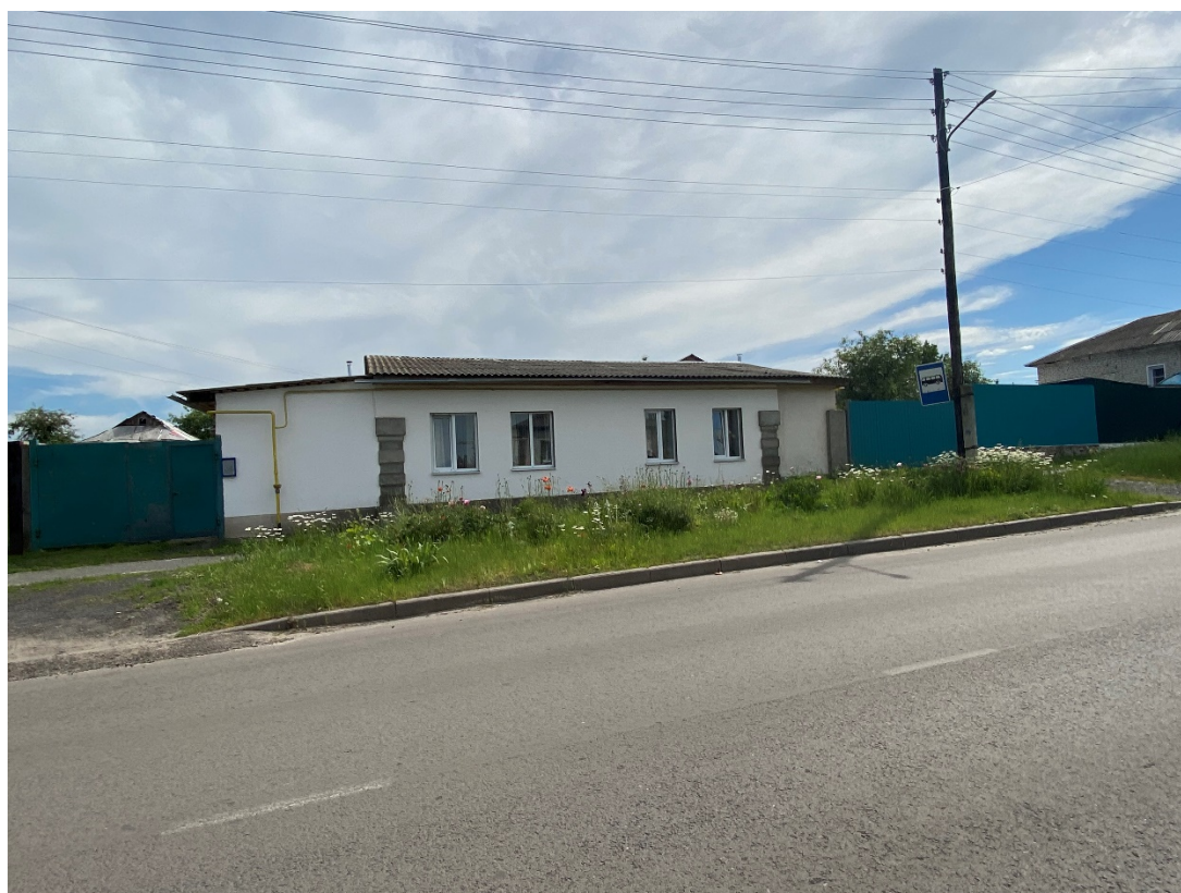
Фотография № 8. Вид с северо-востока на Объект.
