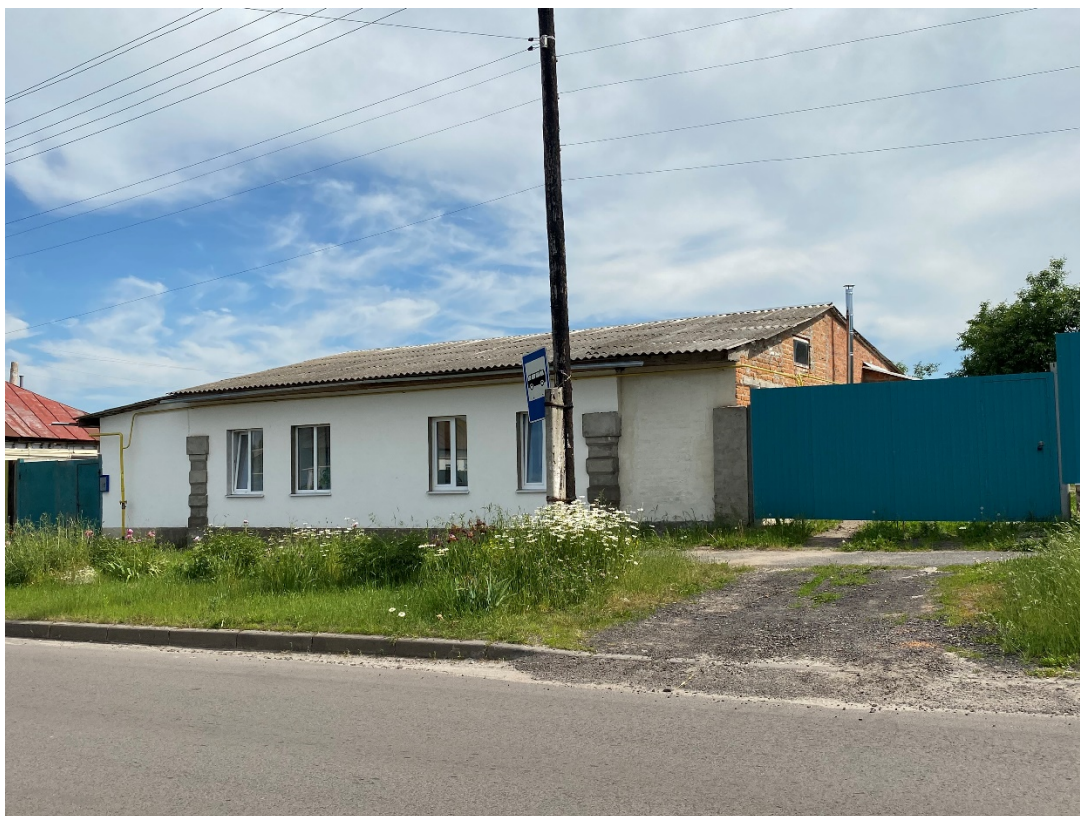
Фотография № 5. Вид с северо-запада на Объект.
