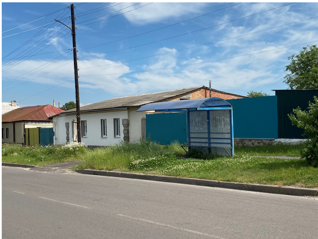
Фотография № 3. Вид с северо-запада на Объект.
