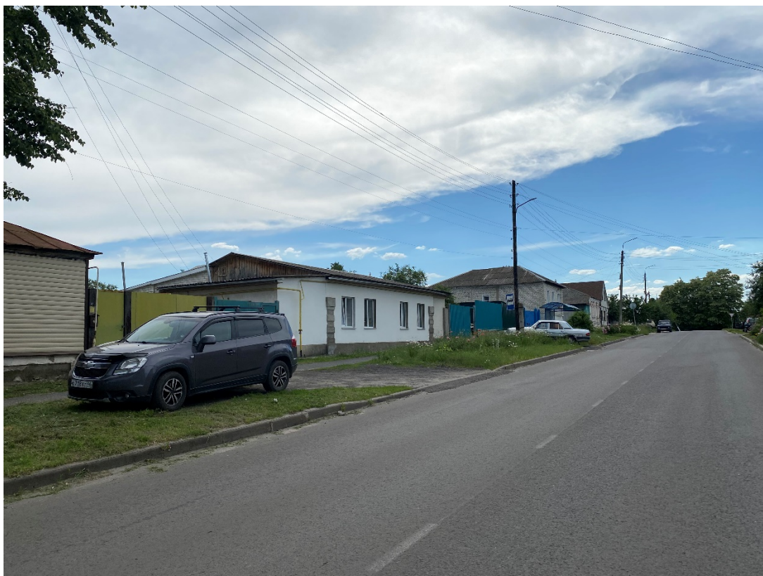
Фотография № 9. Вид с северо-востока на Объект.
