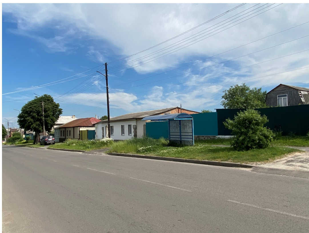
Фотография № 2. Вид с северо-запада на Объект.
