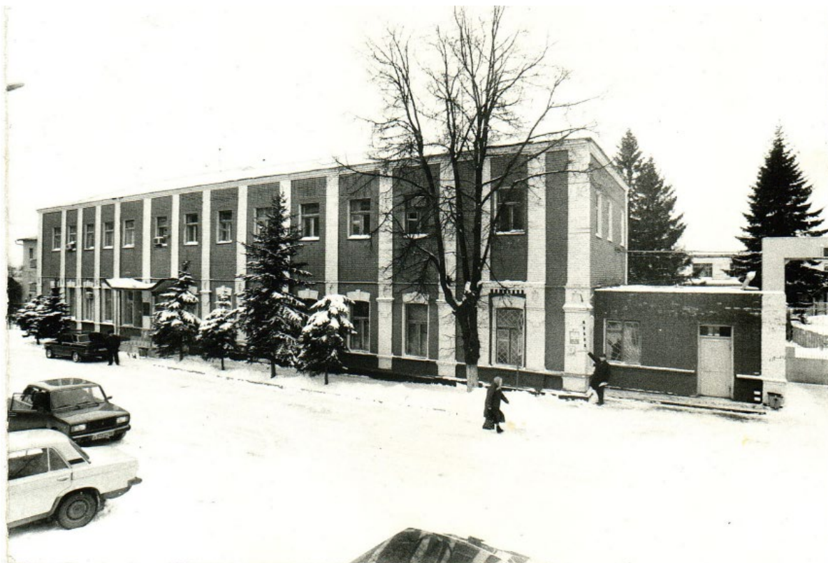
28. Вид на административный корпус № 2 Ликеро-водочного завода (ул. Халтурина, 16). Фотография, ок. 1980-х гг.
