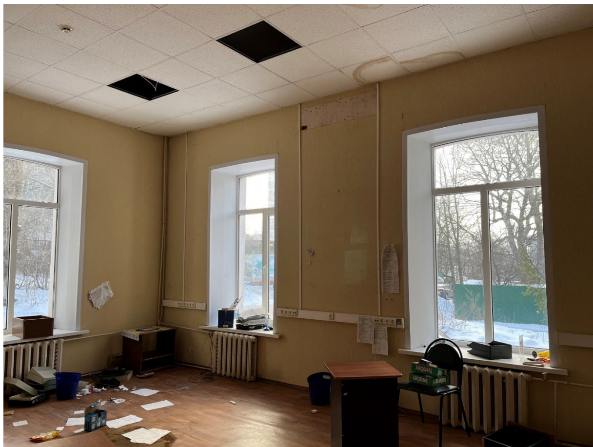
Т.ф. 12. Вид внутреннего помещения Объекта
