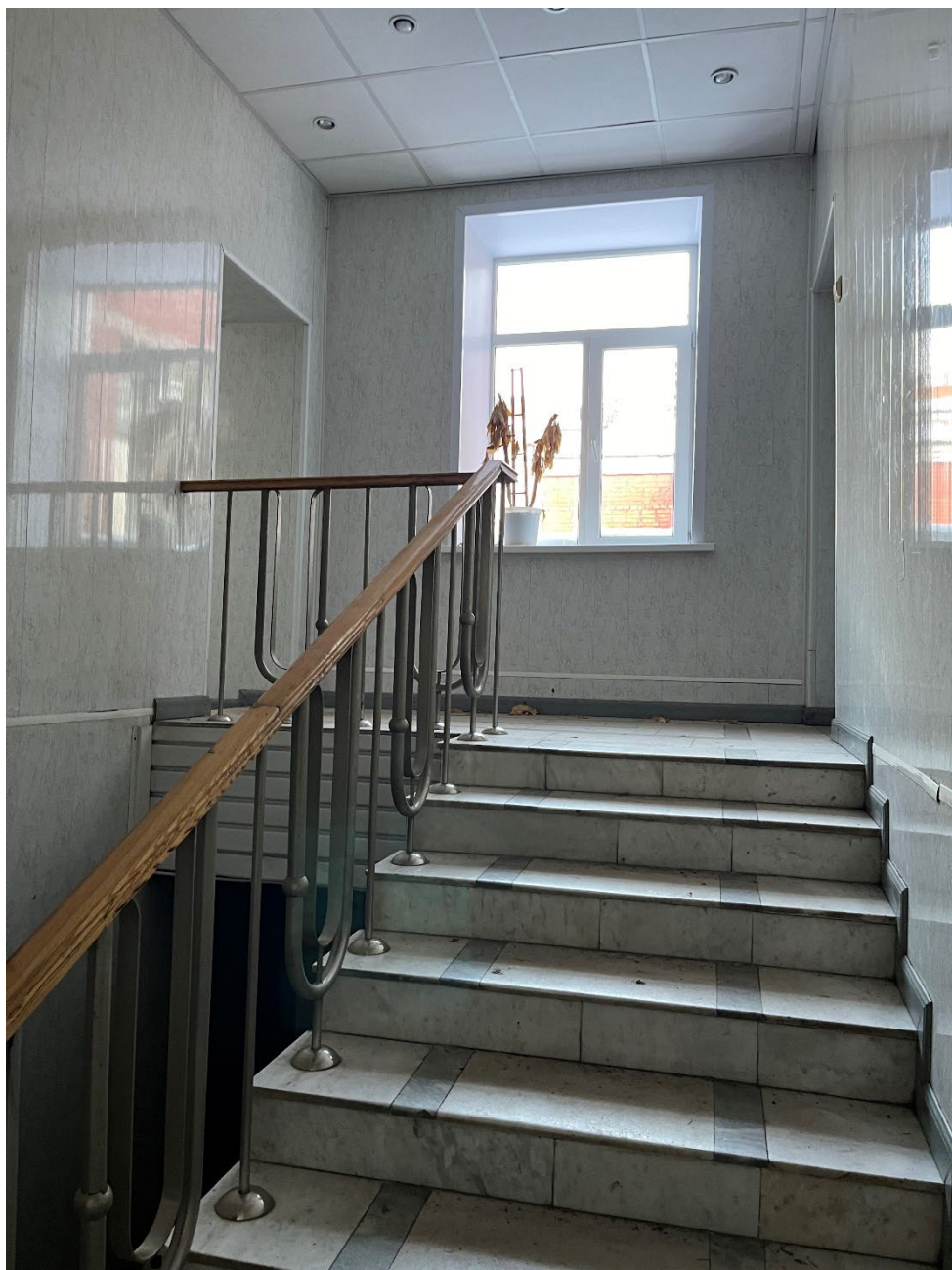
Т.ф. 16. Вид внутреннего помещения Объекта
