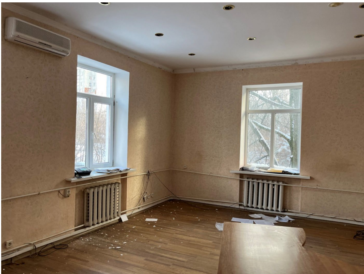
Т.ф. 20. Вид внутреннего помещения Объекта
