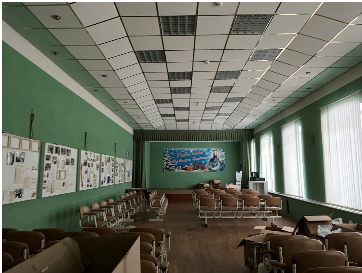
Т.ф. 10. Вид внутреннего помещения Объекта
