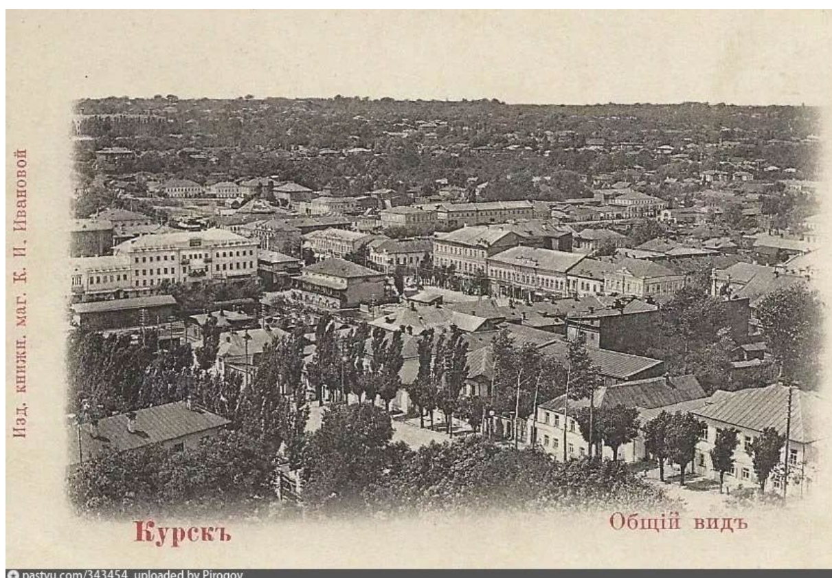
19. Курск. Общий вид. Начало XX в. Направление съемки: запад.
