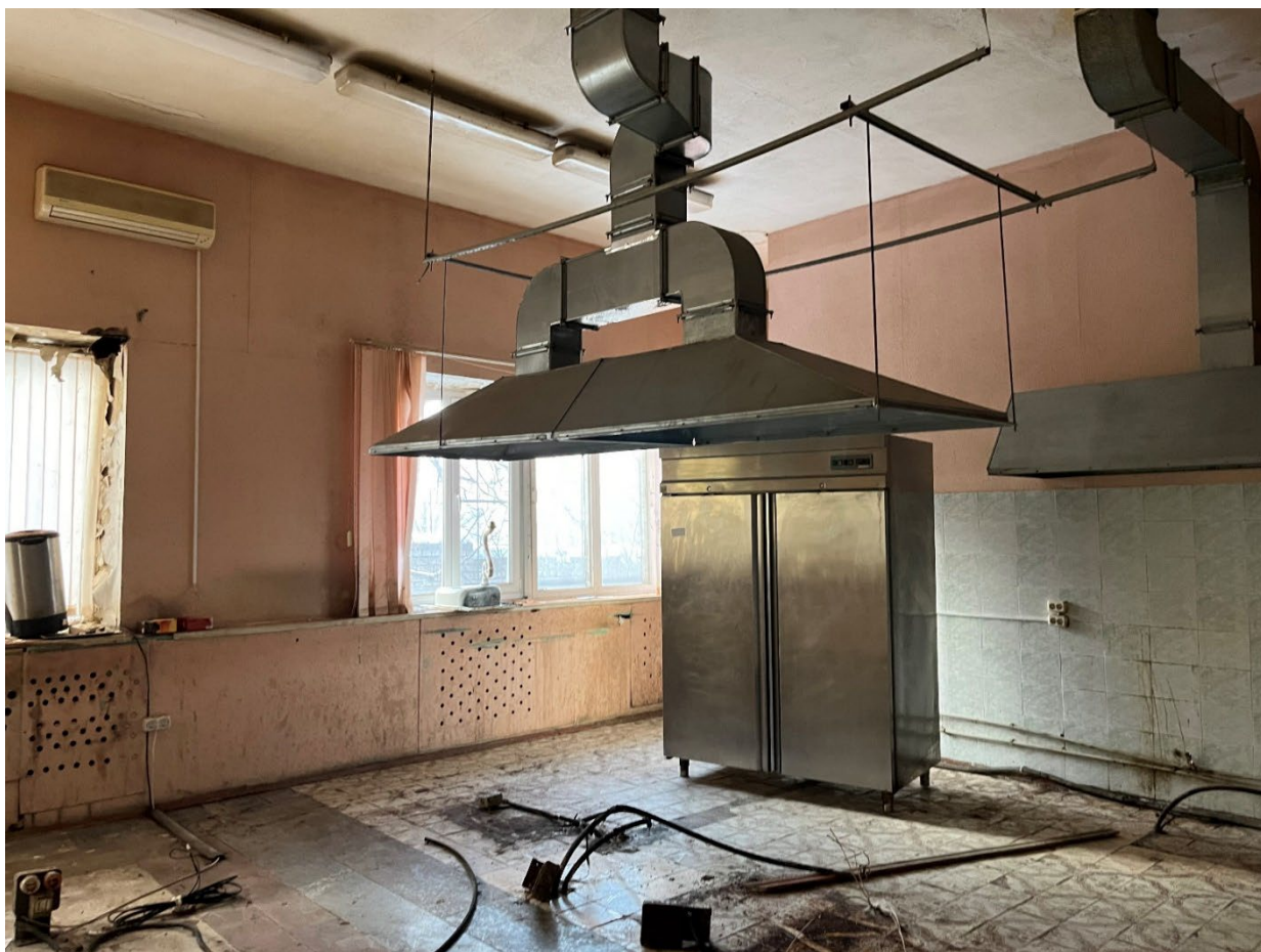
Т.ф. 28. Вид внутреннего помещения Объекта
