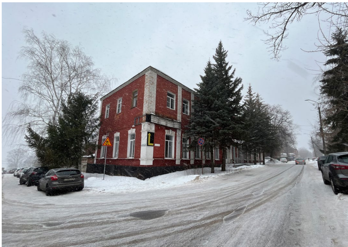
Выявленный объект культурного наследия «Административный корпус-2», 1904 г., расположенный по адресу: Курская область, г. Курск, ул. Халтурина, 16, входящий в состав выявленного объекта культурного наследия «Ансамбль спиртзавода Сперанского», 1904 г., расположенного по адресу: Курская область, г. Курск, ул. Халтурина, 16.
