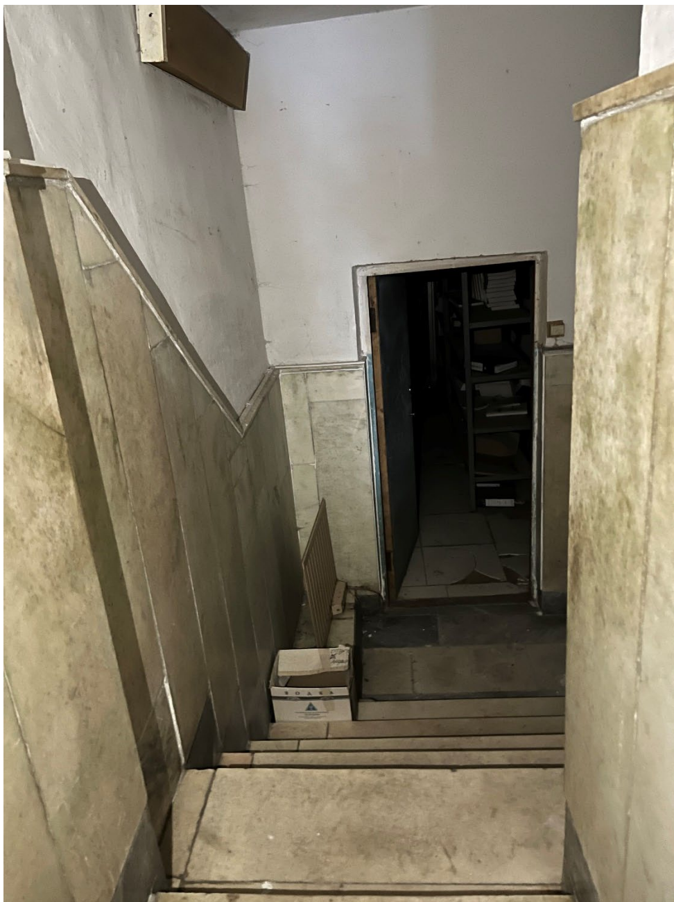
Т.ф. 14. Вид внутреннего помещения Объекта
