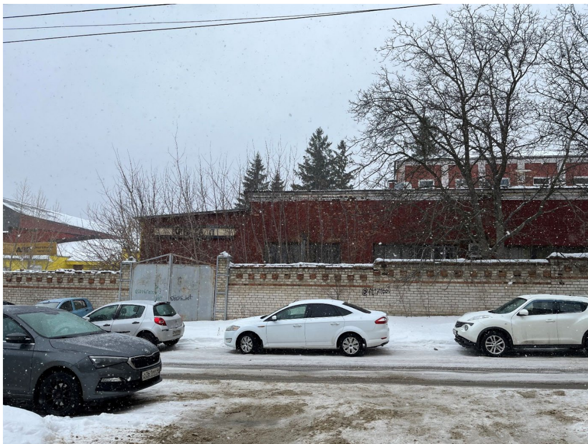
Т.ф. 8. Общий вид на Объект
